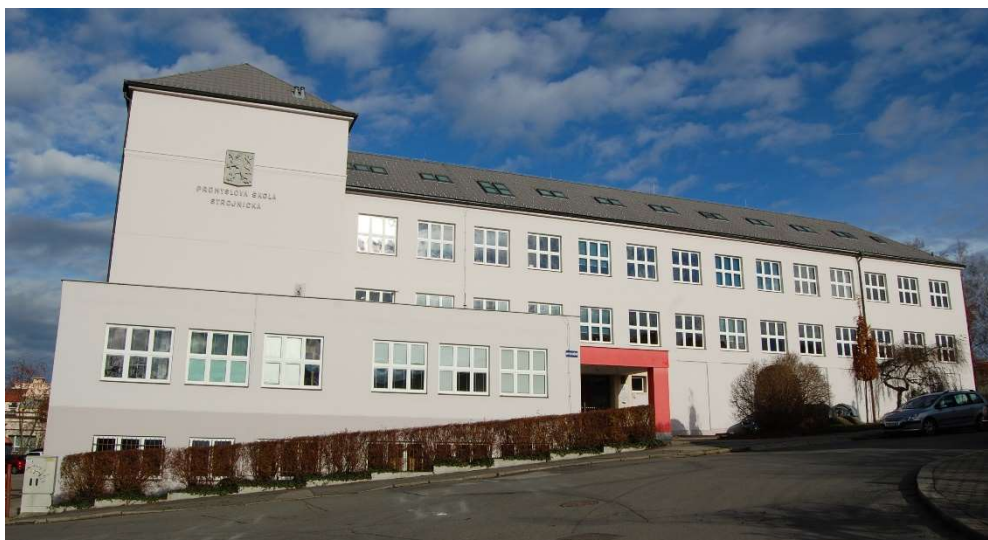
Obr. 42: Jižní pohled na posuzovanou budovu
