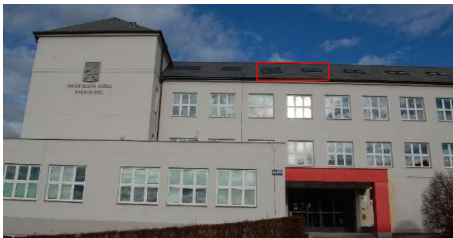
Obr. 50: Pohled na osvětlovací otvory z jižní strany
