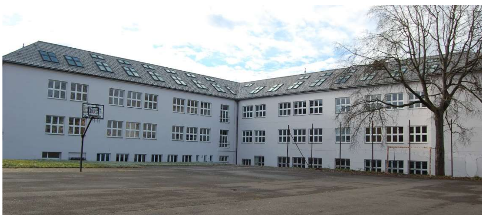
Obr. 43: Severní a východní pohled na posuzovanou budovu
