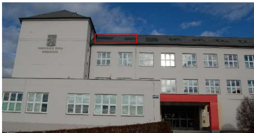
Obr. 60: Pohled na osvětlovací otvory z jižní strany
