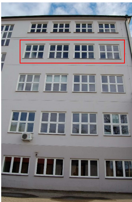
Obr. 55: Pohled na osvětlovací otvory ze západní strany
