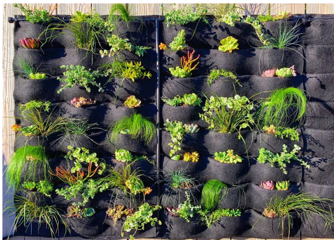
Obrázek 9 Živá stěna – systém plstěných vaků [31]
