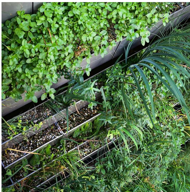
Obrázek 12 Fasádní kořenová čistírna – nerezové kazety, Slavkov u Brna [11]
