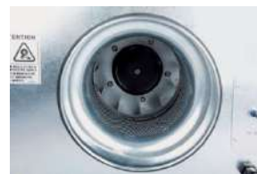
zvuková izolace na sání ventilátoru
