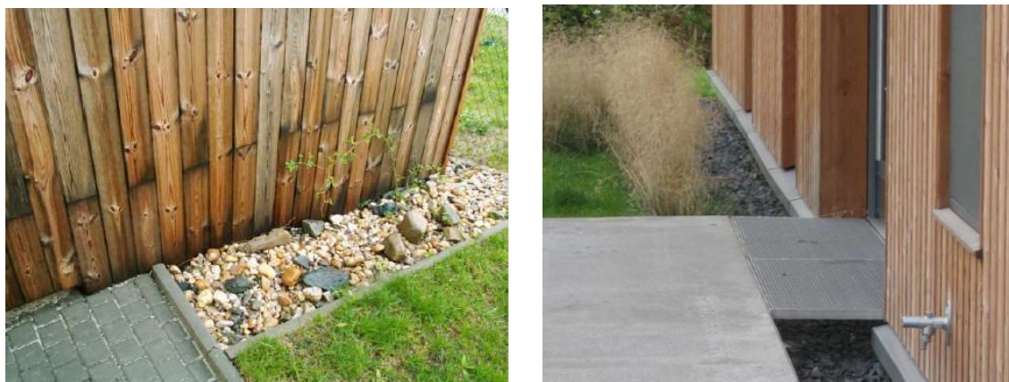
Obrázek 8: provádění soklu dřevostaveb, nesprávné – vlevo, správné – vpravo. (převzato z [24]).
