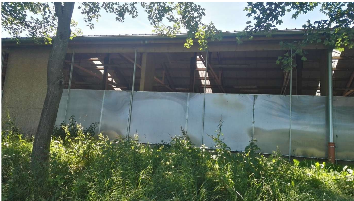
Obrázek 16: Pohled na severní stranu stáje pro chov dojnic od silnice
