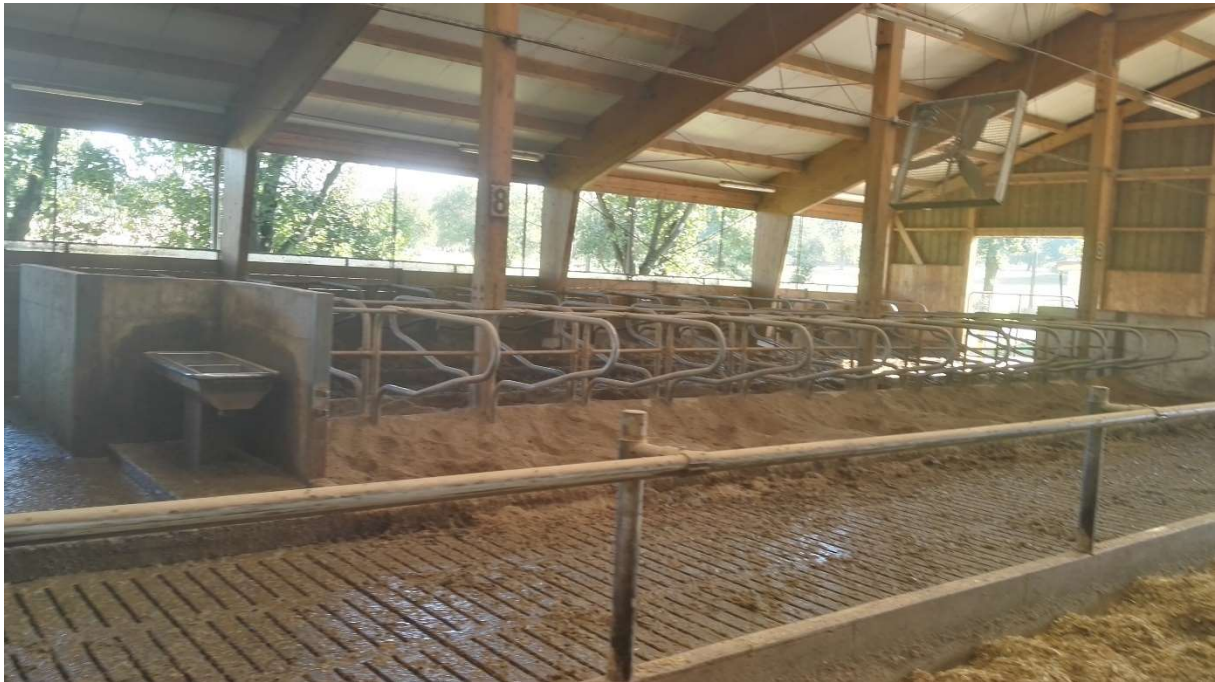
Obrázek 12: Pohled do vnitřního prostoru stáje pro chov dojnic směrem k silnici
