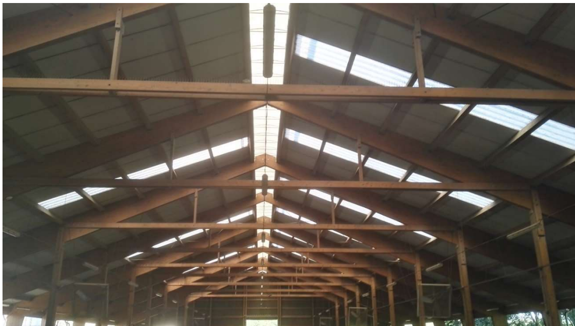
Obrázek 10: Pohled na zastřešení stáje pro chov dojnic
