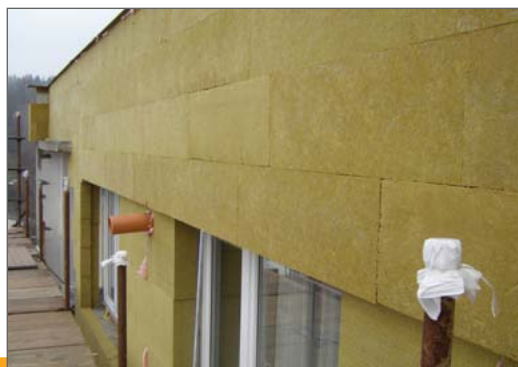
Ukázka aplikace výrobku ISOVER NF 333
