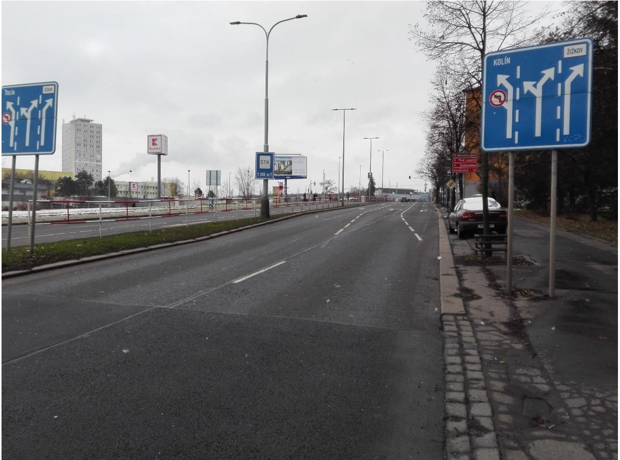
1-27 Pohled ke křižovatce Jarov ze směru od křižovatky V Třešňovce.
