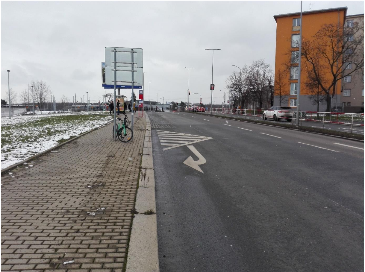
1-24 Stísněné řešení zálivu zastávky Spojovací v ulici Spojovací.
