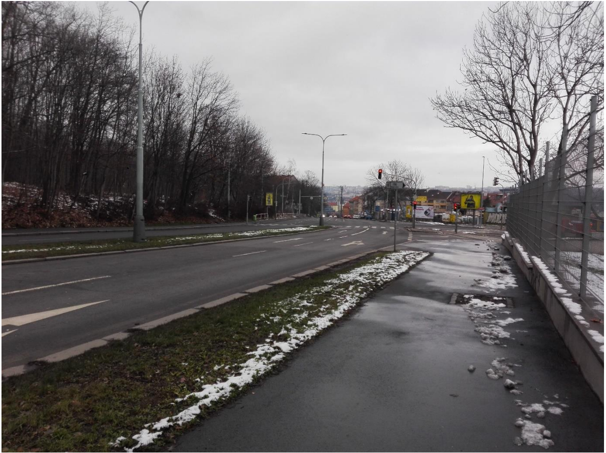
1-9 Pohled na křižovatku K Žižkovu z úseku od ulice Pod Šancemi
