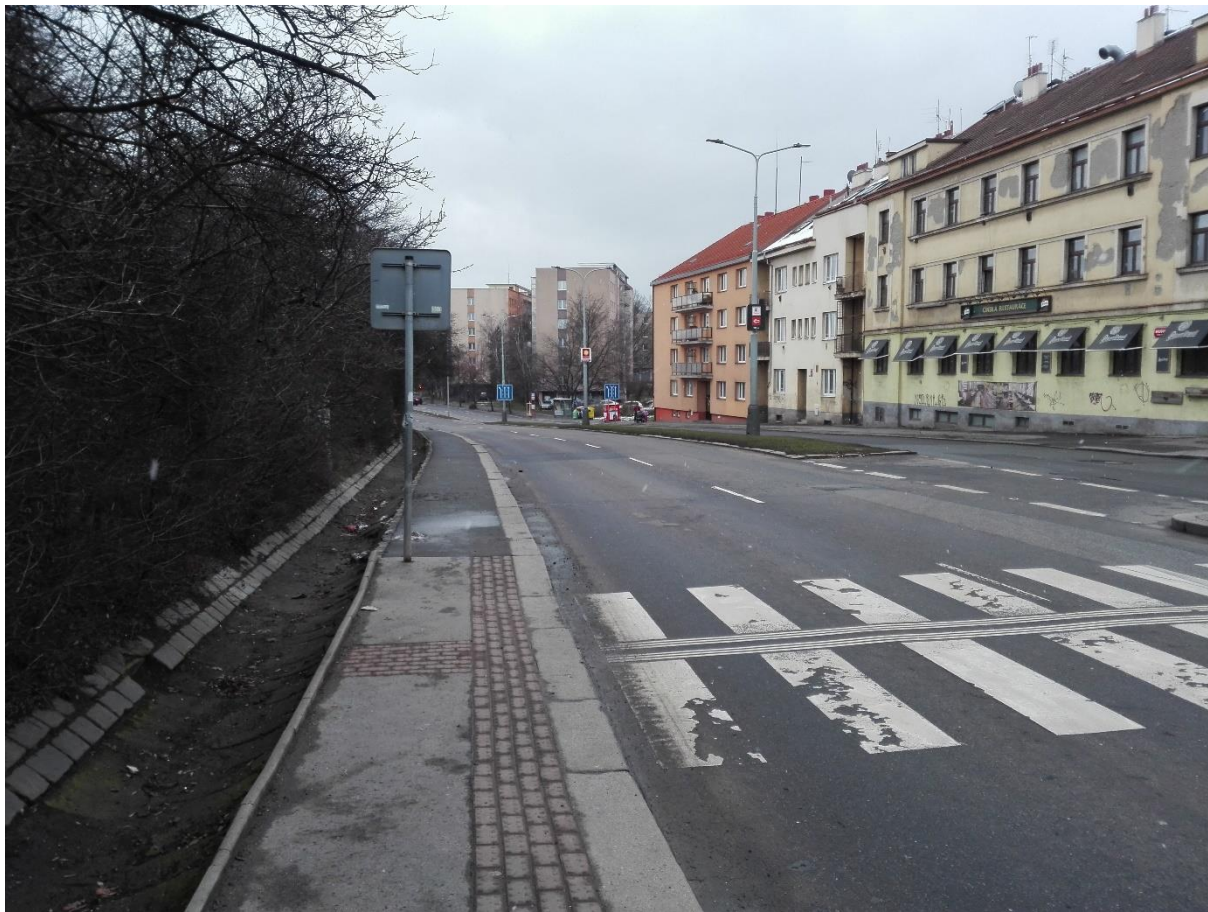
1-19 Pohled do úseku mezi křižovatkami U Kněžské louky a V Třešňovce. Velmi úzký chodník nepříjemný pro chůzi více než v 1 osobě.
