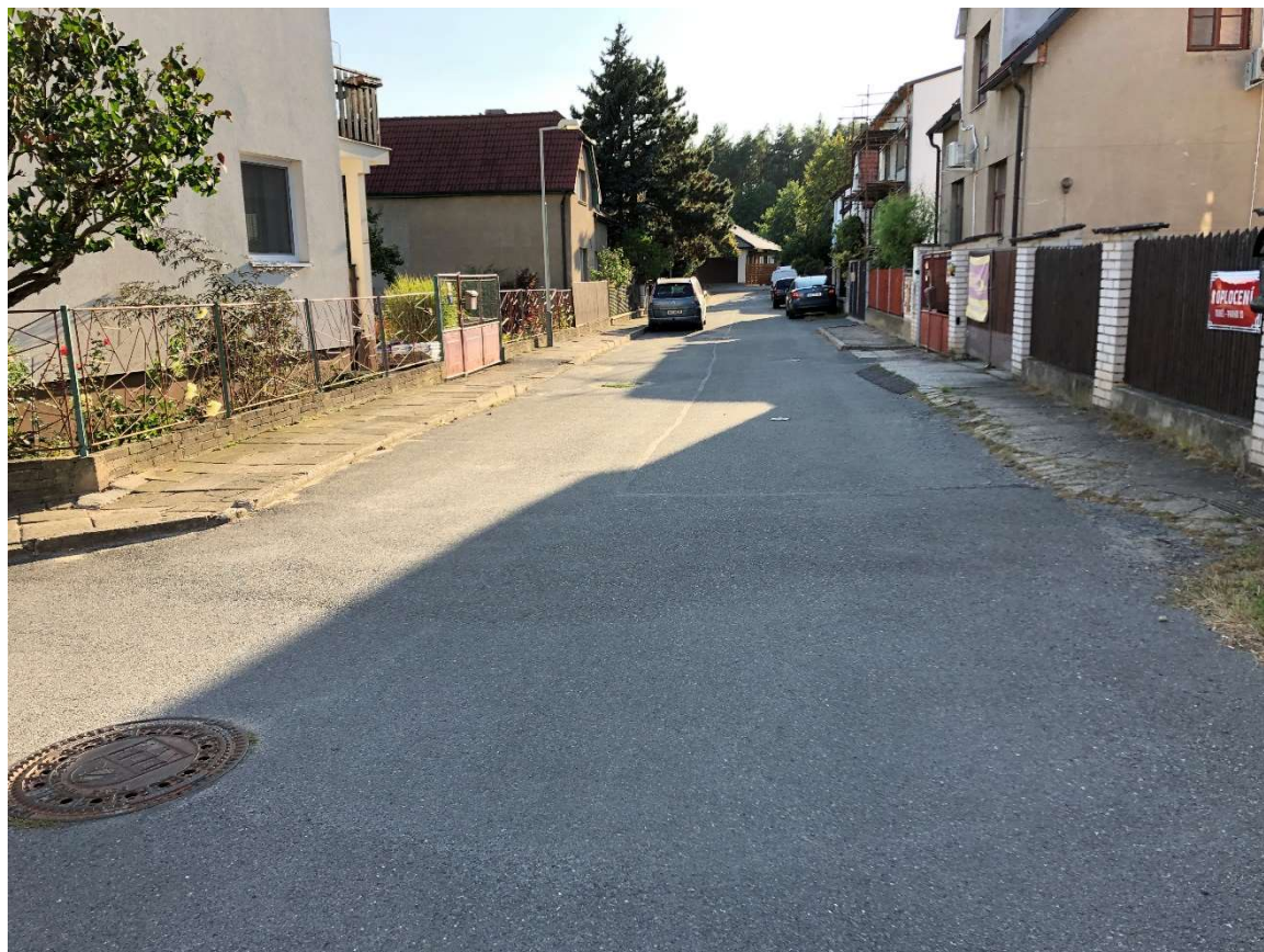
Obr. 7 – Ulice K Oplocení – pohled na stav vozovky a chodníků
