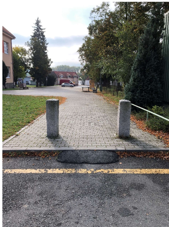
Obr. 40 – Ulice Kalašova – řešení bezbariérového přístupu na chodník ze severní strany ulice
