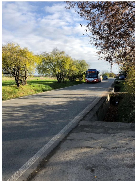
Obr. 44 – Ulice V Křížkách – pohled na umístění zastávky a chodníku po pravé straně – směr Dubeč
