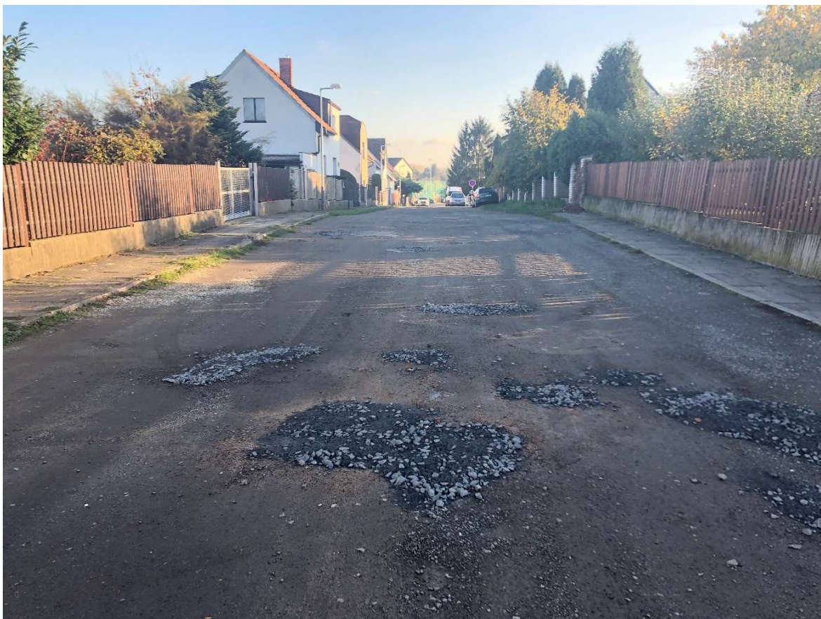
Obr. 21 – Ulice Za Pavilónem – provizorní oprava výtluků vyplněním drceným kamenivem
