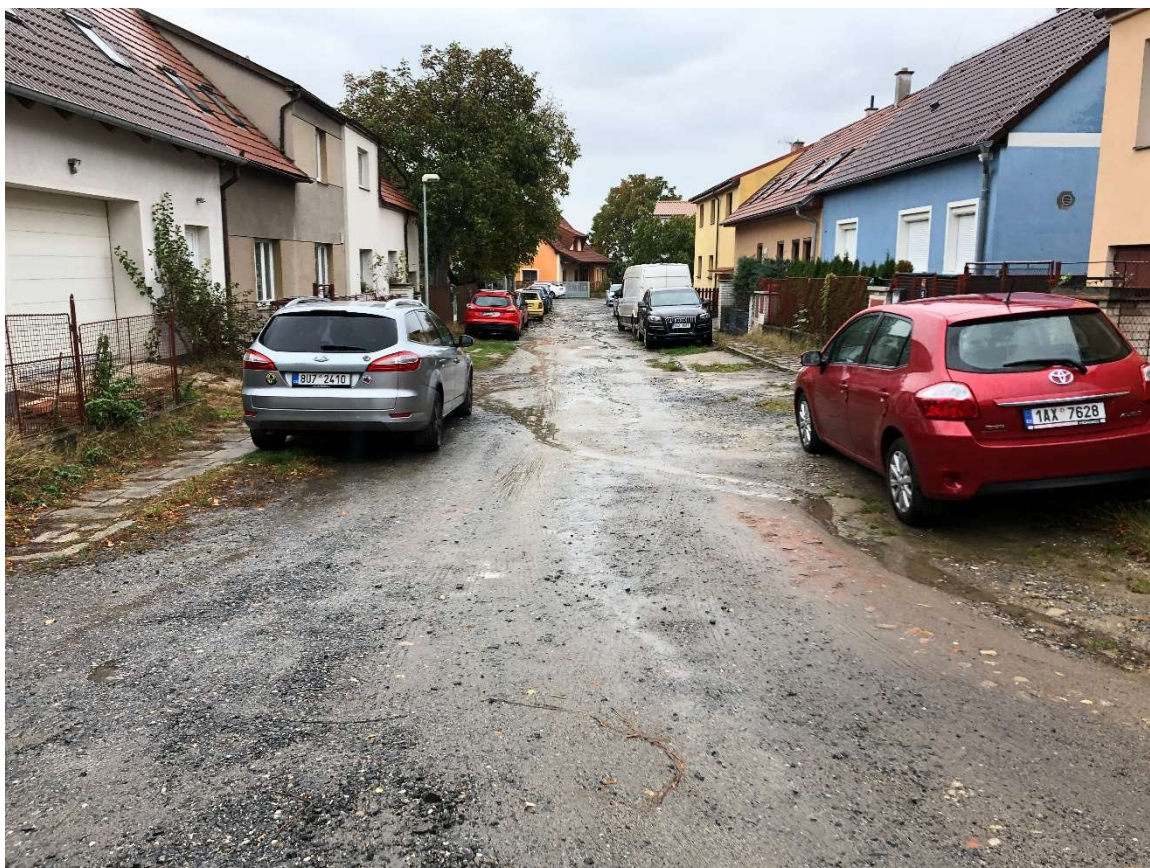
Obr. 11 – Ulice U Staré skládky – pohled od začátku staničení směrem do ulice, stav po dešti
