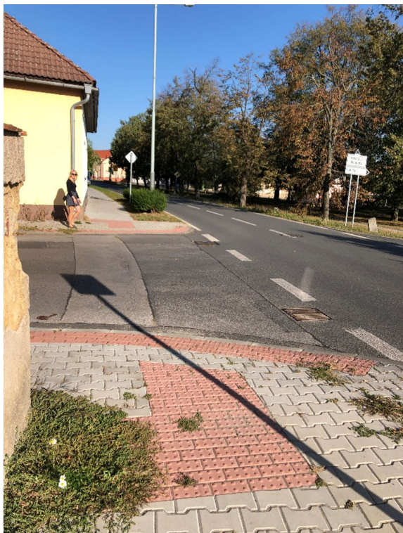
Obr. 36 – Ulice Štramberská – místo pro přecházení chodců
