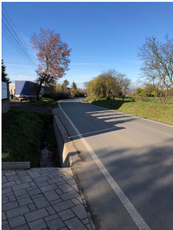
Obr. 43 – Ulice V Křížkách – pohled na umístění budoucí zastávky – směr Štěřboholy
