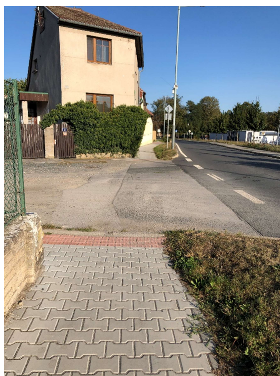
Obr. 30 – Ulice U Pavilónu – místo pro přecházení chodců
