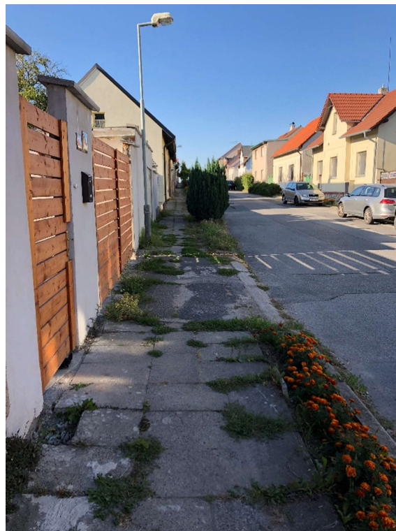
Obr. 34 – Ulice Štramberská – stav chodníku na levé straně ve směru staničení
