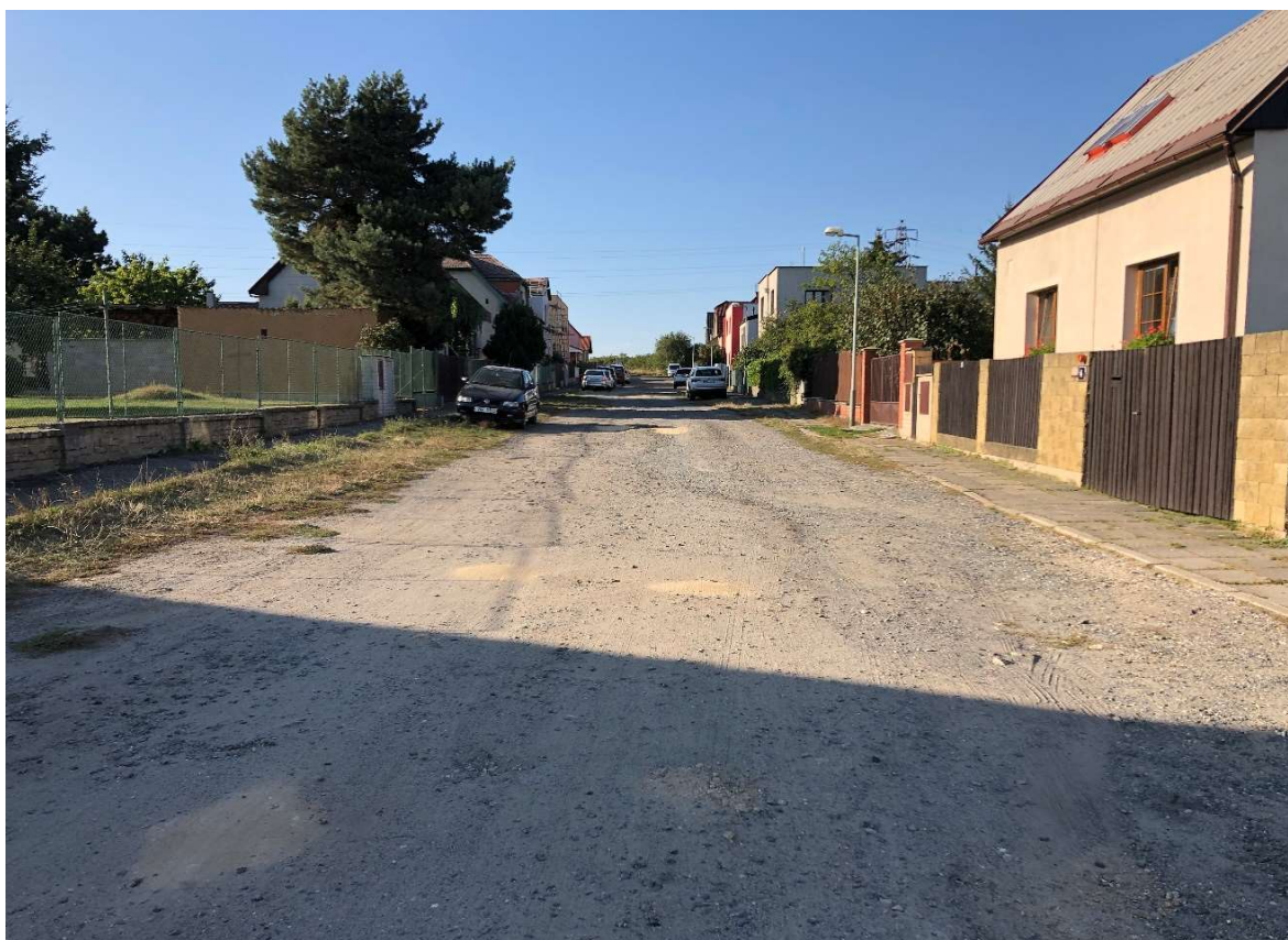
Obr. 25 – Ulice U Pavilónu – pohled od začátku staničení
