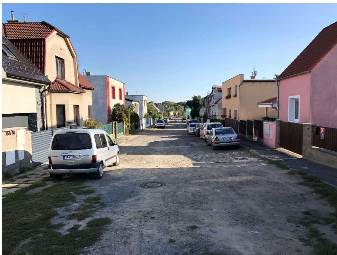
Obr. 26 – Ulice U Pavilónu – pohled do ulice ze zaslepeného konce
