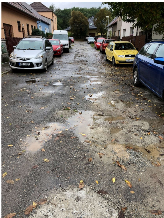
Obr. 9 – Ulice U Staré skládky – stav komunikace a parkování vozidel
