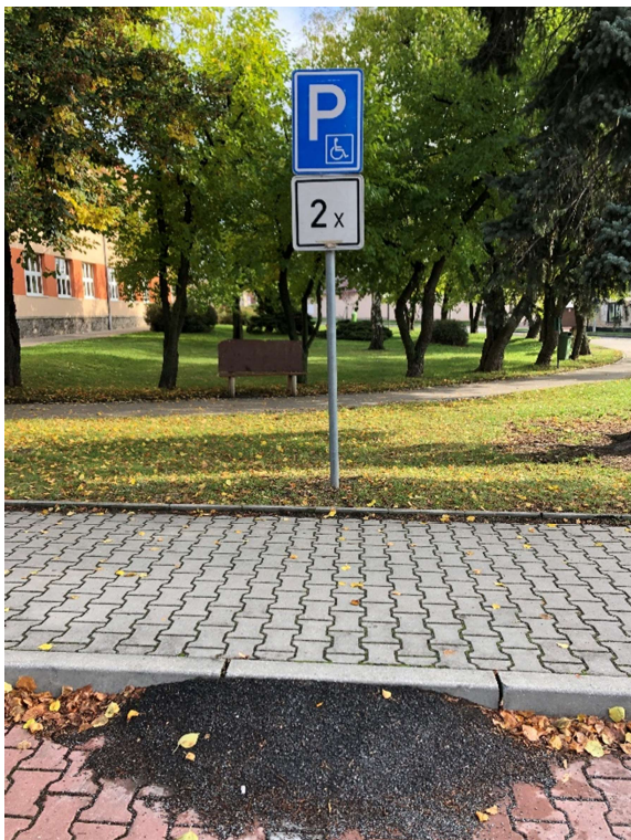
Obr. 39 – Ulice Kalašova – řešení bezbariérového přístupu na chodník před základní školou
