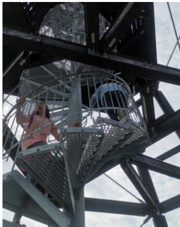
Obrázek 7- Schodiště zdroj: vlastní
