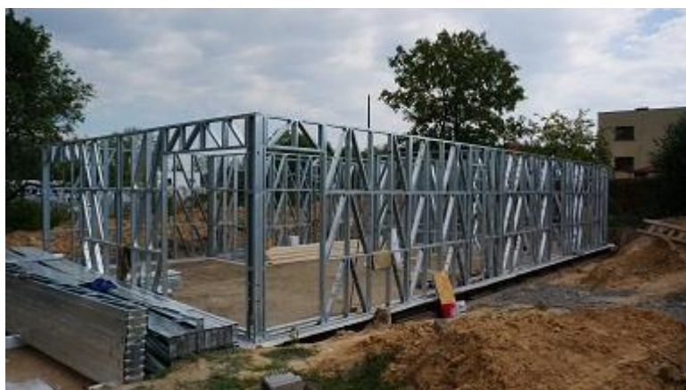
Obr. 2.8 Ocelový skelet rodinného domu, převzato z [15]
