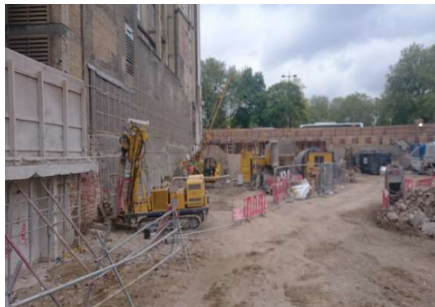
Obrázek 3.12 Pohled na staveniště Marble Arch Place [21]
