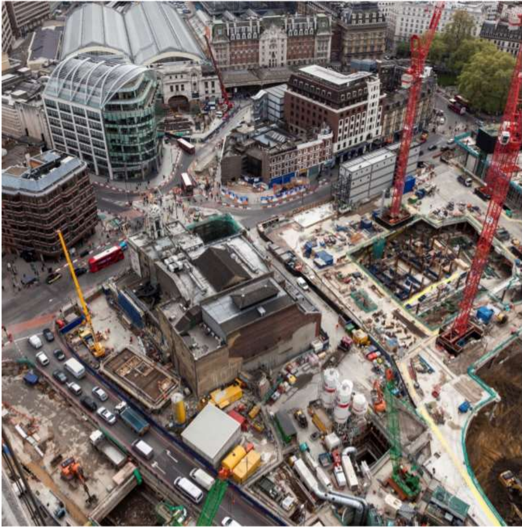
Obrázek 3.10 Pohled na stavenišťe Victoria Station [16]
