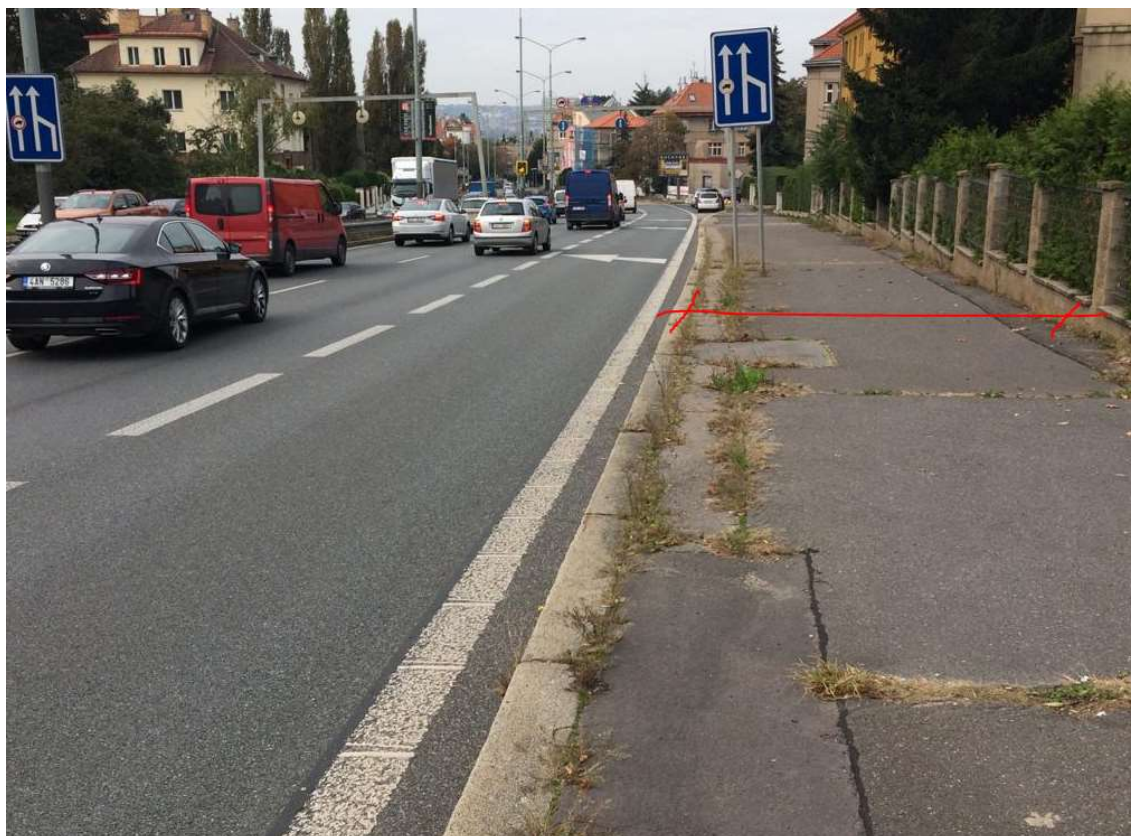
Obrázek 6: Nevhodná šířka chodníku a zřízený připojovací pruh.
