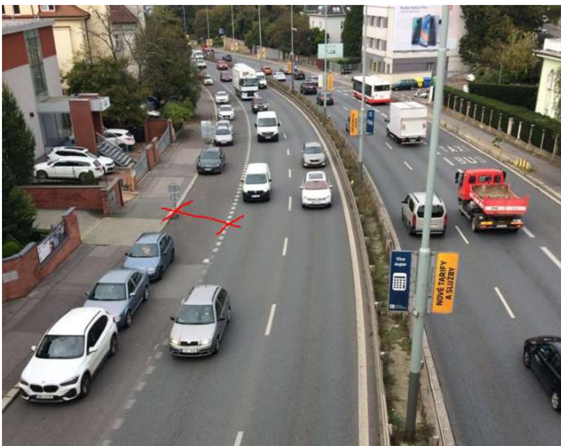
Obrázek 5: Nevhodná šířka podélného parkování a stání před vjezdy k obytné zástavbě bez vyznačení zákazu stání.
