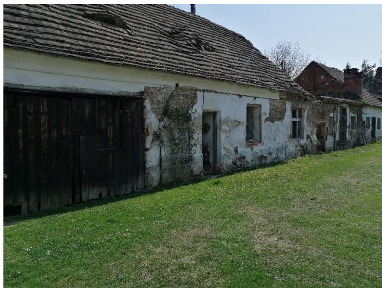
Obrázek 18: Současný stav SO02 [vlastní]
