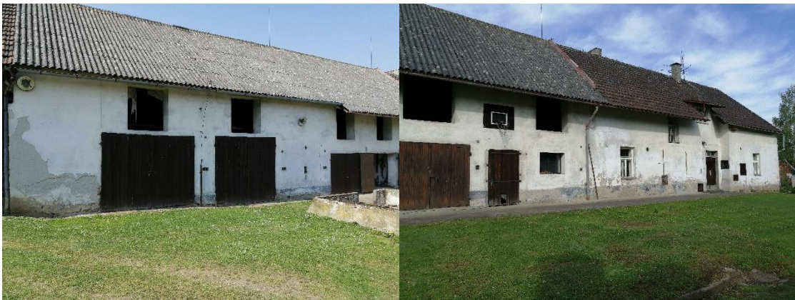
Obrázek 15: Současný stav SO01 [vlastní]
