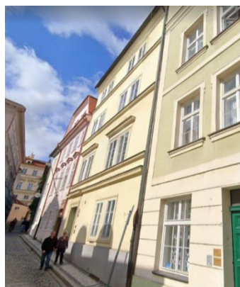
Obrázek 8: Bytový dům č. 1
