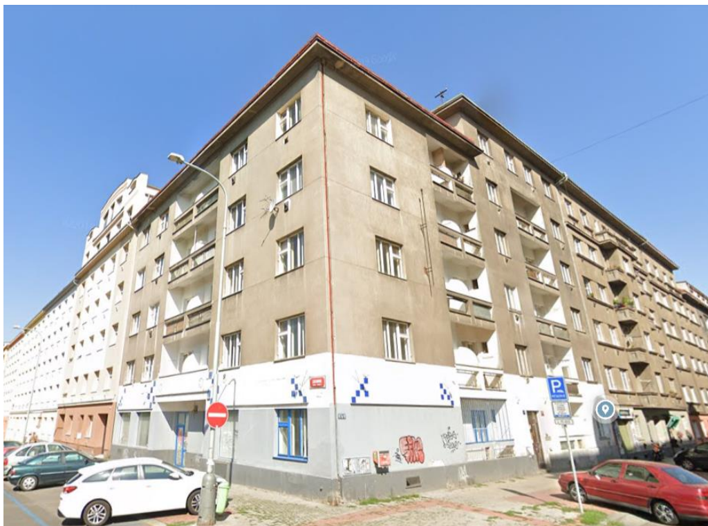
Obrázek 10: Bytový dům č. 6
