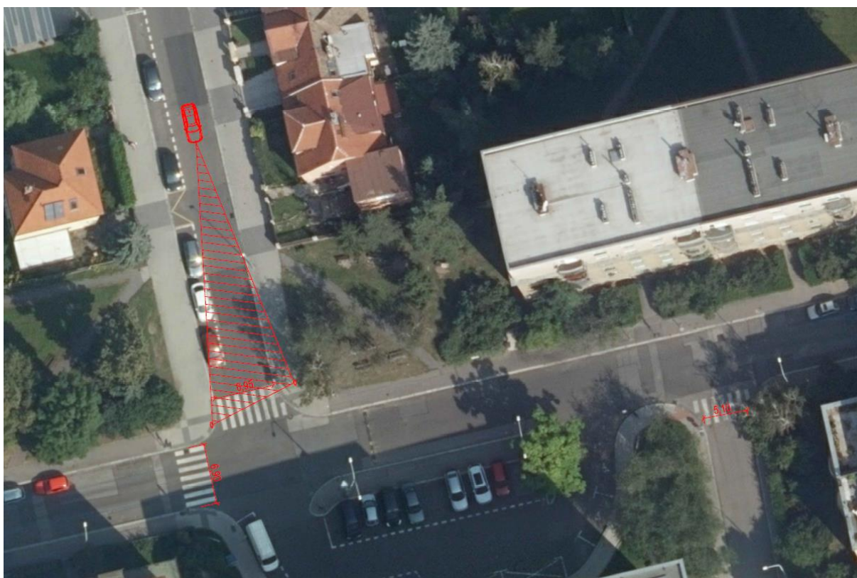
Obrázek 5 – Nevyhovující rozhledové poměry a délky přechodů, zdroj [1]
