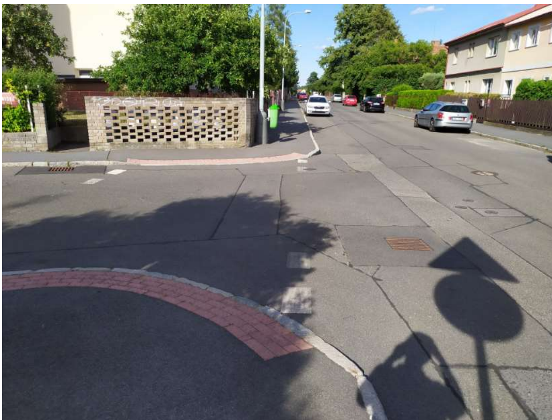
Obrázek 3 – Místo pro přecházení ulice Třebonická, zdroj [1]
