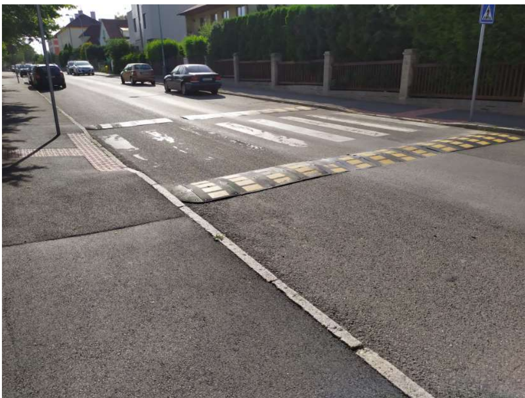
Obrázek 4 – Přejechod se zpomalovacími prahy v ulici Stochovské, zdroj [1]
