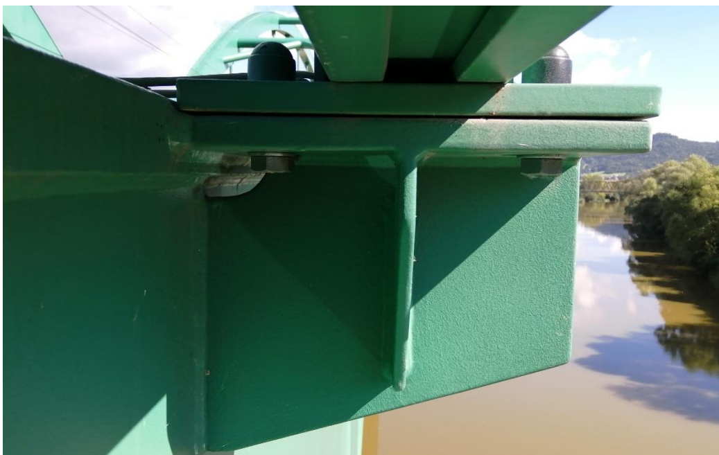
Obr. 28: Konzola na sloupek protihlukové stěny
