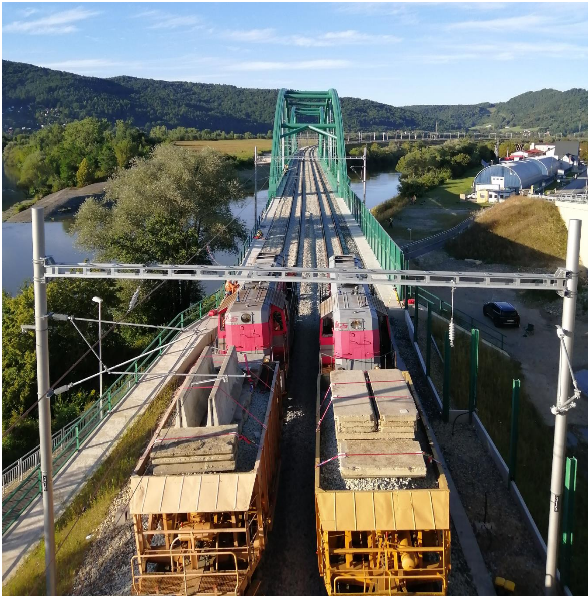
Obr. 97: Soupravy před zahájením statické zatěžovací zkoušky
