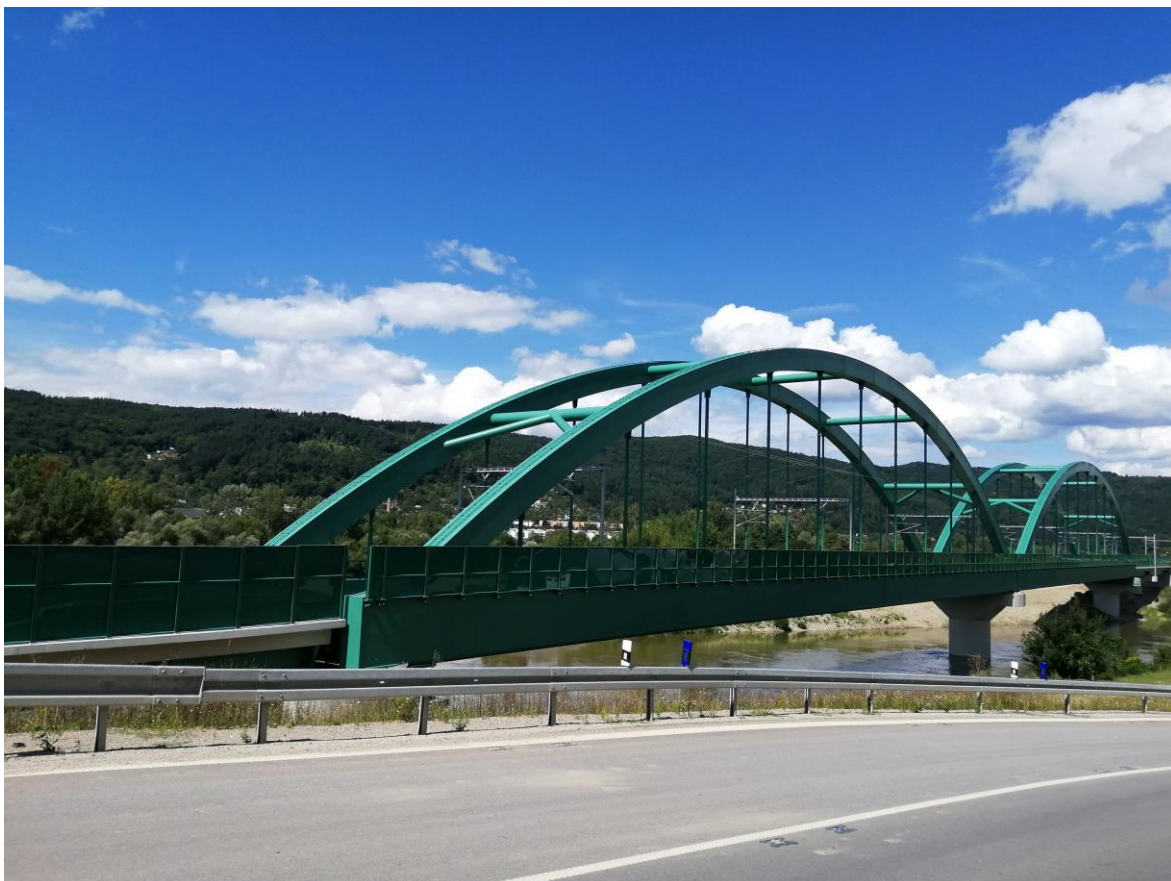
Obr. 19: Celkový pohled na most
