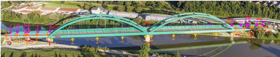
Obr. 81: Rozmístění geodeticky sledovaných bodů [23]
