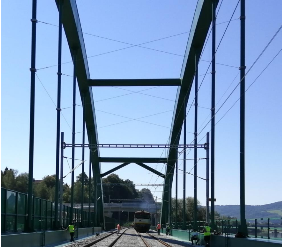
Obr. 108: Dodatečně přidaná lana
