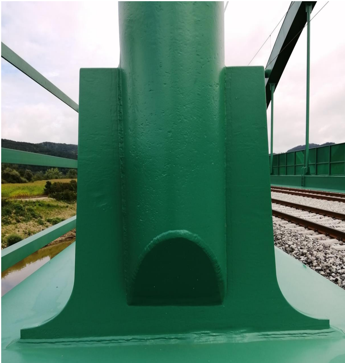
Obr. 24: Připojení styčnickového plechu táhla na hlavní nosník
