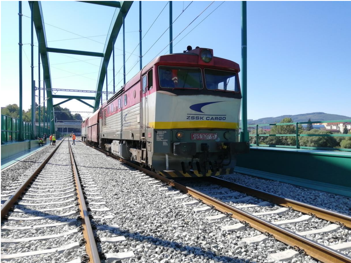
Obr. 98: Přejezd soupravy během dynamické zatěžovací zkoušky
