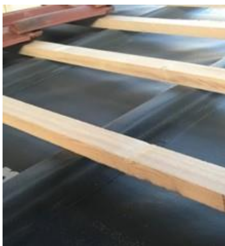
Obr. 43 Průběh přes kontralatě, třída těsnosti 1, zdroj: Wienerberger, 2020
