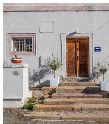
Obr. 36 vstupní schody včetně předzahrádky, portálu a průvlakových mříží v oknech, zdroj: V Invest Development s.r.o.
