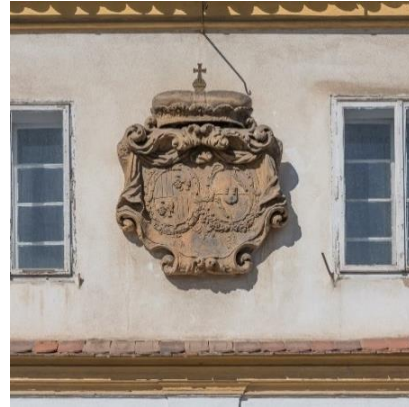
Obr. 26 Fotografie aliančního rodového erbu nad stávajícím vjezdem do areálu v jižní části východního křídla, zdroj: V Invest Development s.r.o.
