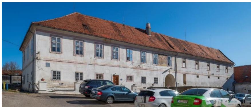
Obr. 30 Fotografie severního křídla – části záměcku, zdroj: V Invest Development s.r.o.
