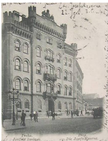
Obr. 19 Pohlednice z dob umístění kasáren, zdroj: Palladium, 2020
