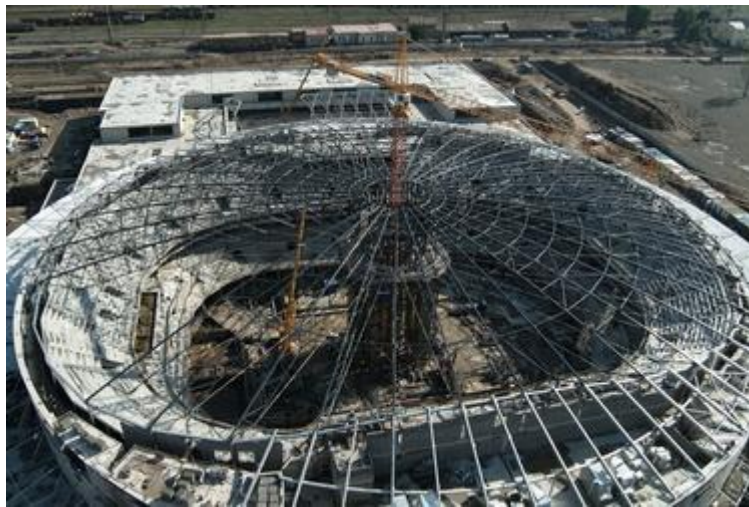
Obr. 20 Stavba O2 areny (dříve Sazka arena), zdroj: Janata, 2016
