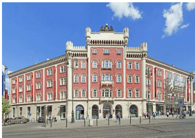
Obr. 18 Stávající podoba obchodního centra Palladium, zdroj: Jones Lang LaSalle IP, Inc., 2020
