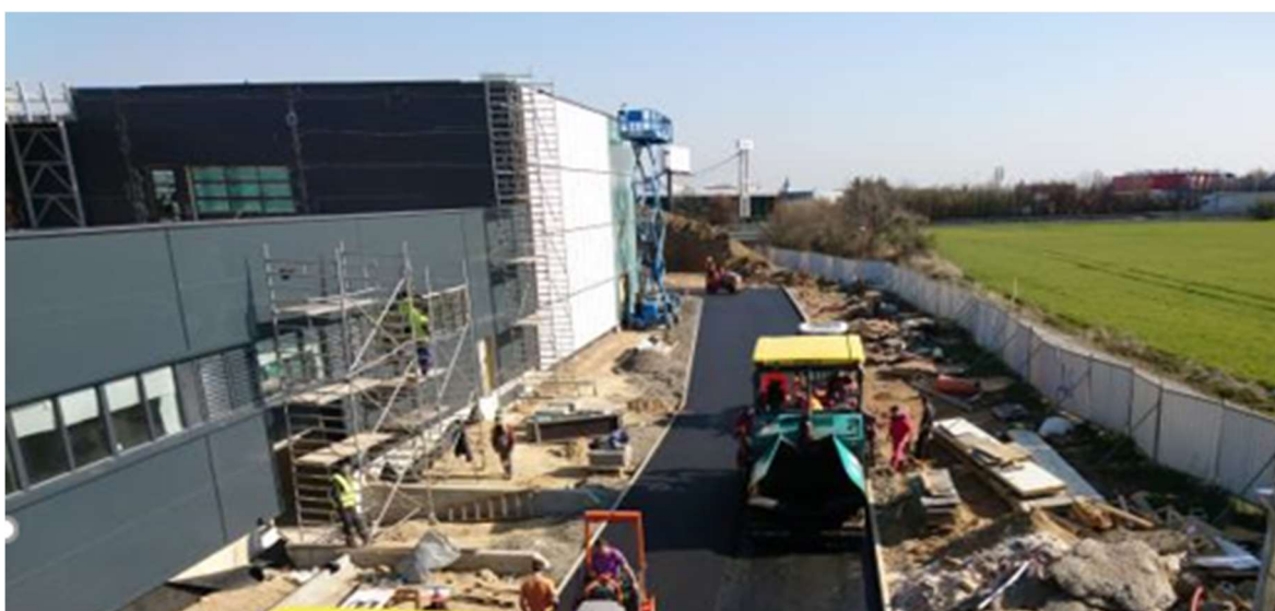
Obrázek č. 17: Práce ve výškách na obvodovém lešení [autor]
