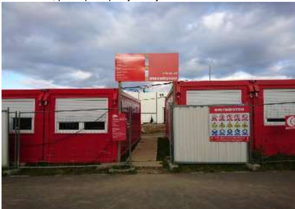
Obrázek č. 7: Hlavní vstup na stavbu [autor]
