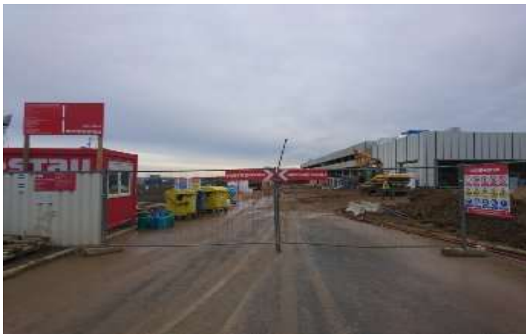
Obrázek č. 8: Hlavní vjezd na stavbu [autor]
