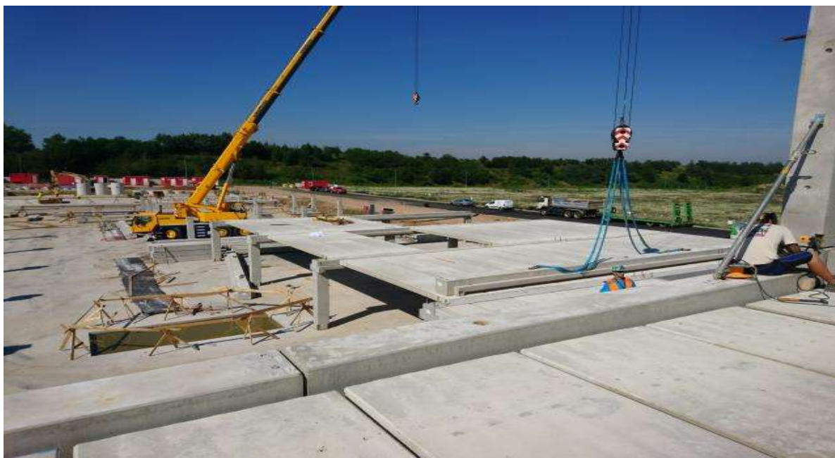
Obrázek č. 15: Průběh montážních prací [autor]
