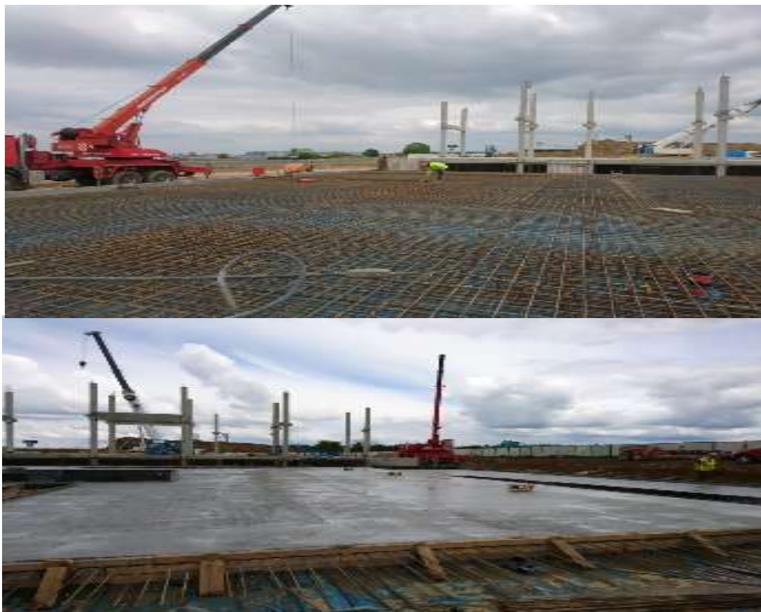
Obrázek č. 12: Proces armování a hydratace základové desky [autor]
