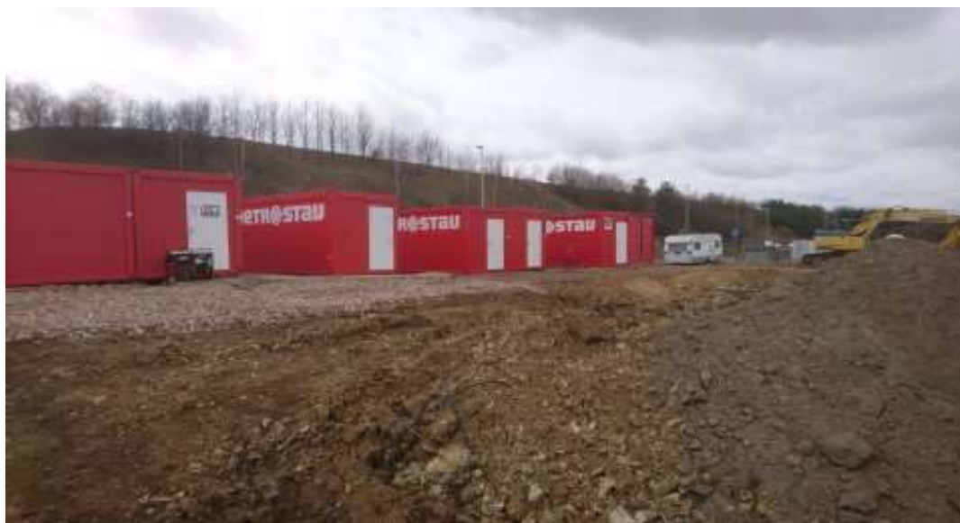
Obrázek č. 10: Zařízení staveniště v průběhu zemních prací [autor]
