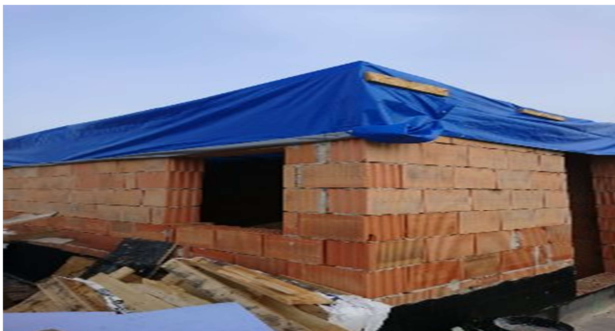
Obrázek č. 14: Zděné příčky u výstupu na střechu [autor]
