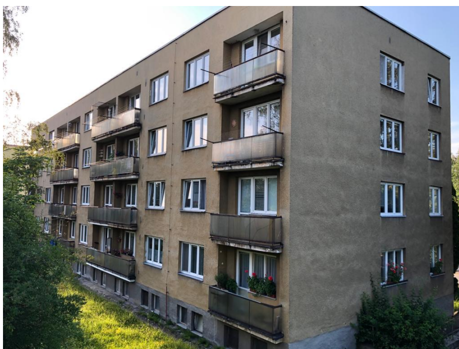
Obr. 2: Pohled na jižní a východní stranu bytového domu [vlastní zdroj]
