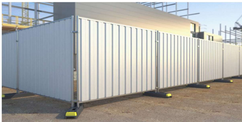
Obrázek 5 Ukázka staveništního oplocení [6]
