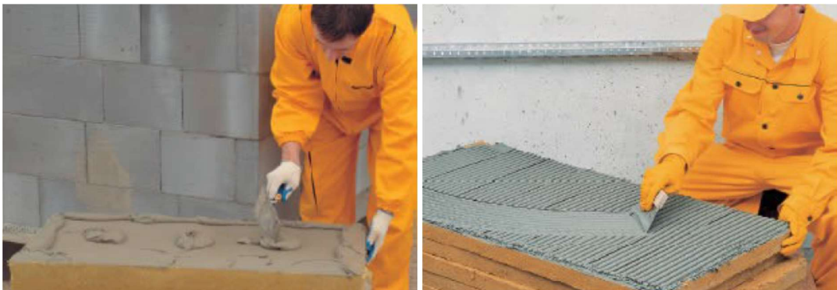
Obrázek 2 - styly lepení izolačních desek
