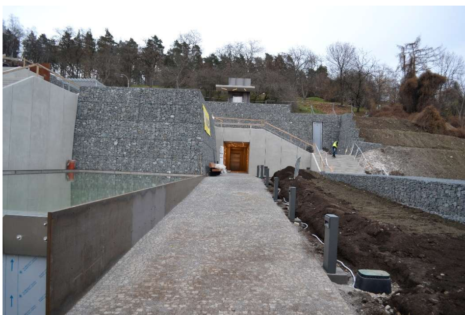
Obr. č. 16- Pohled na chodník kolem bazénu, sklon 5,9 %, v pozadí výtah (Vlastní zdroj, 2020)
