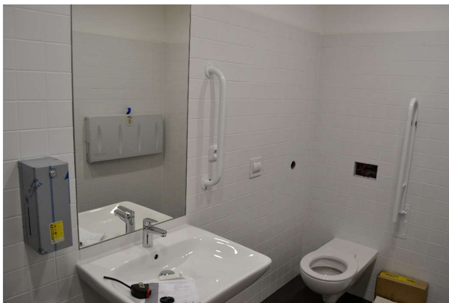
Obr. č. 12- WC pro invalidy (Vlastní zdroj, 2020)
