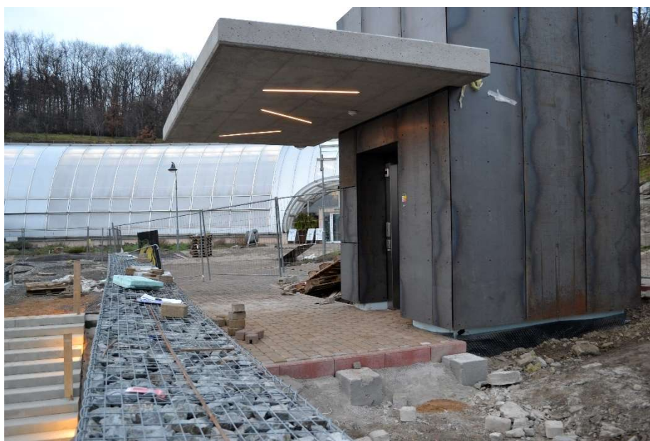
Obr. č. 20- Horní stanice výtahu, v pozadí skleník Fata Morgana (Vlastní zdroj, 2020)
