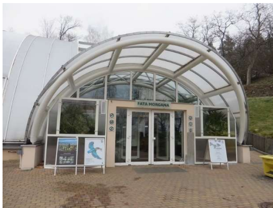
Obr. č. 18- Vstup do skleníku (Pražská organizace vozíčkářů – Skleník Fata Morgana)
