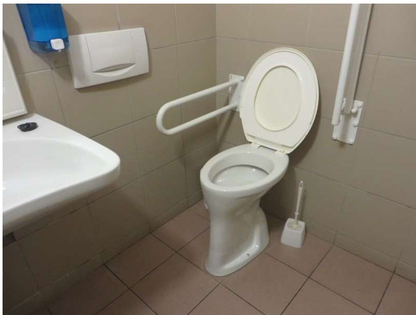
Obr. č. 22- Částečně přístupná toaleta (Pražská organizace vozíčkářů)
