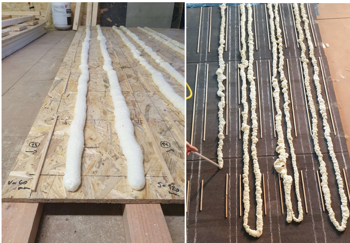
Obr. 26: Porovnání kvality nanášení lepidla v této práci (vlevo) a bakalářské práci (vpravo), (zdroj autor)
