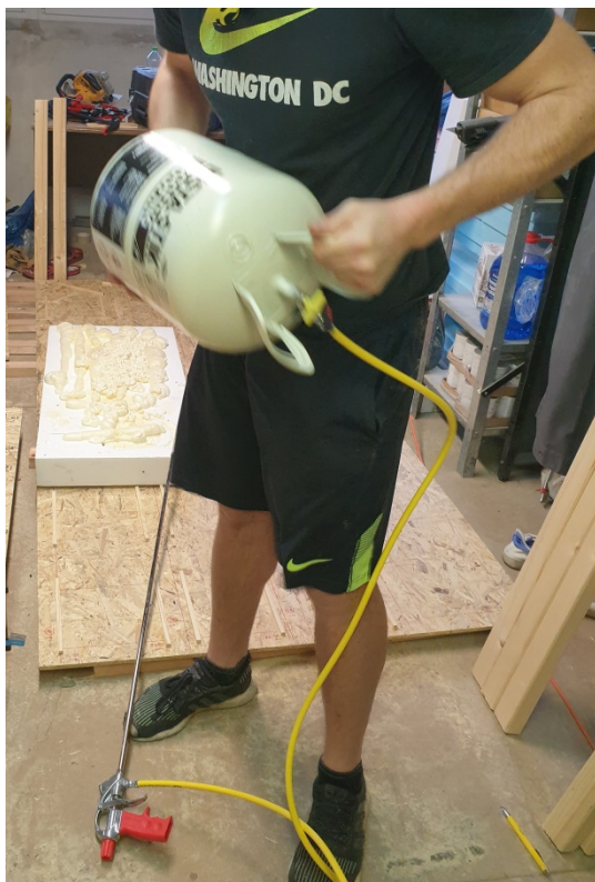
Obr. 23: Promíchání lepidla před aplikací (zdroj autor)
