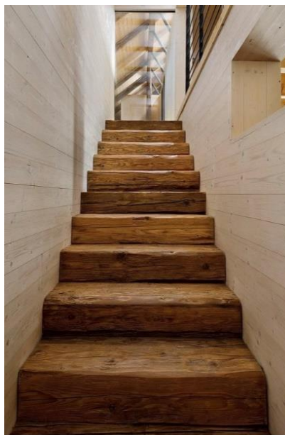
Obrázek 30: Možnost využití prvků krovu 3 – obklad schodiště
