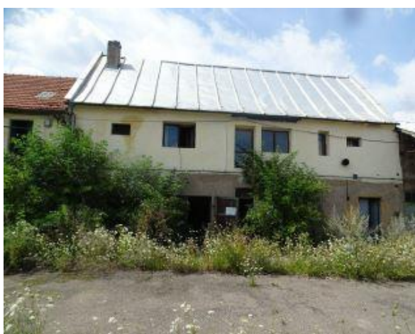
Obrázek 24: Původní stav budova 3
