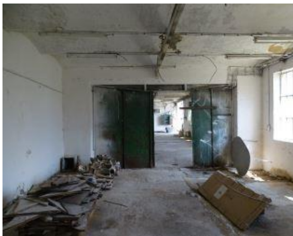
Obrázek 20: Původní stav přízemí budova 2
