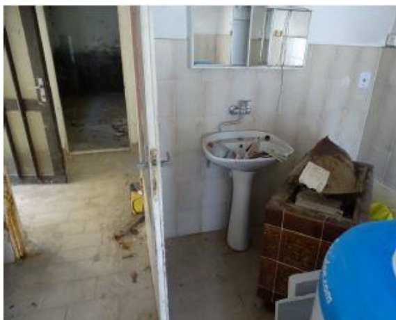
Obrázek 19: Původní stav přízemí budova 6
