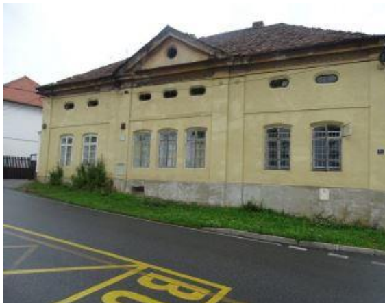
Obrázek 21: Původní stav budova 1
