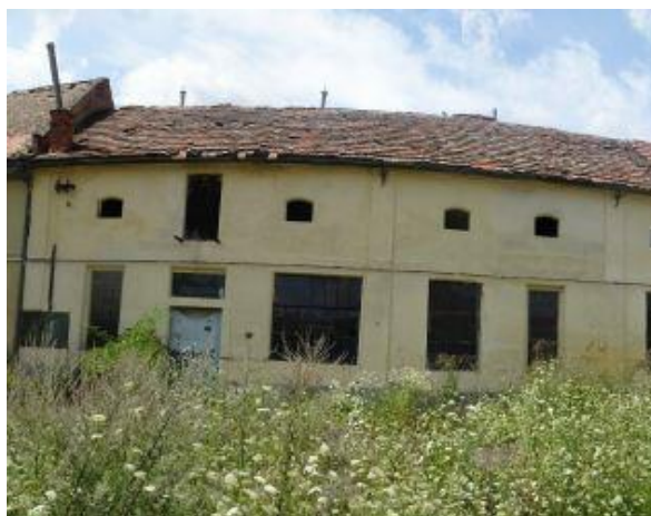
Obrázek 23: Původní stav budova 2
