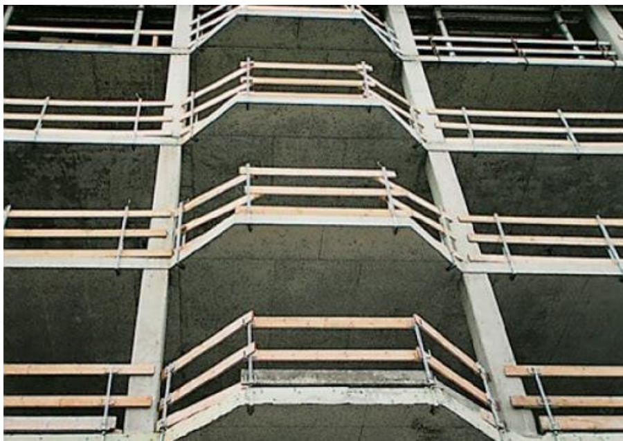
Obr. č. 25: Pomocné dřevěné zábradlí [22]
