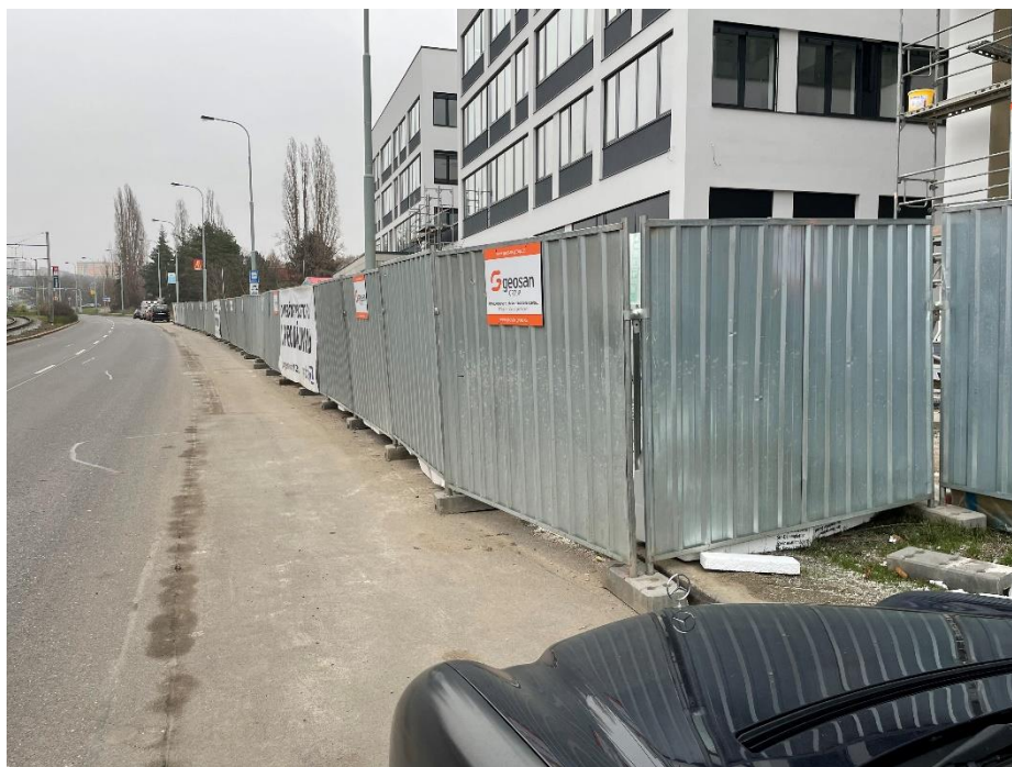
Obr. č. 5: Oplocení staveniště [vlastní zdroj]
