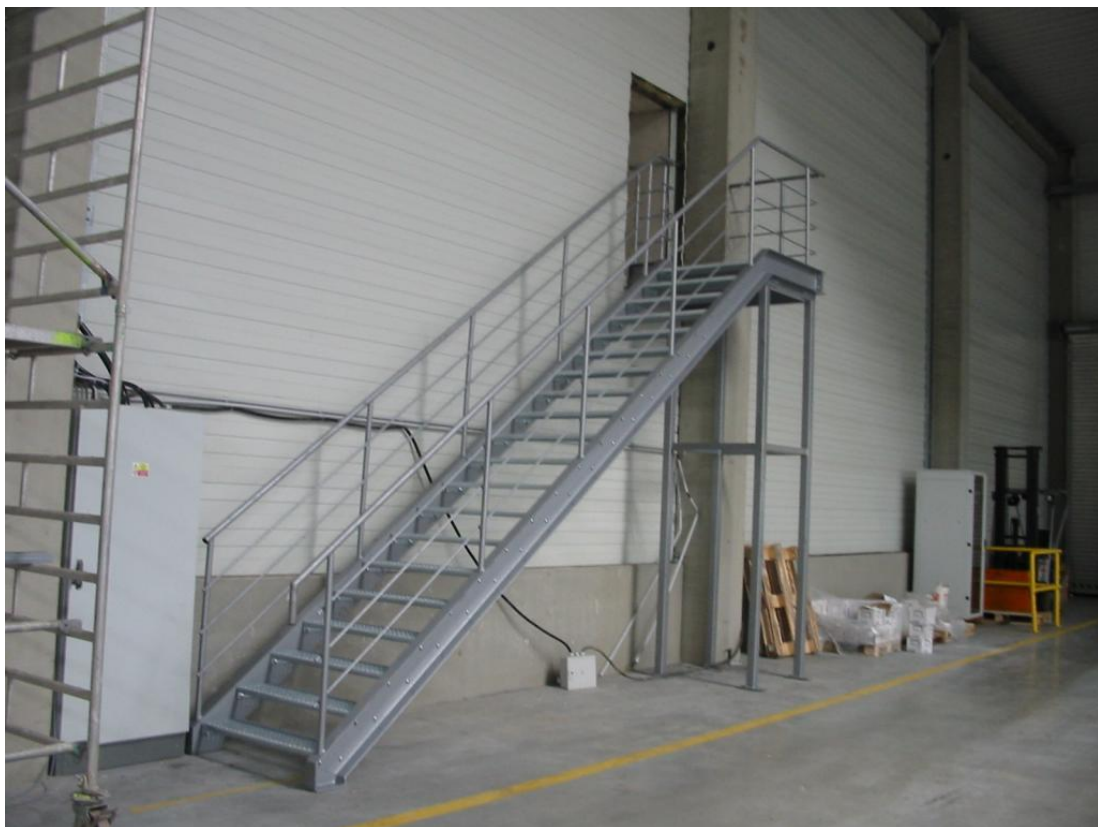
Obr. č. 18: Pororošťové schodišťa k patrovému buňkovišti [18]
