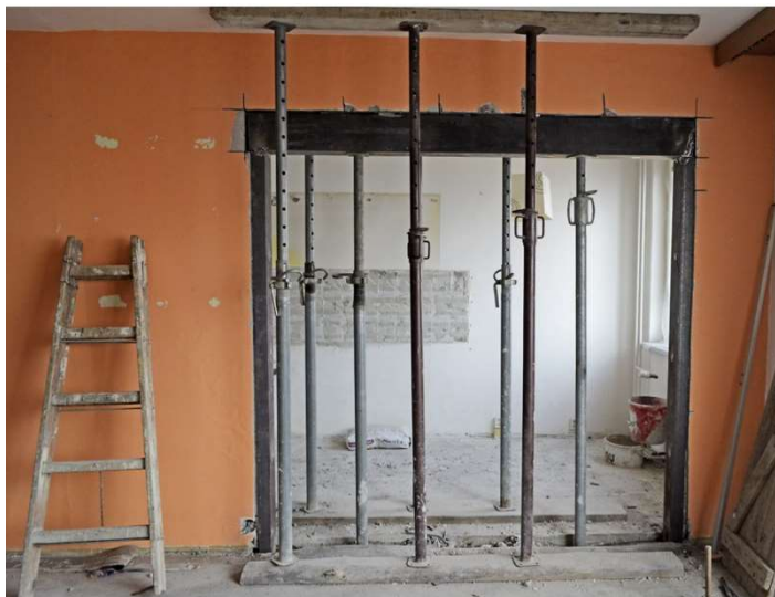
Obrázek 6 - Podepření bouraného otvoru [21]
