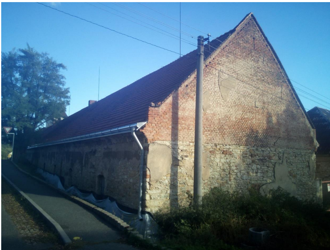
Obr. 12 – Kravín ze severozápadu, podzim 2020. (zdroj: vlastní zpracování)
