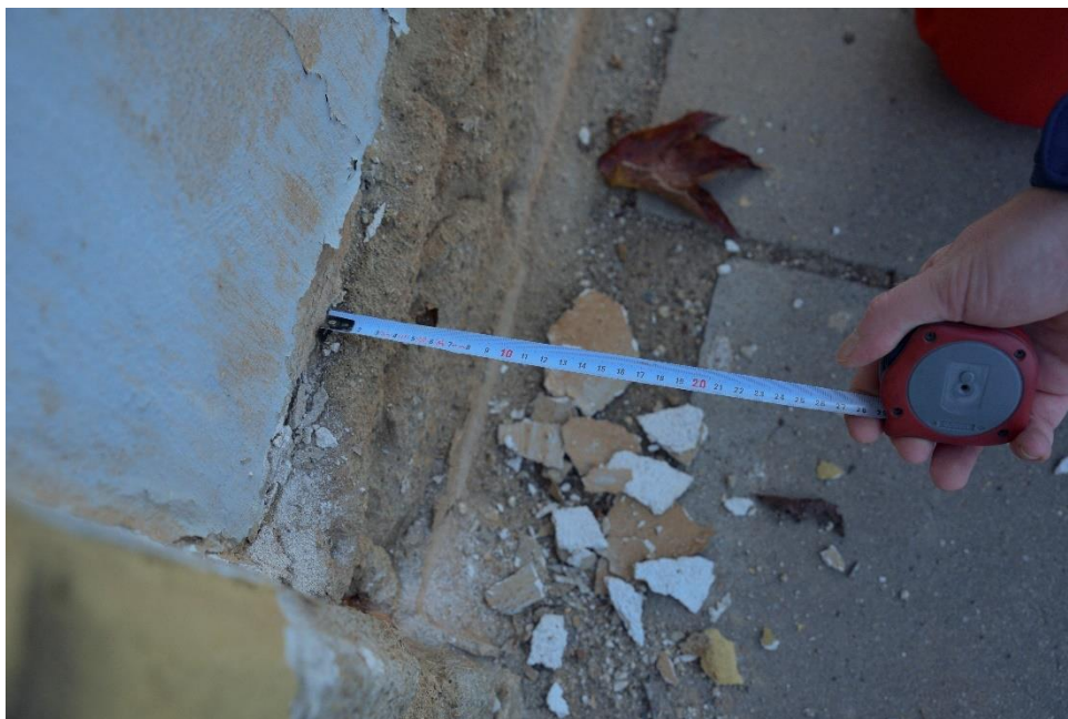
Obr. 42 – Zaměření zbytků odpadlého soklu, západní konec jižní části, podzim 2020. (zdroj: vlastní zpracování)
