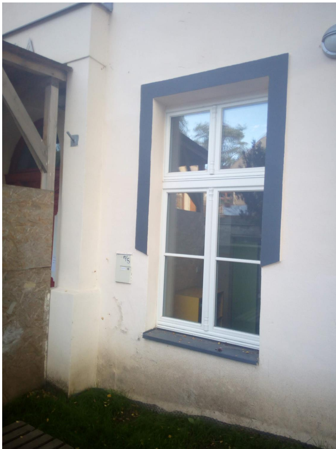
Obr. 15 – Část severní stěny školy západně od hlavního vchodu, podzim 2020. (zdroj: vlastní zpracování)
