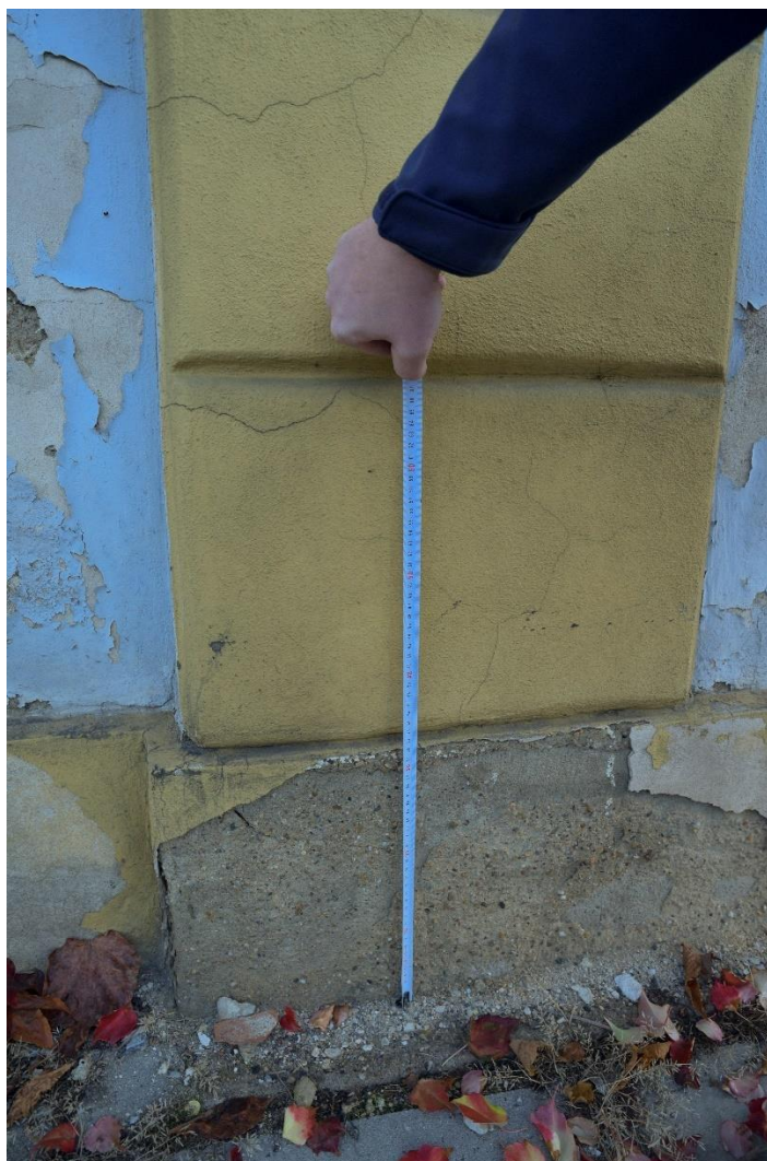
Obr. 45 – Zaměření bosáže na pilastru, podzim 2020. (zdroj: vlastní zpracování)
