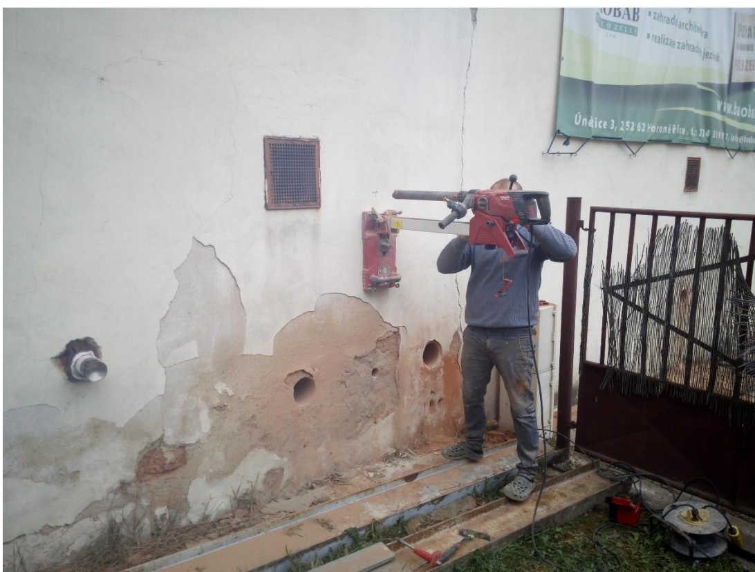
Obr. 52 – Provádění jádrového vývrtu \varnothing 52 mm, podzim 2020. (zdroj: vlastní zpracování)
