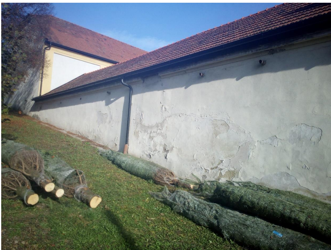
Obr. 68 – Degradovaná západní stěna s přerušenou římsou po původním arkýři, podzim 2020. (zdroj: vlastní zpracování)
