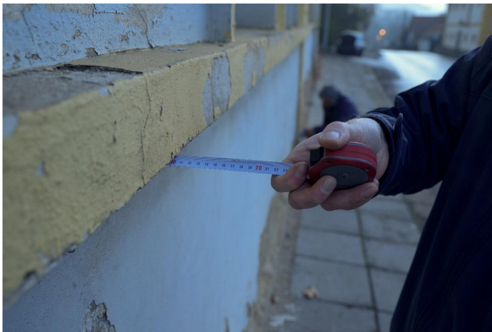
Obr. 44 – Zaměření vysazení podokenní římsy, podzim 2020. (zdroj: vlastní zpracování)
