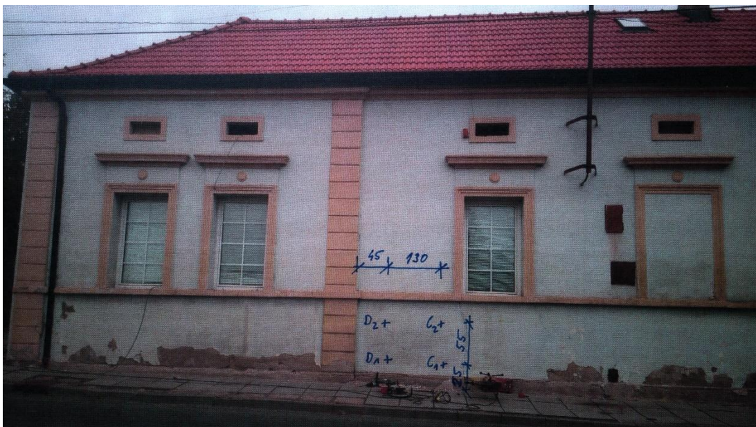
Obr. 49 - Umístění vývrtů pro vzorky C1, C2, D1 a D2, střední část jižní strany, podzim 2020. (zdroj: vlastní zpracování)
