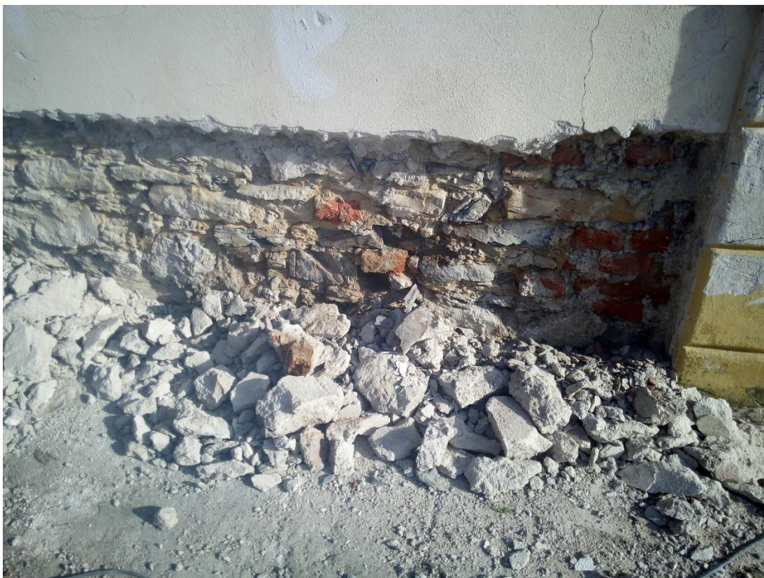
Obr. 60 – Odstraňování potřhané velmi silné cementové omítky na jižním konci západní strany, podzim 2020. (zdroj: vlastní zpracování)
