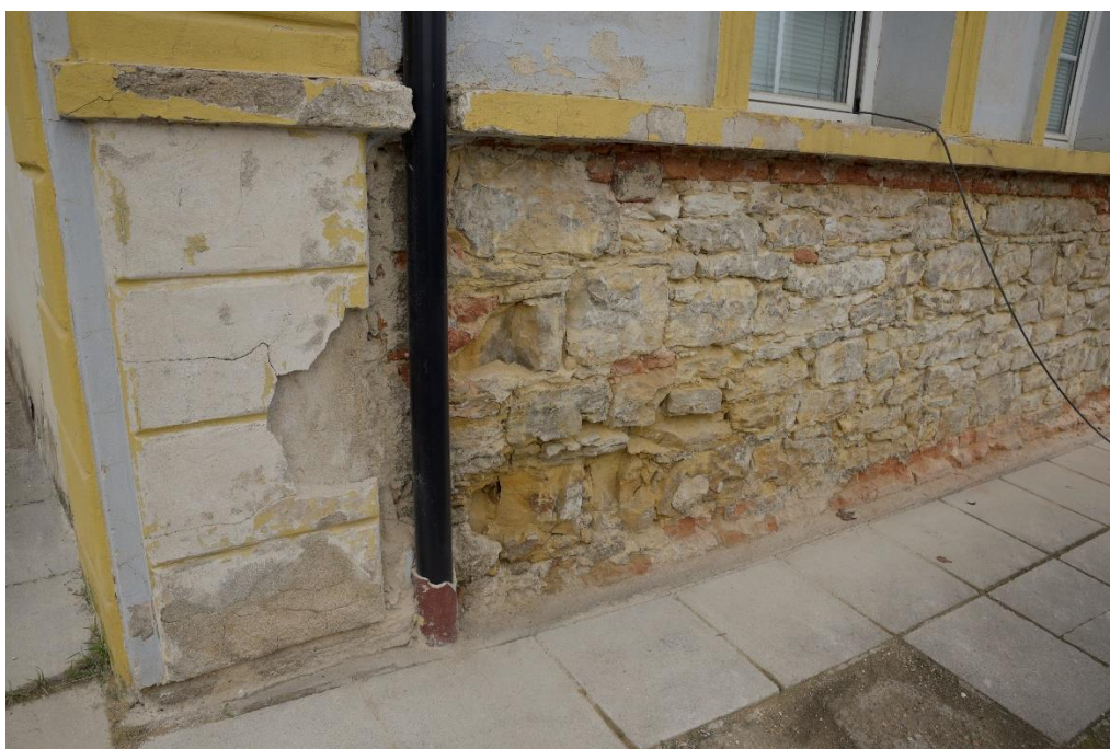
Obr. 56 – Odstranění omítky na západním konci jižní stěny, podzim 2020. (zdroj: vlastní zpracování)
