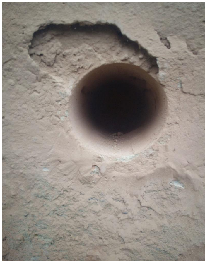
Obr. 53 – Detail provedeního jádrového vývrtu \varnothing 52 mm, podzim 2020. (zdroj: vlastní zpracování)
