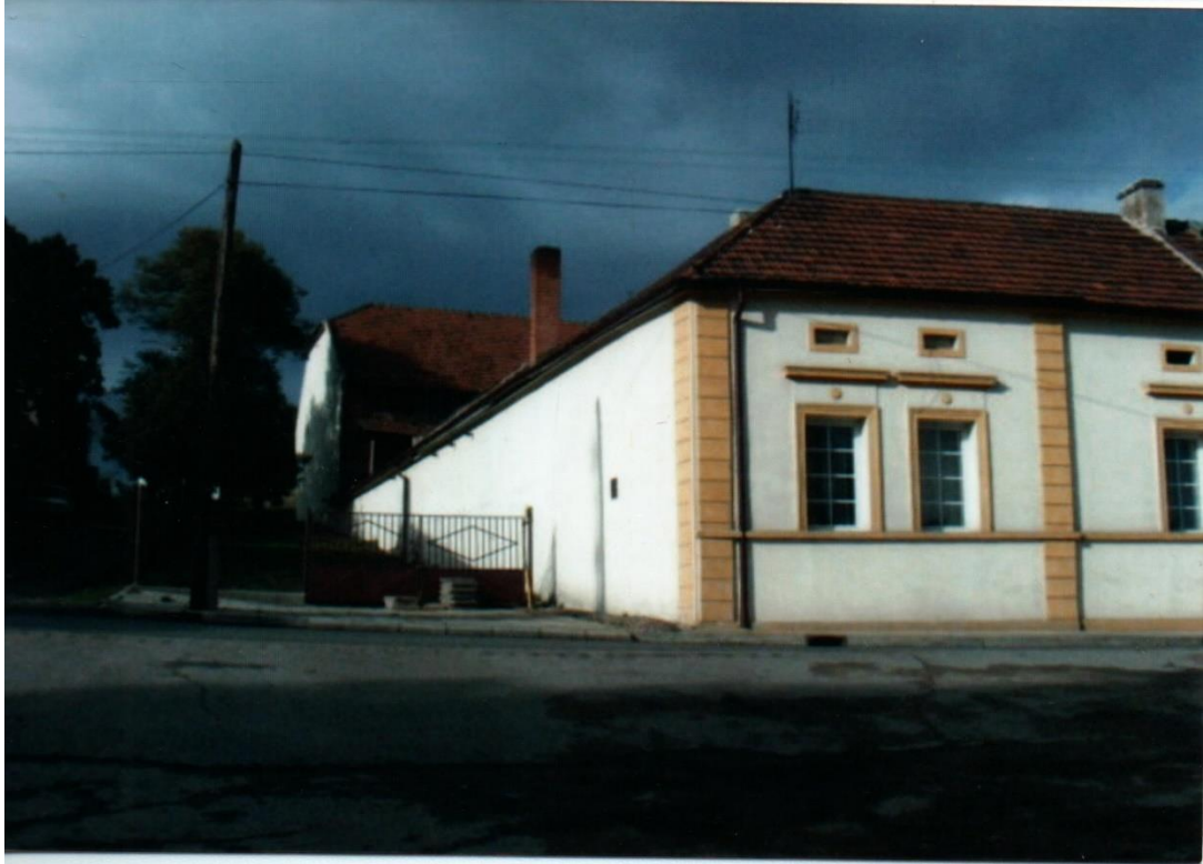
Obr. 30 – JZ roh po opravě fasády s doplněným pilastrem bosáží na západní straně, přelom 20. a 21. století. (zdroj: MUDr. Jan Myšák)
