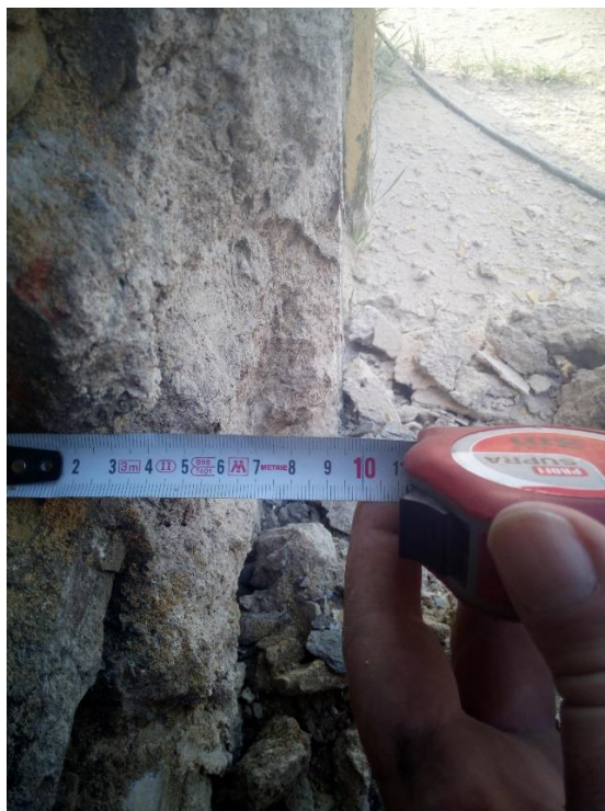
Obr. 40 – Detail cementové omítky na jižním konci západní strany, podzim 2020. (zdroj: vlastní zpracování)
