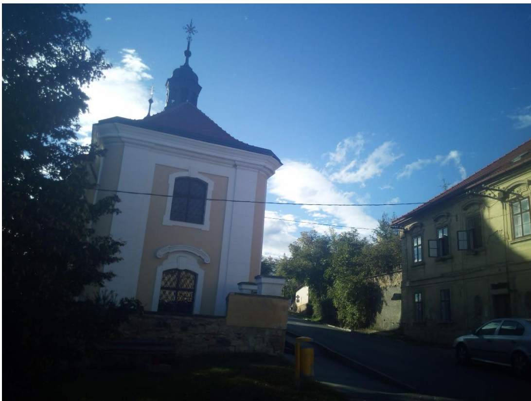
Obr. 9 - Kostel Nanebevzetí Panny Marie z východu, podzim 2020. (zdroj: vlastní zpracování).
