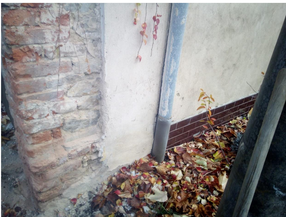
Obr. 58 – Odstraněná omítka z východního konce jižní strany, kde by měla být vytvořena dilatace od sousedního objektu, podzim 2020. (zdroj: vlastní zpracování)
