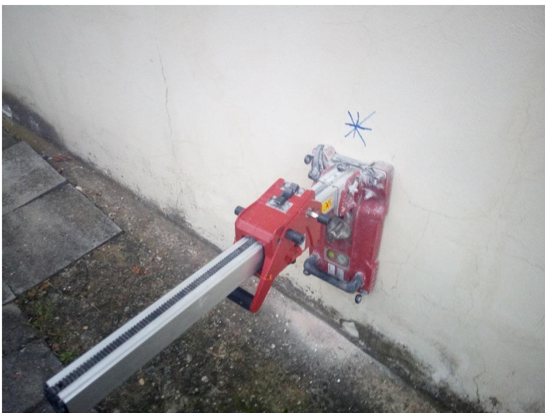
Obr. 50 – Příprava jádrového vývrtu na jižním konci západní strany, podzim 2020. (zdroj: vlastní zpracování)
