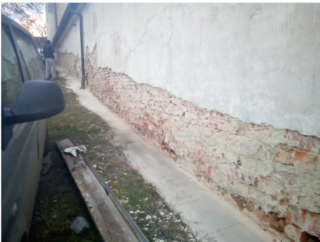
Obr. 61 – Odstraňování omítky ze západní stěny, podzim 2020. (zdroj: vlastní zpracování)
