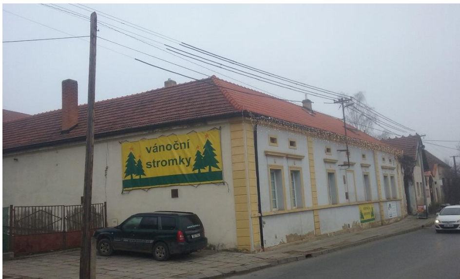
Obr. 34 – Pohled z jihozápadu na opravené střechy s částečně novou krytinou a degradovanou fasádou, zima 2019. (zdroj: vlastní zpracování)
