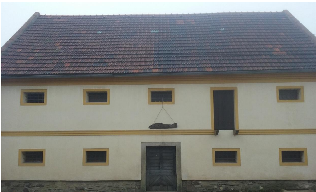
Obr. 11 – Severní průčelí špejcharu, podzim 2019. (zdroj: vlastní zpracování)
