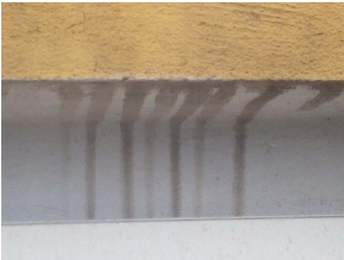
Obr. 37 – Detail podokenní římsy potvrzující použití hydrofobního nátěru, podzim 2020. (zdroj: vlastní zpracování)
