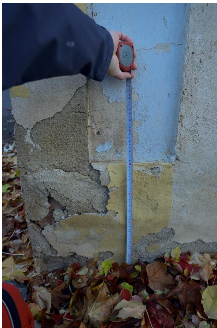
Obr. 43 – Výškové zaměření soklu východně od vjezdu, podzim 2020. (zdroj: vlastní zpracování)
