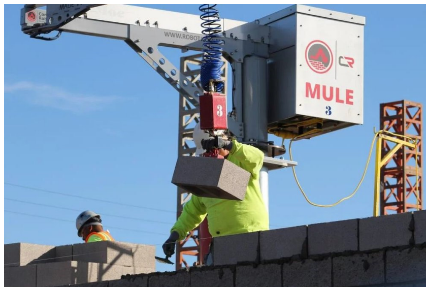
Obrázek 3 - Ukázka patentu - Building Element Lift Enhancer, převzato z [14]
