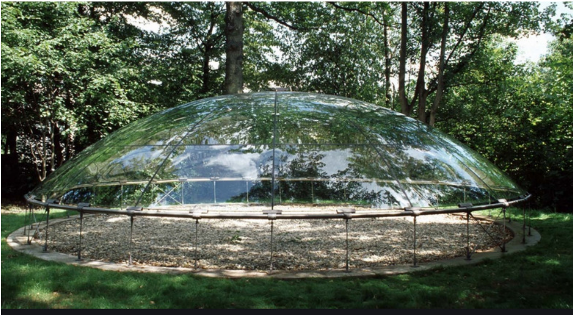
obr. 2.15: Příklad využití lepeného spoje, Glass Dome, Stuttgart (CMU Architecture, 2009)
