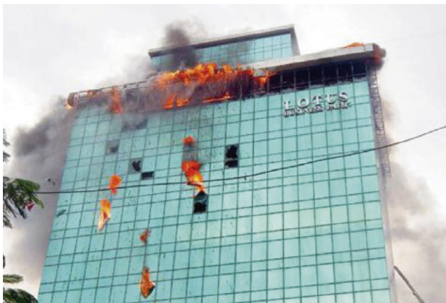
obr. 6.1: Business park Lotus, Mumbai 2014 – požár v budově s prosklenou konstrukcí obvodového pláště, skleněné střepy dopadaly do velké vzdálenosti od fasády
