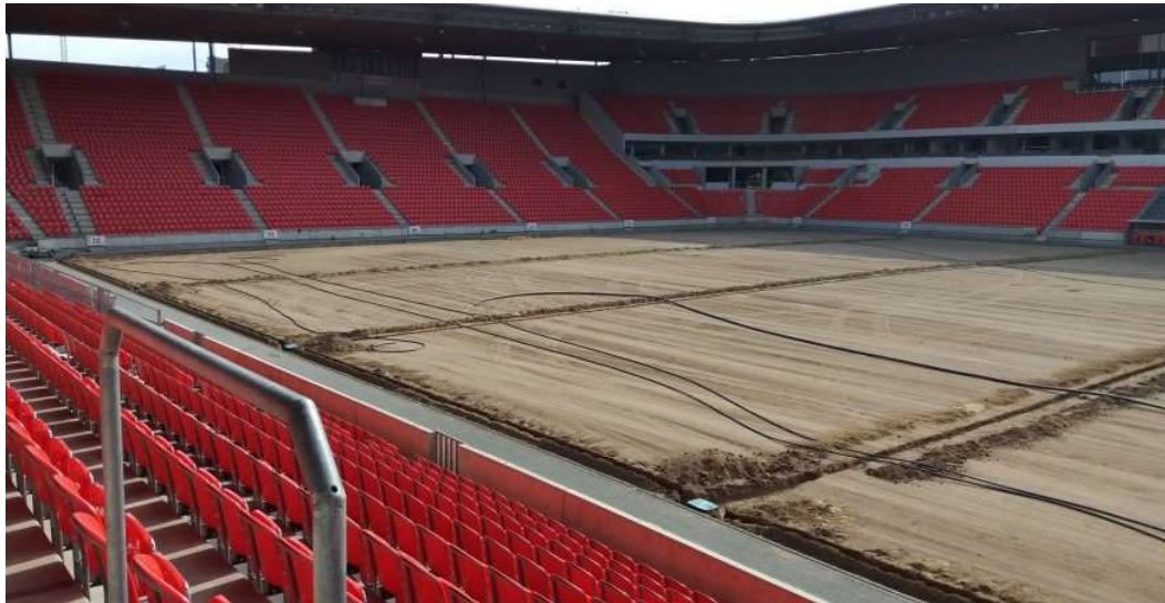
Obr. 12: Realizace závlahového systému - Praha, Sinobo Stadium, SK Slavia Praha (33)
