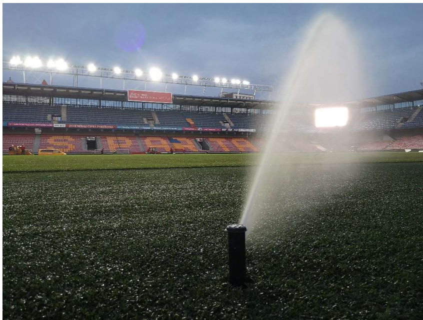
Obr. 16: Rotační postřikovač - fotbalový stadion Generali Arena, AC Sparta Praha; Autor: Gabriel Hudymač
