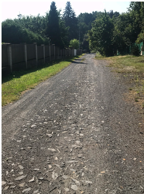
Obrázek 9: Nestmelený povrch komunikace (foto autor)
