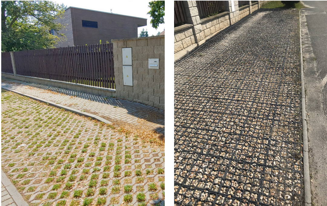
Obrázek 12: Příklady zatravnovacích dílců – betonová dlažba (vlevo) a plastové rošty (vpravo) (foto autor)
