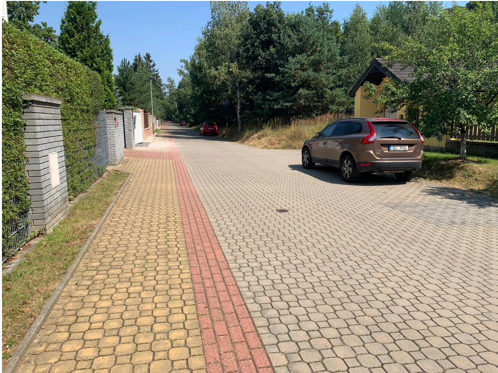
Obrázek 11: Příklad krytu z betonové dlažby (foto autor)
