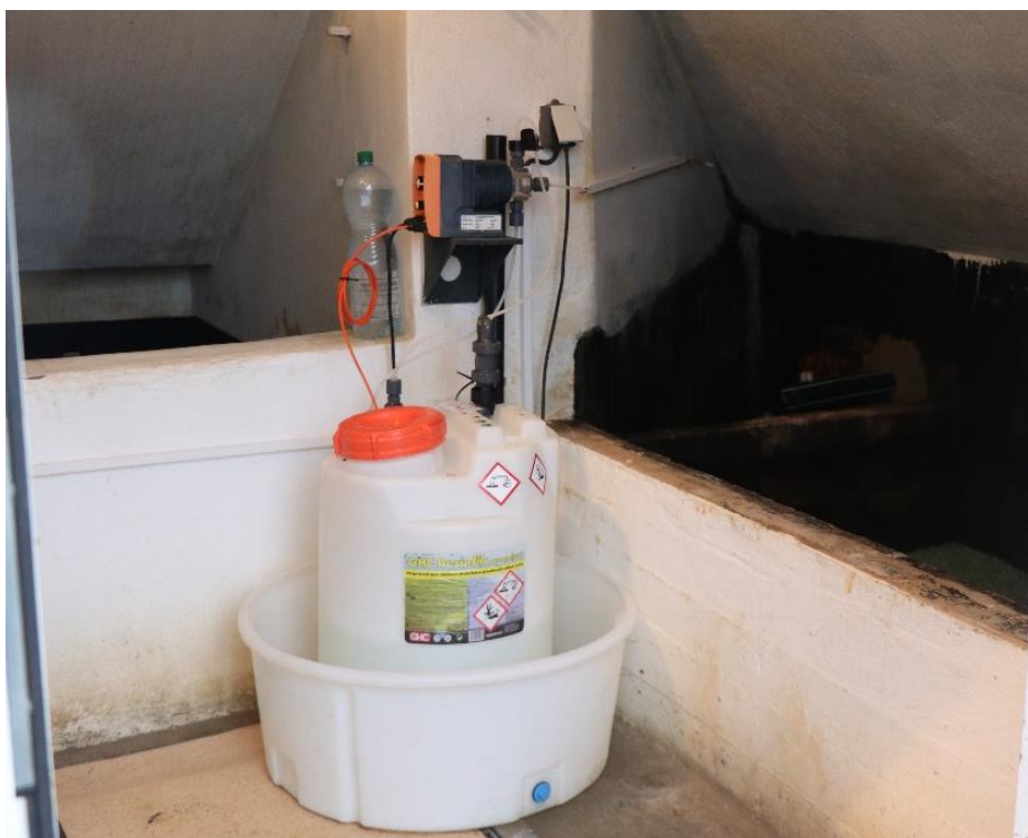
Obr. č. 17 Dávkovač chlornanu sodného ve VDJ Sněhov
