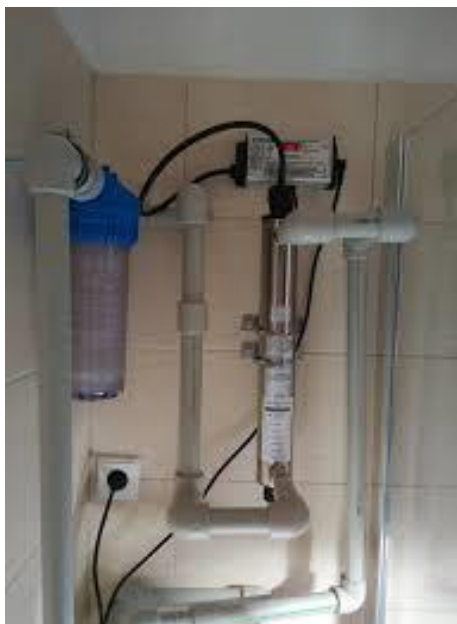
Obr. č. 12 Zapojení UV Lampy
