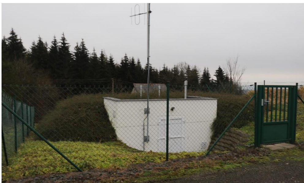
Obr. č. 18 Snímek Vodojemu Malá Skála - Filka
