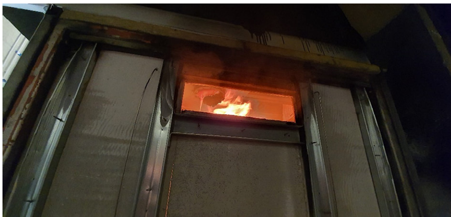
Obr. 59: aktivace protipožární manžety, na trapézovém plechu lze vidět roztavenou parotěsní fólii
