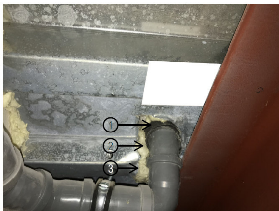
① Intumescentní pásek ② Montážní PUR pěna třídy reakce na oheň "E" ③ Rozhraní vln trapézového plechu
