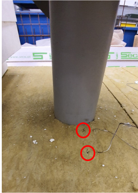
Obr. 39: umístění termočlánků č. 4 a 5 nad minerální izolací
