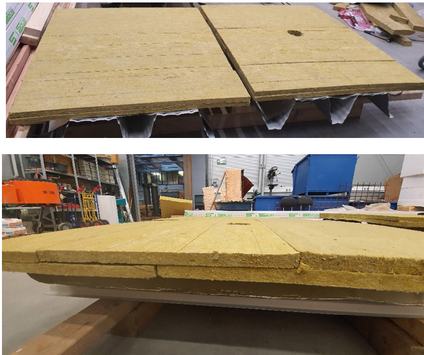
Obr. 38: kladení minerální izolace
