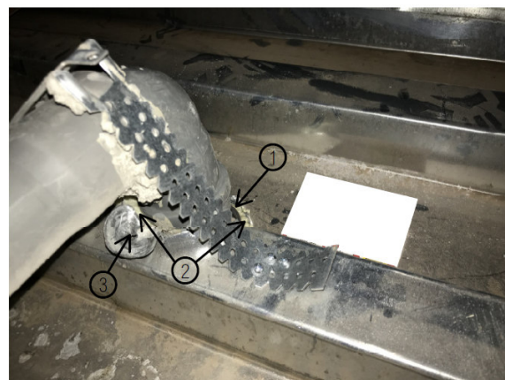
① Intumescentní pásek ② Montážní PUR pěna třídy reakce na oheň "E" ③ Rozhraní vln trapézového plechu
