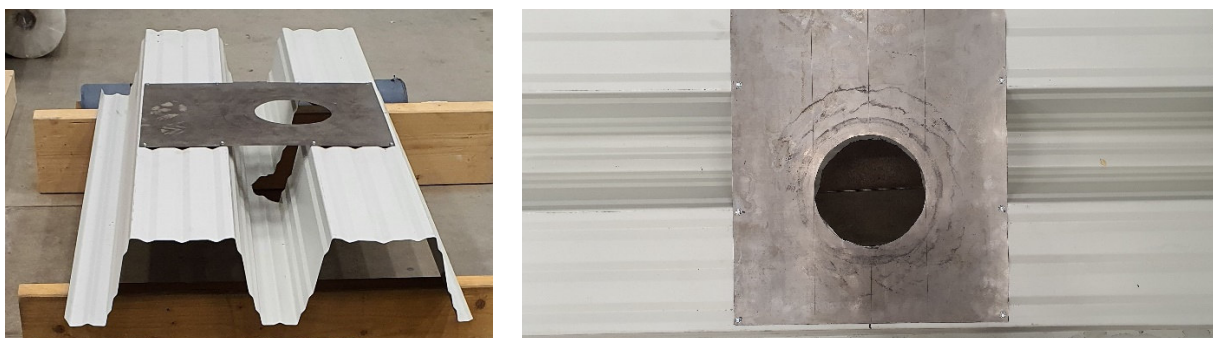
Obr. 36: trapézový plech se zakotveným podkladním plechem
