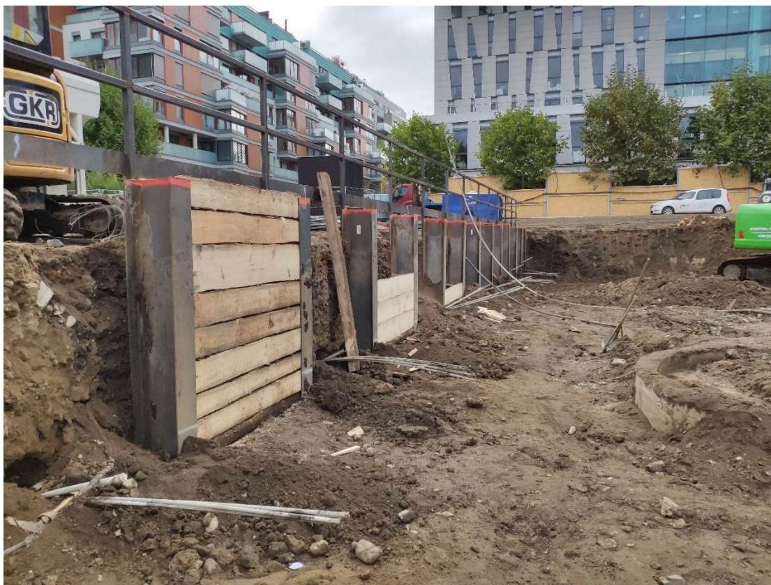
Obrázek 11 – Montáž kotev záporového pažení
