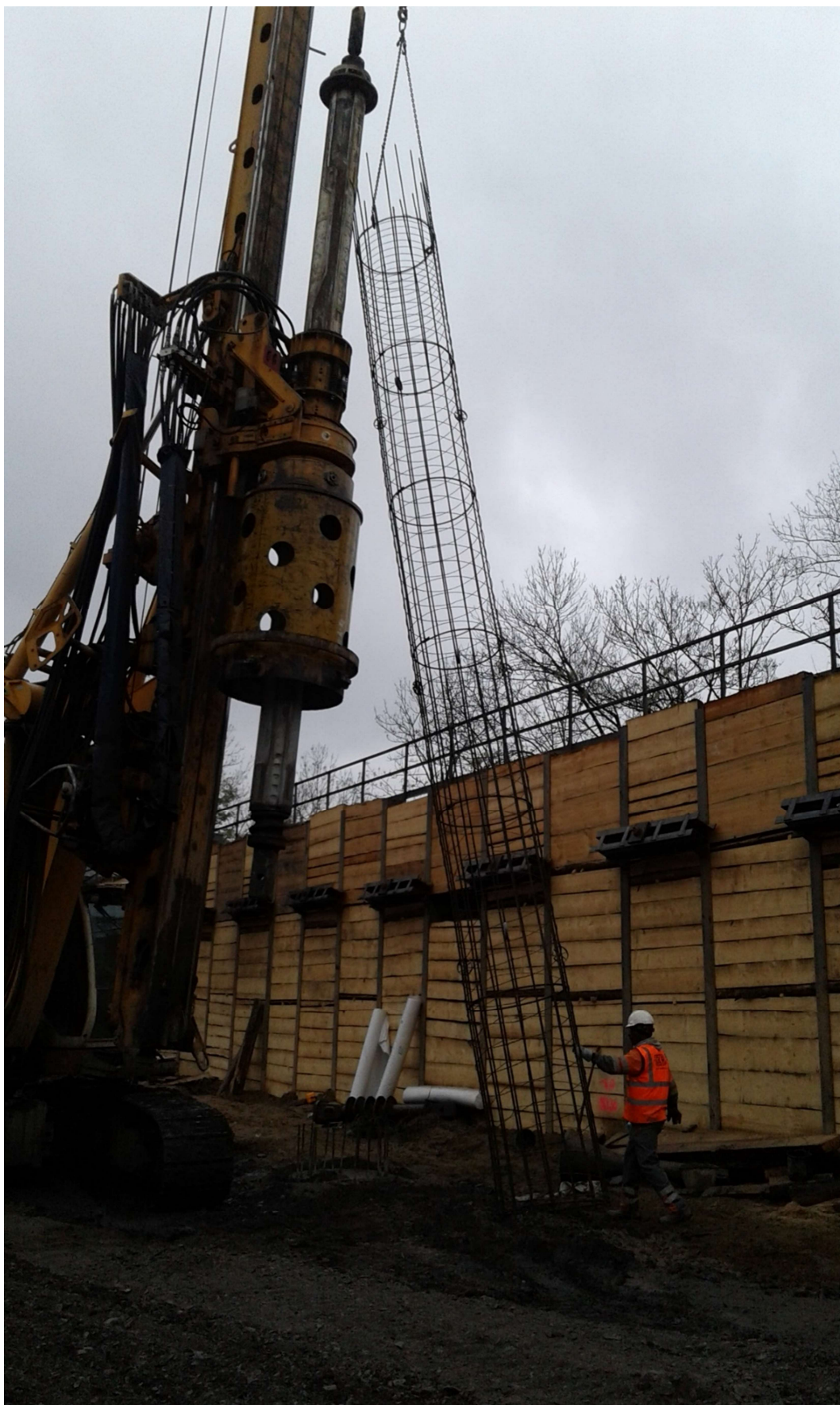
Obrázek 16 - Osazení armokošu
