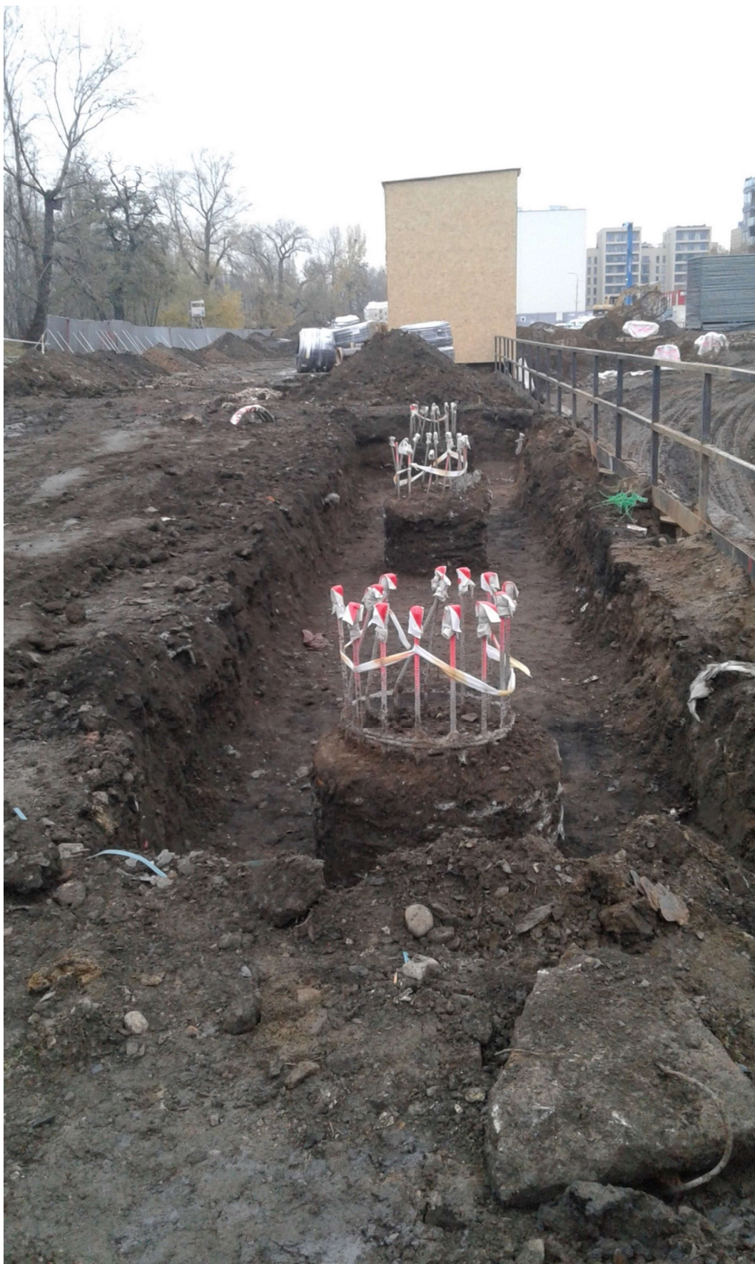
Obrázek 19 - Hotové piloty pod parkovacím místem
