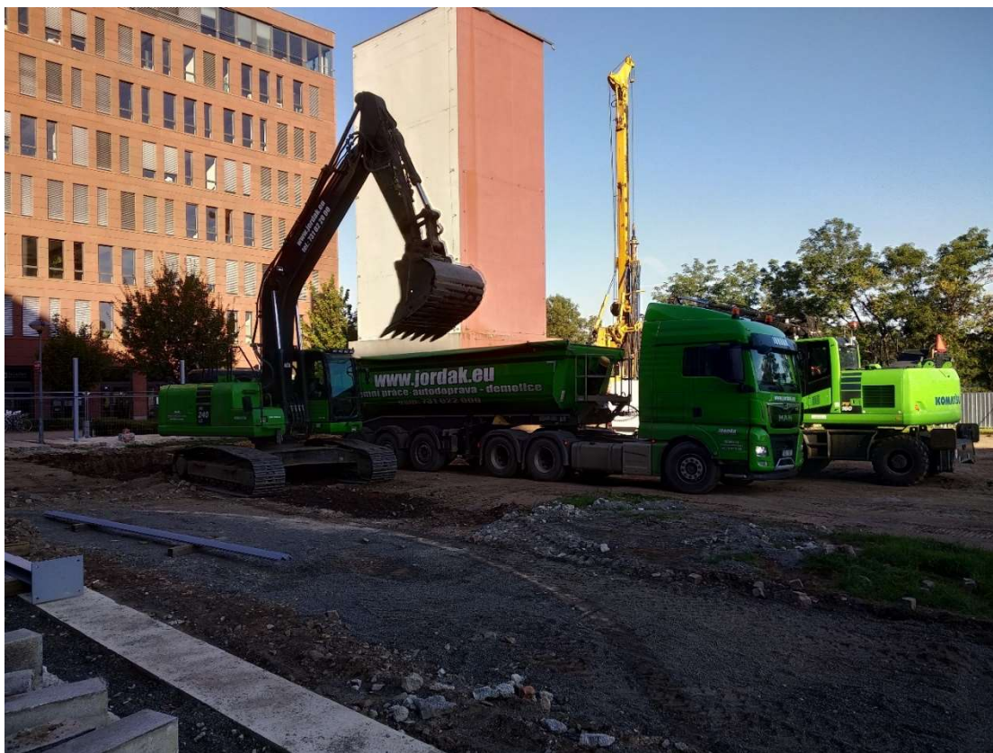
Obrázek 2 - Výkopové práce a zahájení montáže zápor
