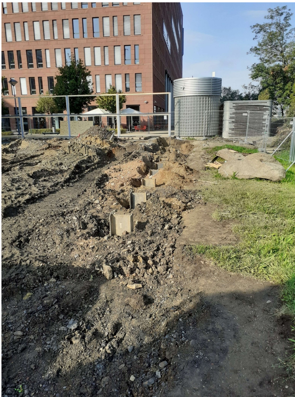
Obrázek 7 - Namontované pažiny v osách 1–3
