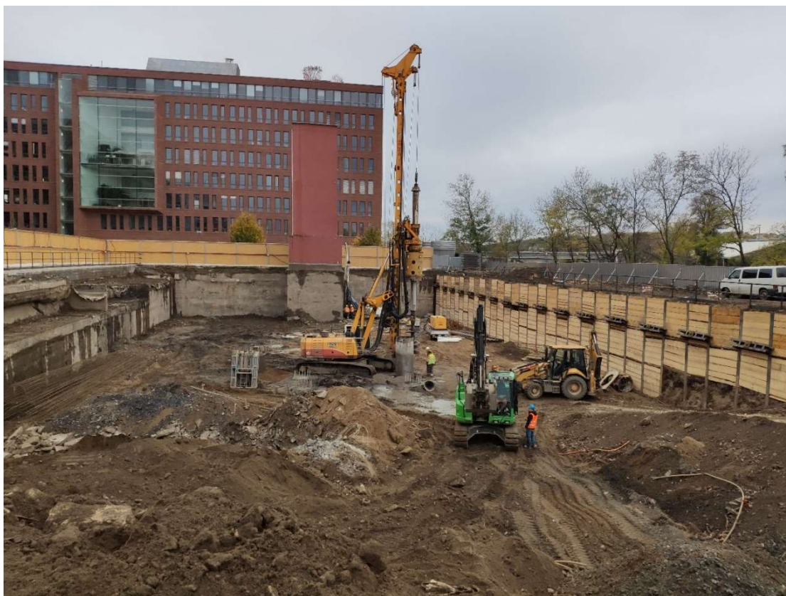
Obrázek 13 - Pažení severní strany osa A
