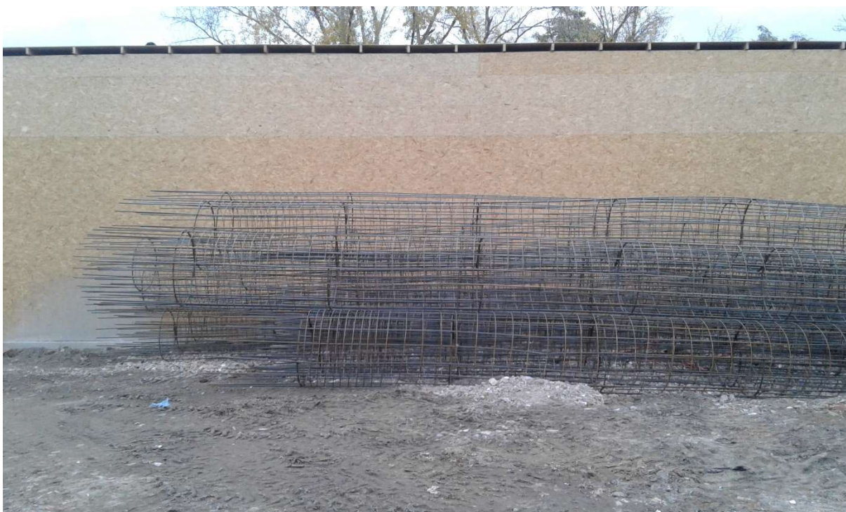
Obrázek 14 - Skládka armokošů
