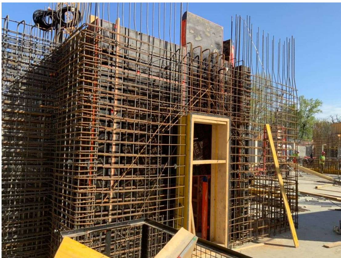
Obrázek 28 - Výztuž schodišťové šachty B2
