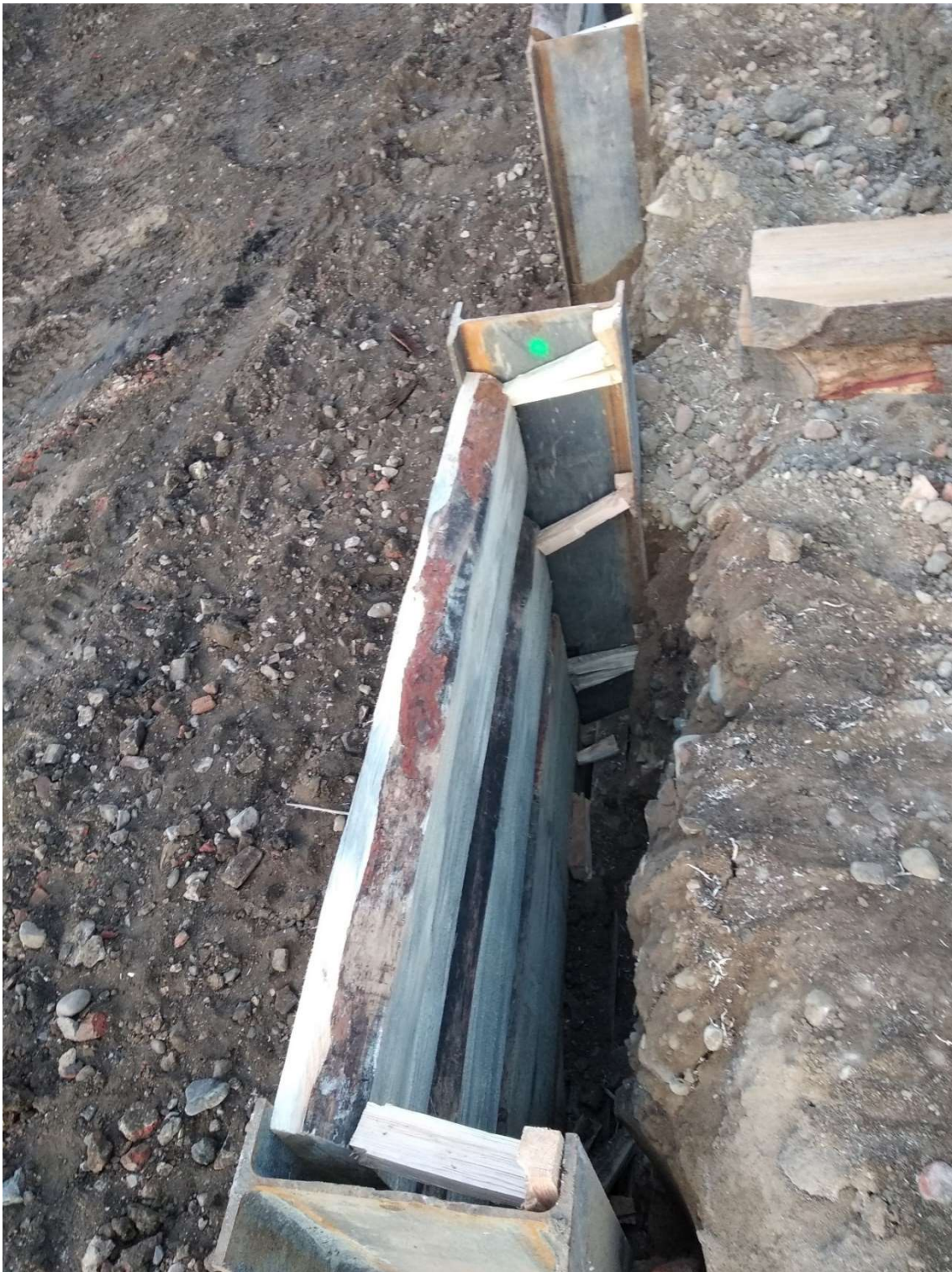
Obrázek 8 - Usazené pažiny pomocí klinů
