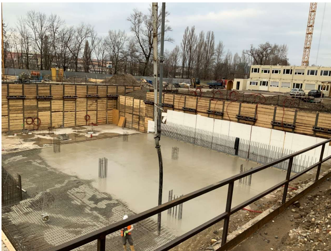
Obrázek 24 - Betonáž základové desky B3
