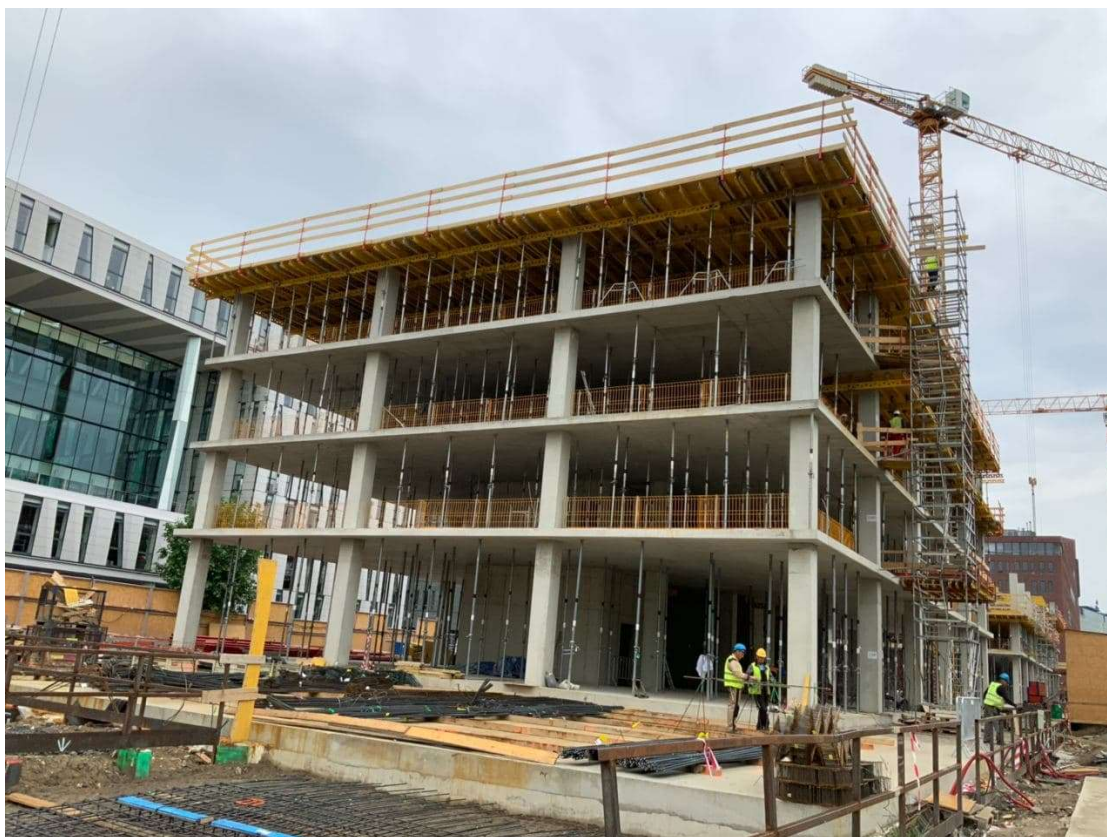
Obrázek 33 - Podstrojované stropy 1NP až 4NP budova B2
