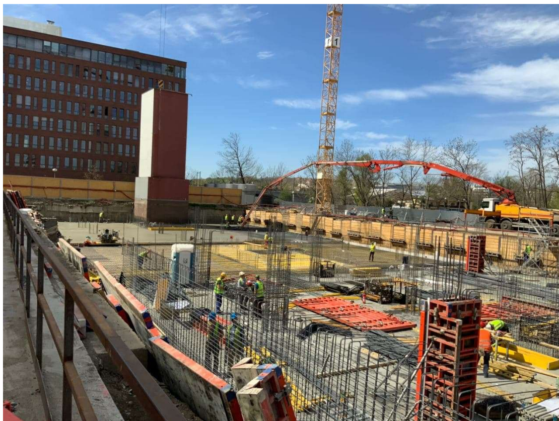
Obrázek 27 - Betonáž stropu 2PP B2
