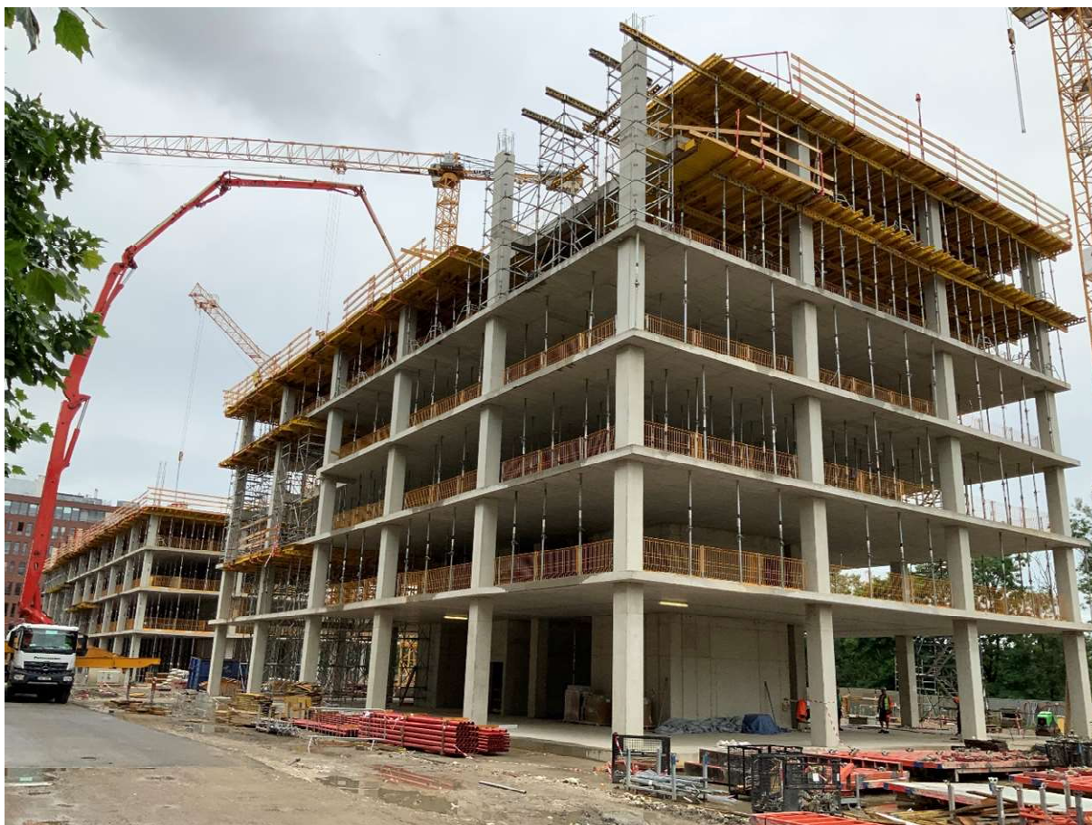
Obrázek 34 - Betonáž stropu 6NP budova B2
