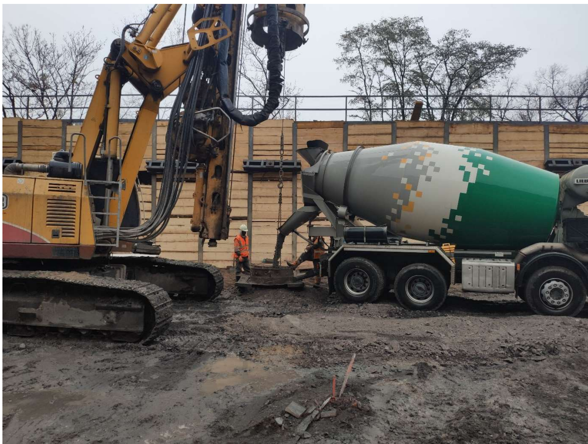
Obrázek 17 - Zalití piloty betonem
