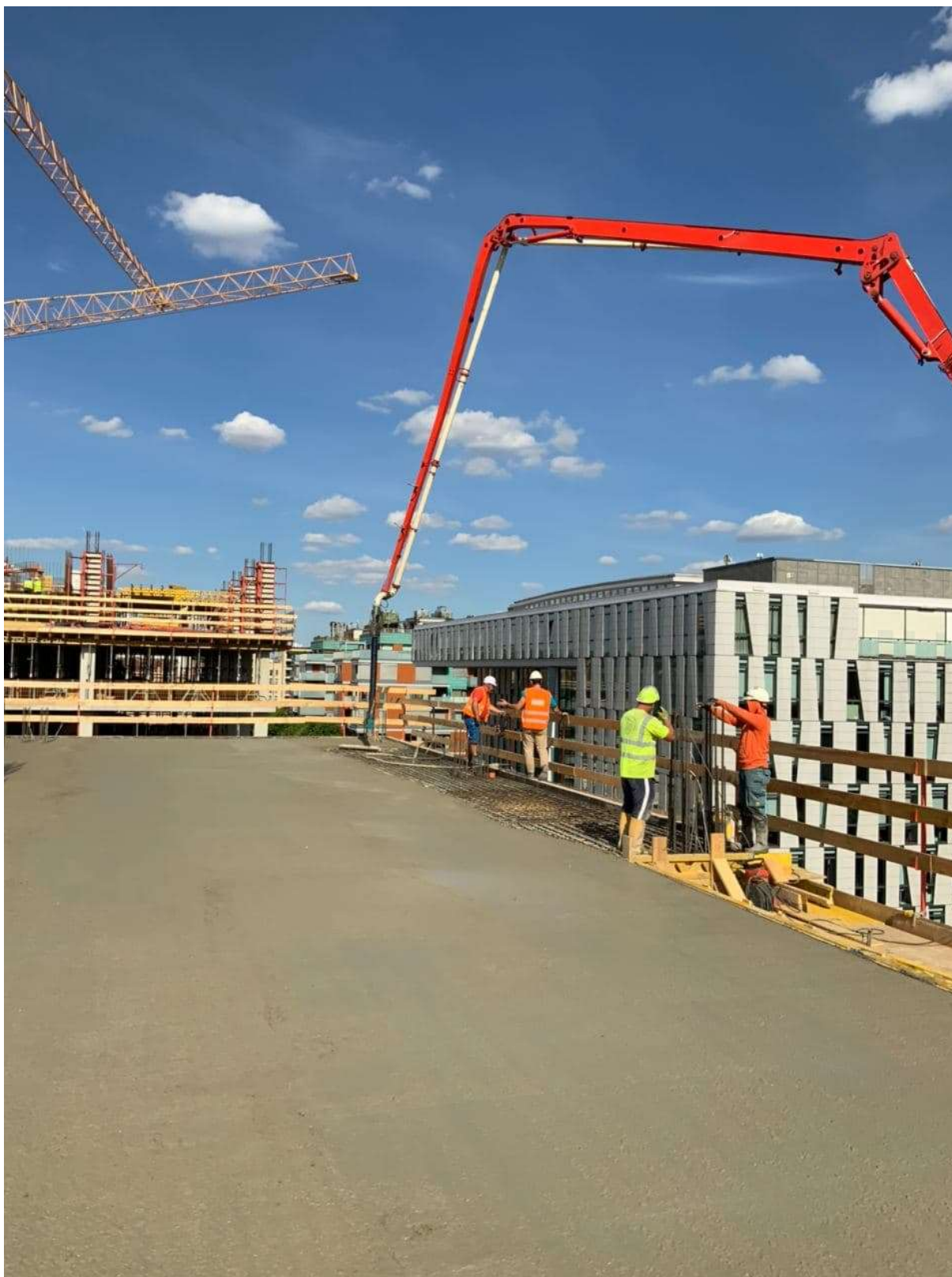
Obrázek 31 - Betonáž stropu 4NP B2
