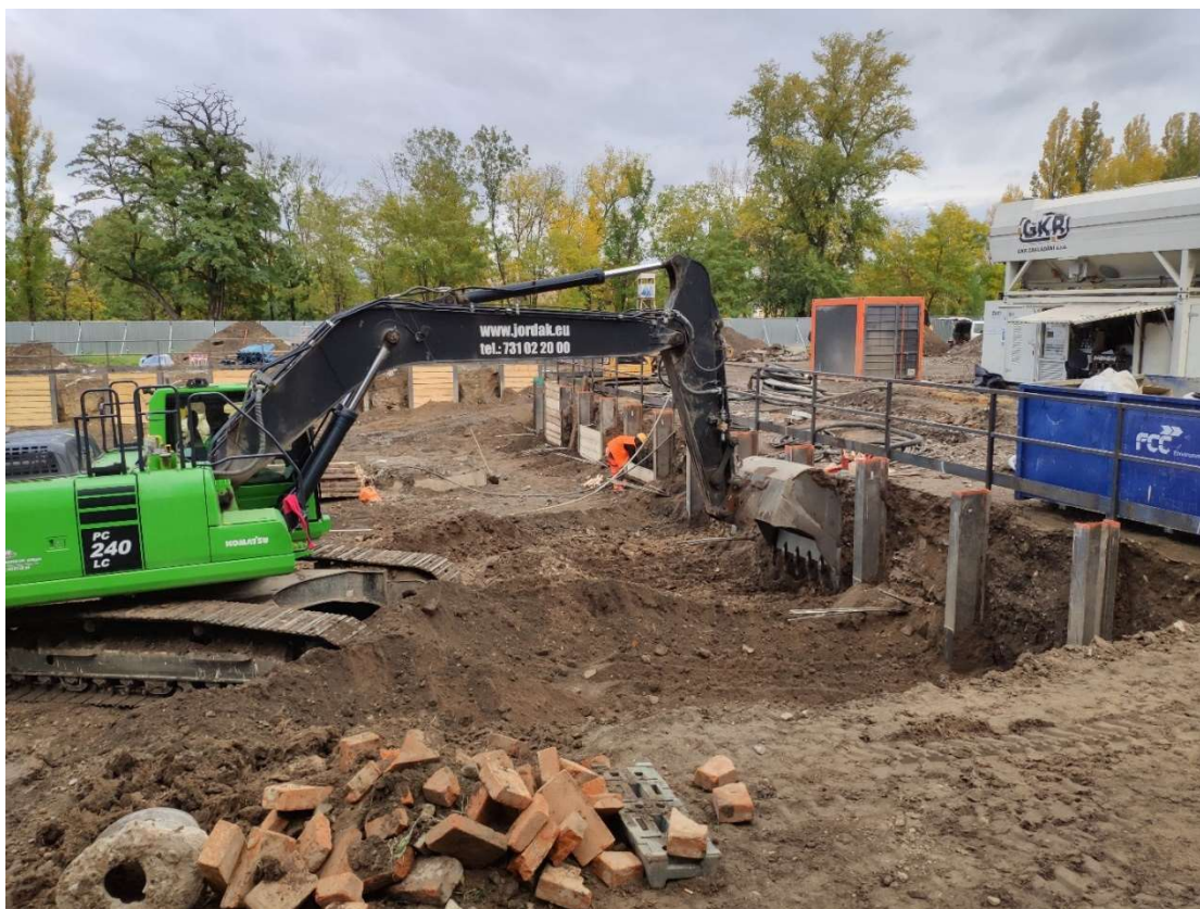
Obrázek 10 – Odkopání a montáž zápor v ose 20
