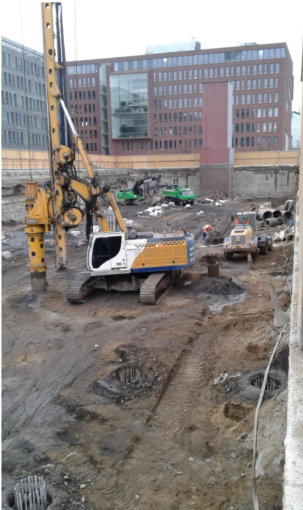
Obrázek 18 - Vrtání pilotovací soupravou
