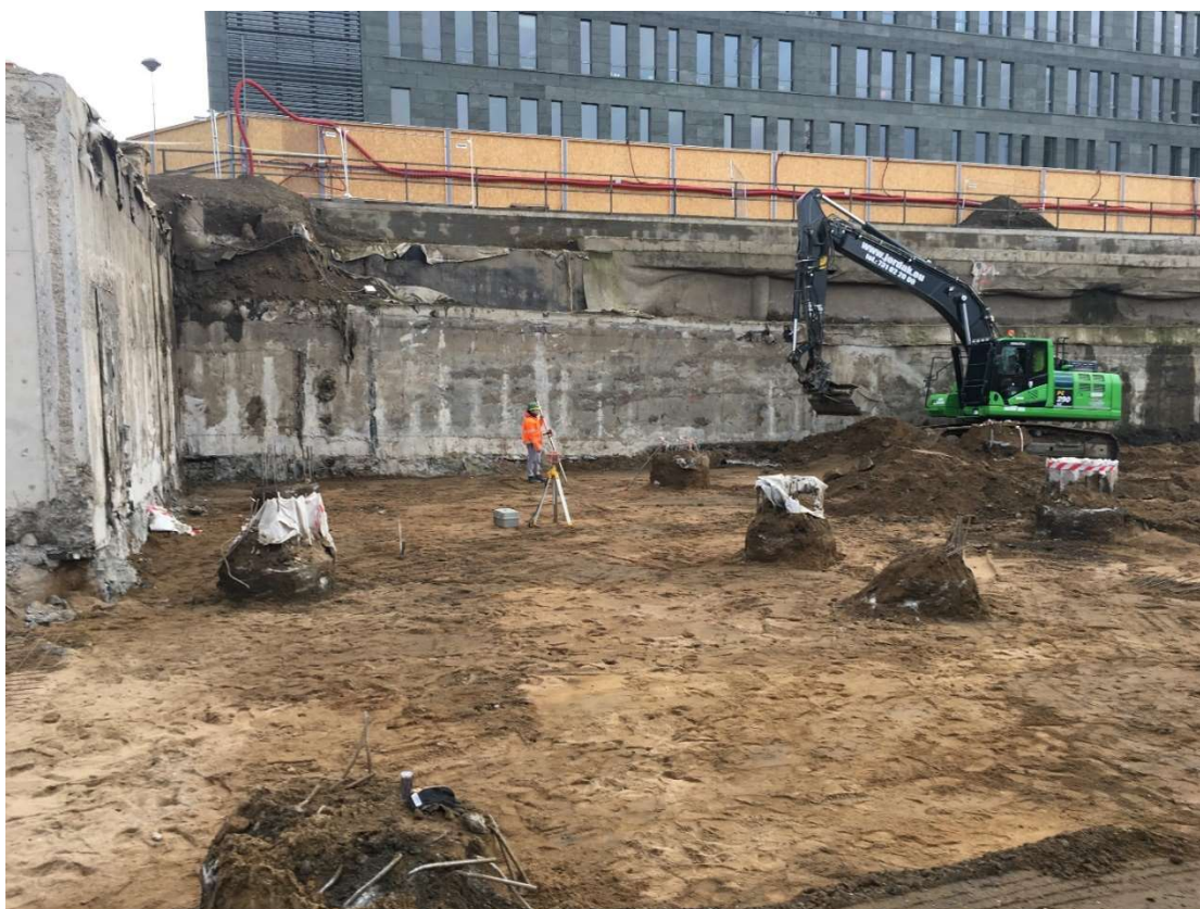
Obrázek 5 - Měření hloubky vykopu pomocí nivelačního přístroje
