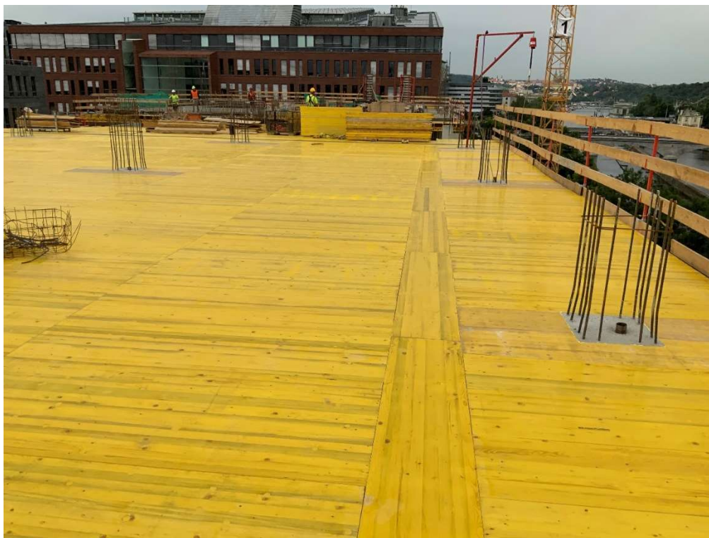
Obrázek 29 - Montáž bednění stropu 4NP B2
