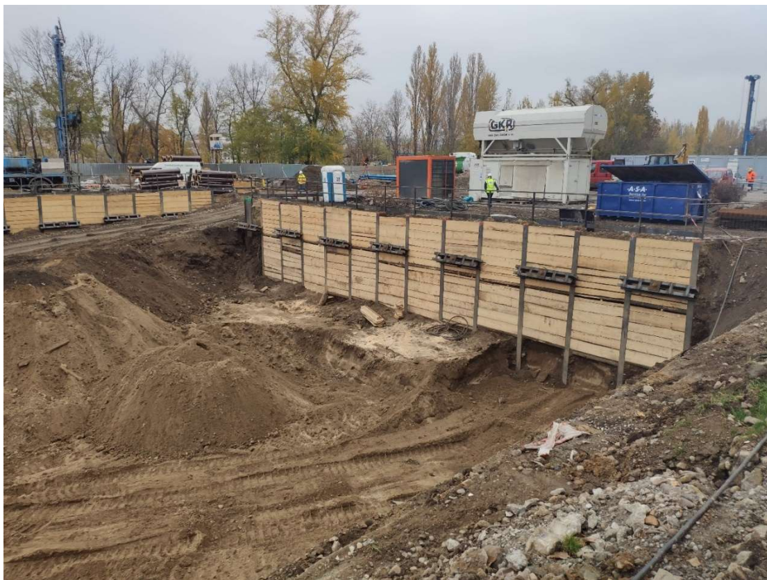
Obrázek 12 - Pažení v ose 20
