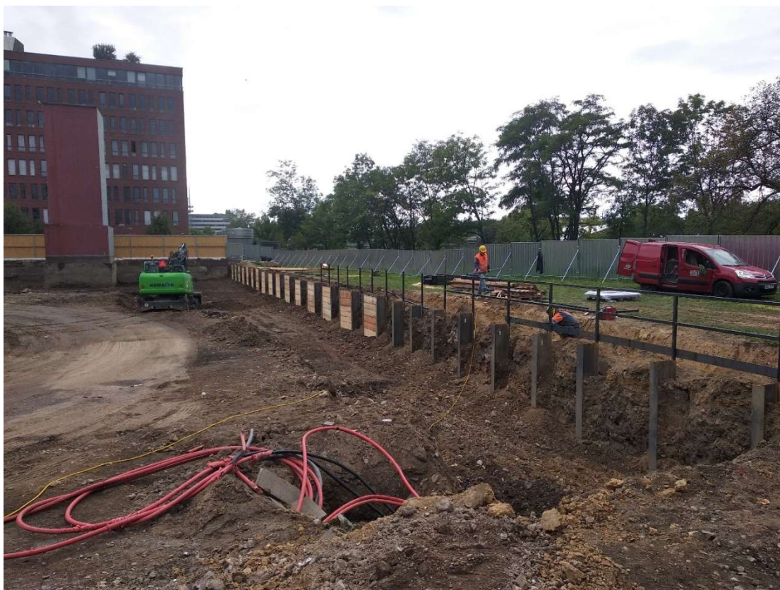
Obrázek 9 - Montáž pažin a ocelového zábradlí
