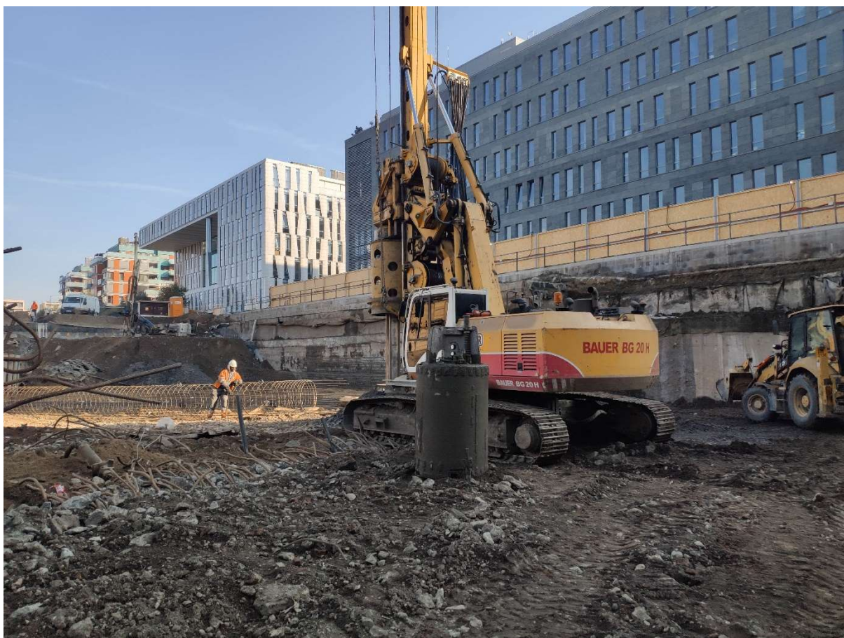
Obrázek 15 - Pilotovací souprava BAUER BG 20 H
