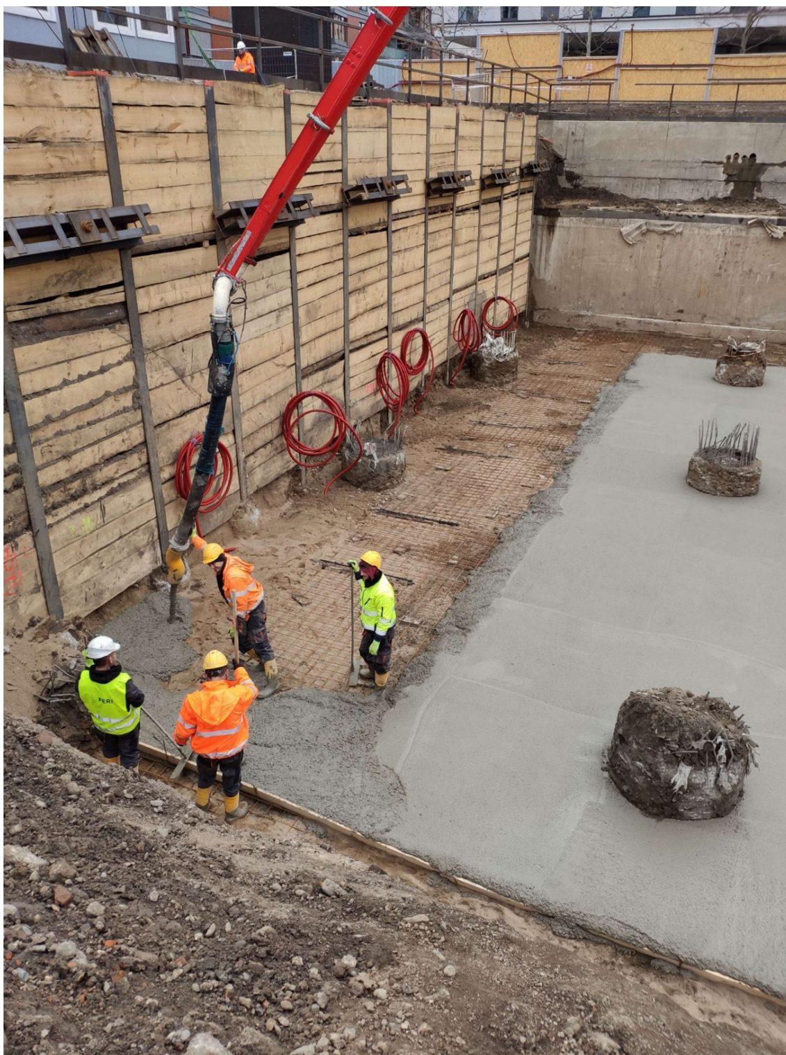
Obrázek 21 - Zalití podkladního betonu
