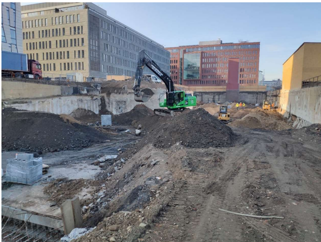
Obrázek 4 - Odkopání na pilotovací úroveň
