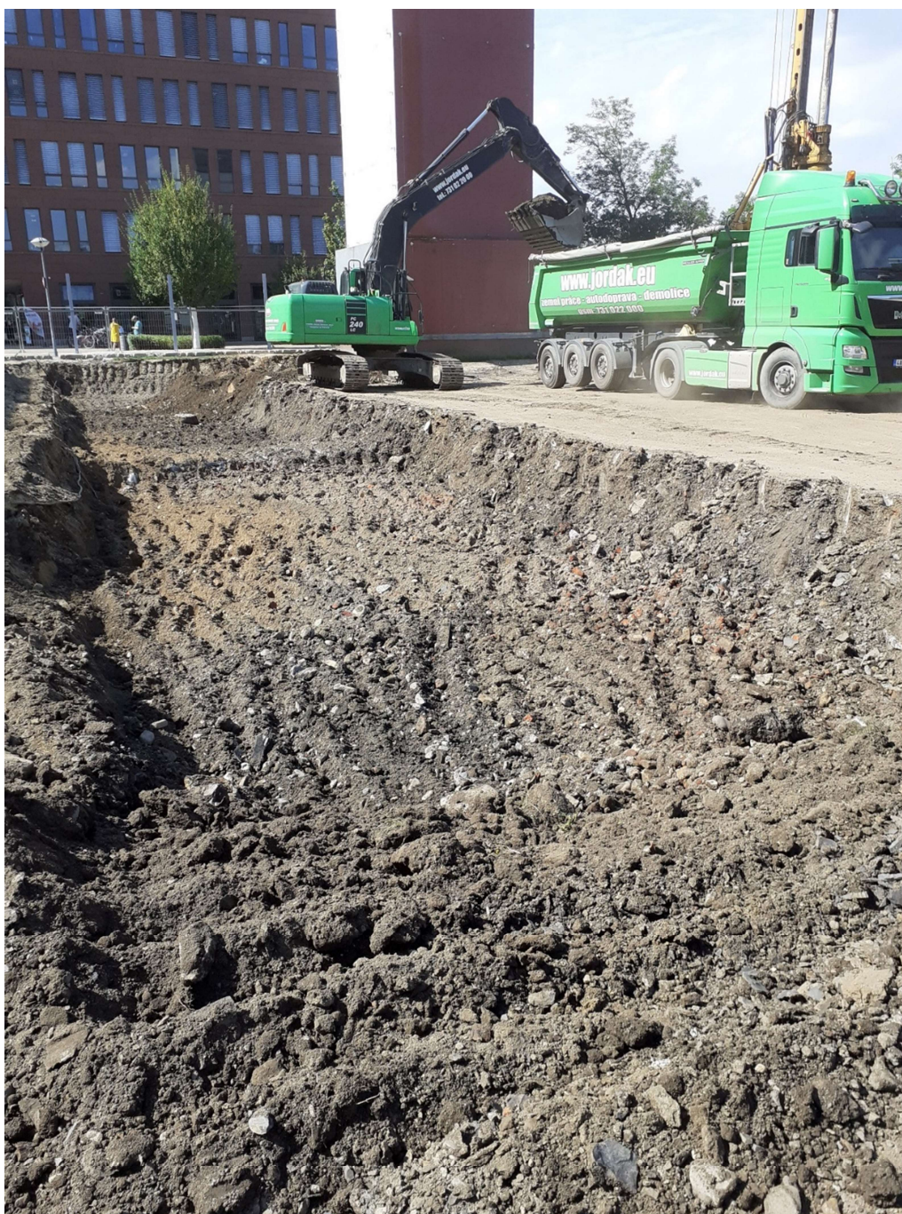
Obrázek 1 – Zahájení výkopových prací
