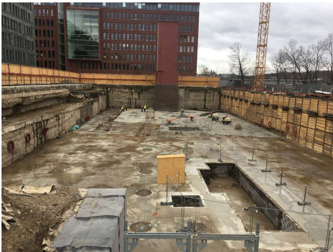
Obrázek 22 - Podkladní beton budova B2
