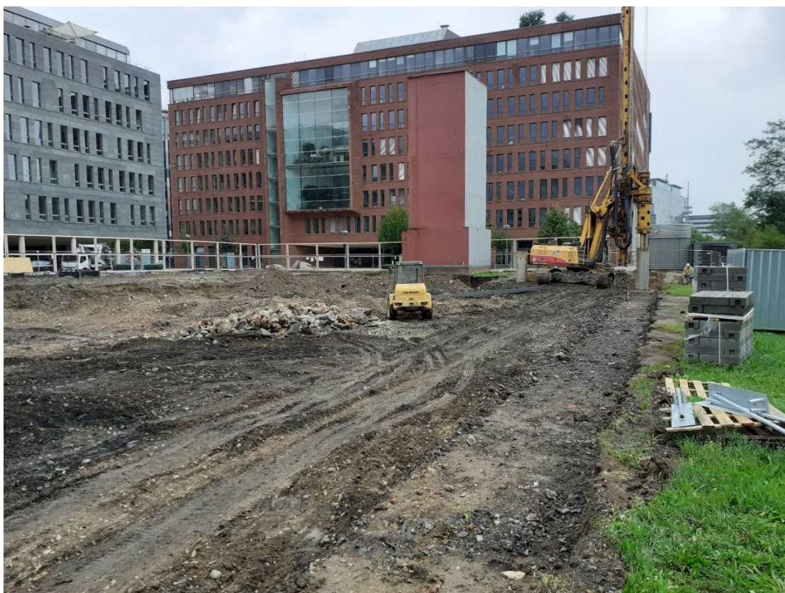
Obrázek 6 - Zahájení montáže pažin
