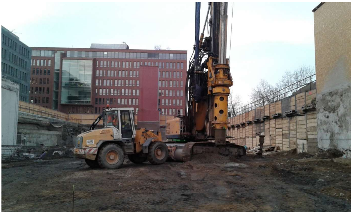
Obrázek 20 - Odvoz odkopané zeminy na skládku
