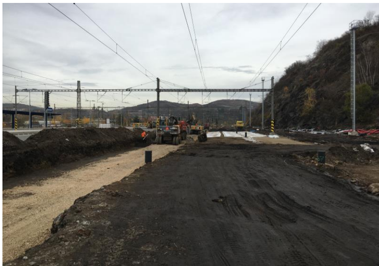
Obr. 46 Zemní pláň v ŽST Beroun
