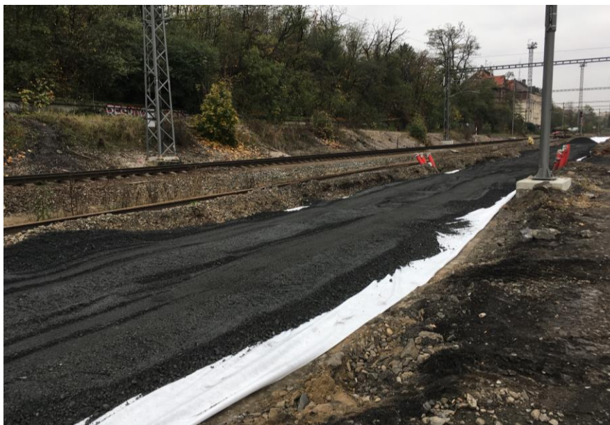
Obr. 58 Rozprostřená podkladní vrstva v zast. Praha-Eden
