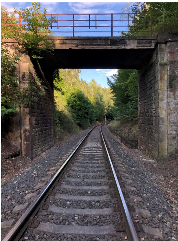
Obrázek 34: Silniční nadjezd v km 56,272
