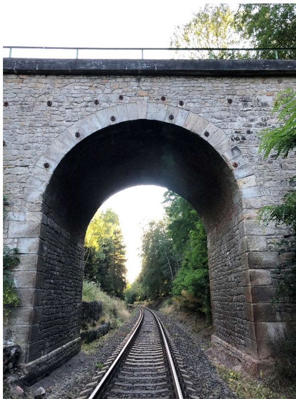
Obrázek 29: Silniční nadjezd v km 55,185
