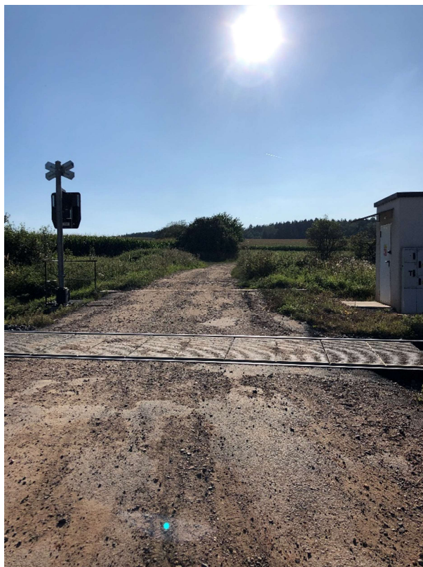
Obrázek 7: Železniční přejezd P38 v km 49,760
