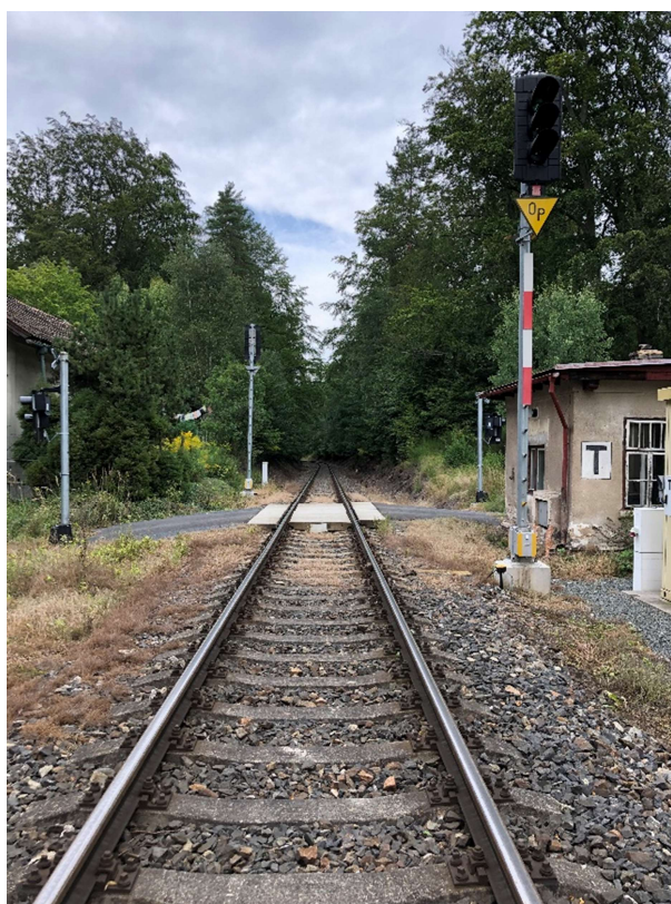
Obrázek 38: Železniční přejezd P41 v km 57,730
