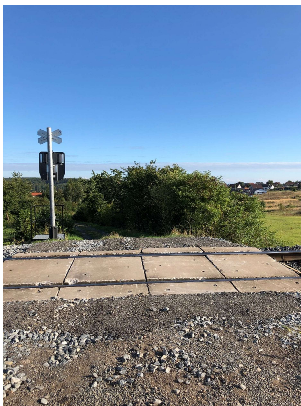
Obrázek 12: Železniční přejezd P39 v km 50,569
