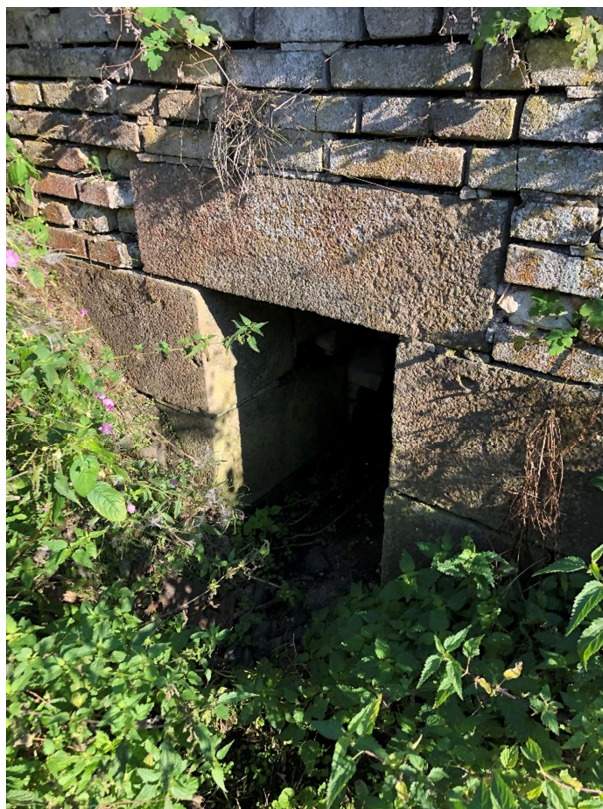
Obrázek 13: Zarostlý deskový propustek v km 50,586
