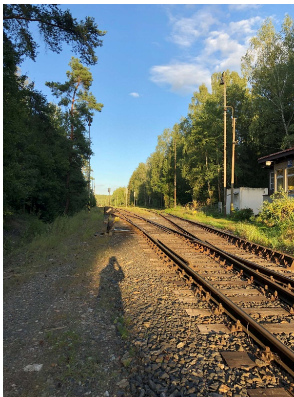
Obrázek 26: Vjezd do železniční stanice Řevničov (pohled proti směru staničení)
