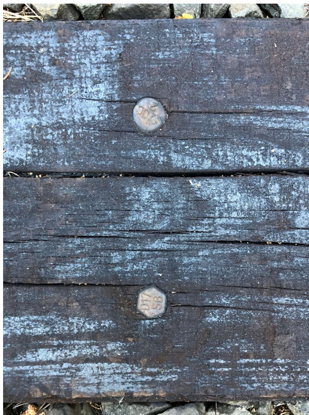
Obrázek 31: Dřevěný pražec z buku ve směrovém oblouku č. 6
