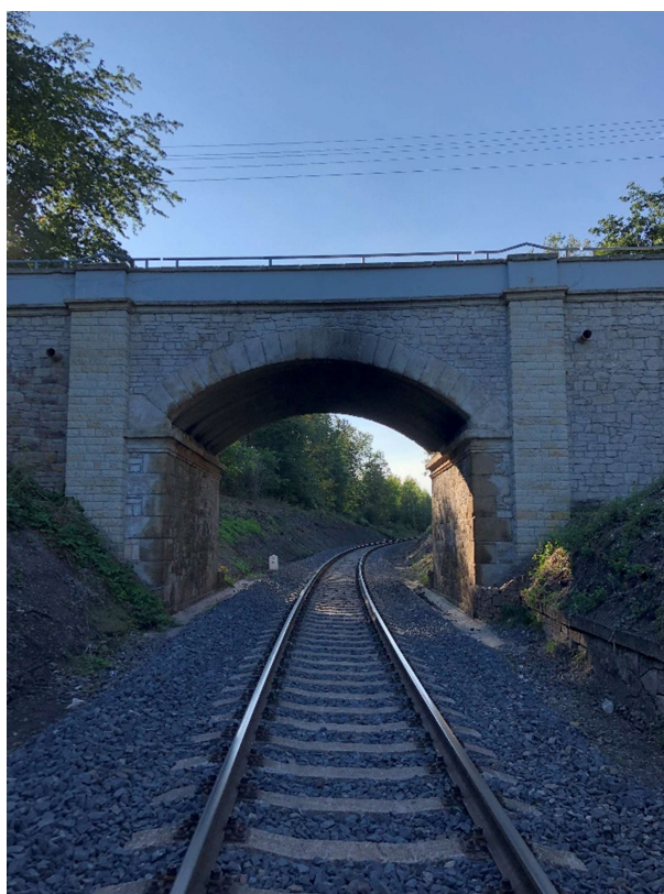
Obrázek 14: Silniční nadjezd v km 50,990
