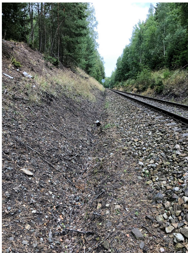
Obrázek 44: Zanesený nebezpečný příkop v přímém úseku
