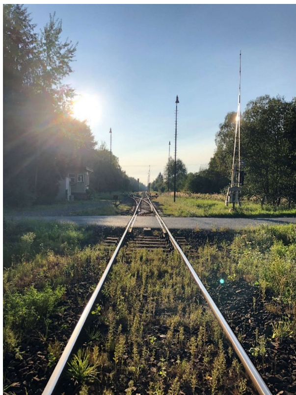
Obrázek 22: Vjezd do železniční stanice Řevničov spolu se železničním přejezdem P40 v km 52,896
