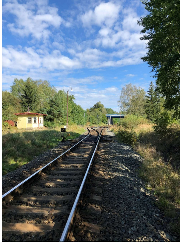
Obrázek 1: Vjezd do železniční stanice Nové Strašecí (pohled proti směru staničení)
