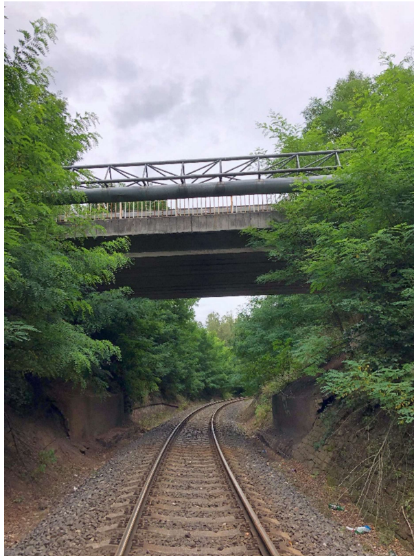
Obrázek 47: Silniční nadjezd v km 59,954 (pohled proti směru staničení)
