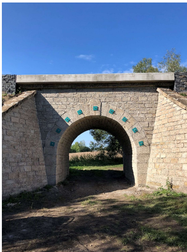
Obrázek 4: Železniční most v km 49,055
