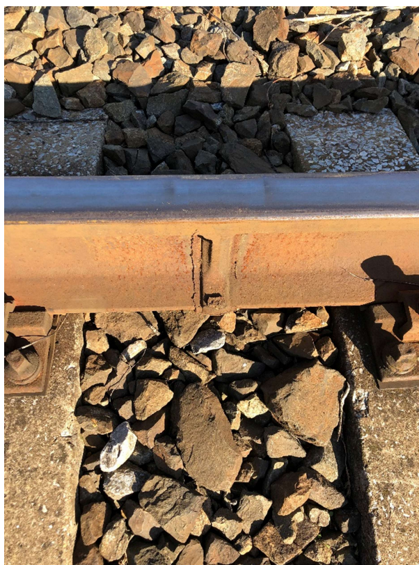
Obrázek 6: Svar kolejnice
