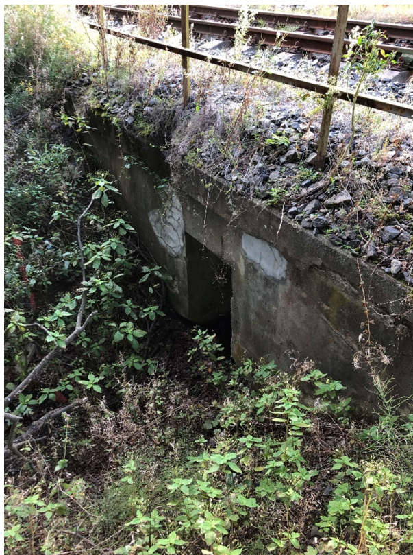
Obrázek 23: Deskový propustek (18282) v km 53,016
