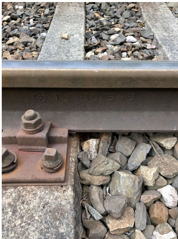
Obrázek 42: Kolejnice tvaru S 49 z roku 1990 vyrobená v Třineckých železárnách spolu s nepřímým upevněním
