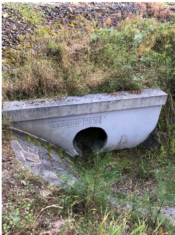
Obrázek 27: Trubní propustek (18285) v km 54,003
