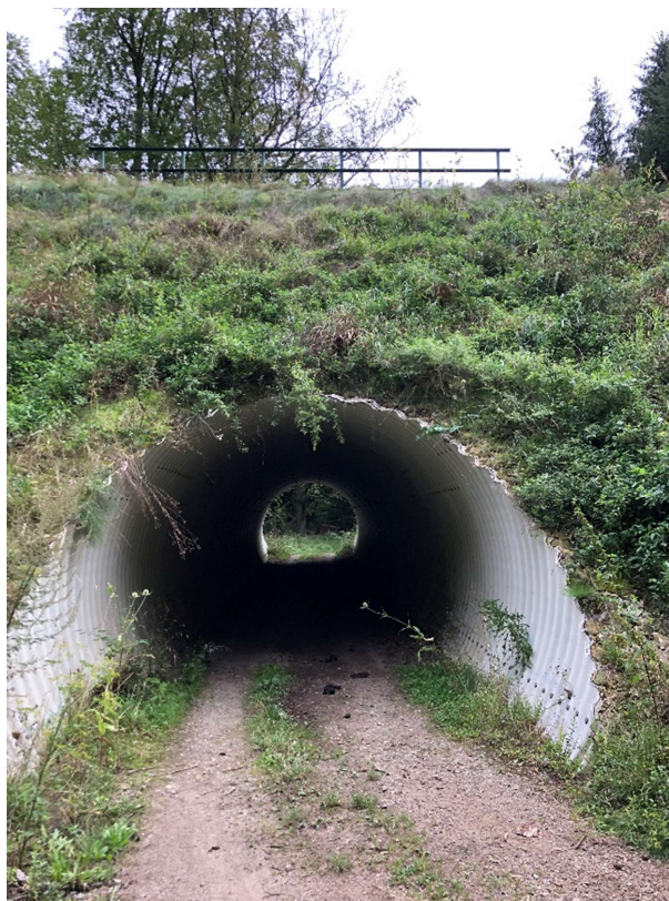
Obrázek 43: Mostní objekt v km 58,231
