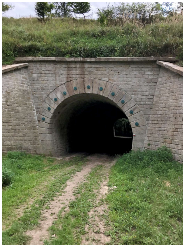
Obrázek 37: Železniční most v km 57,542
