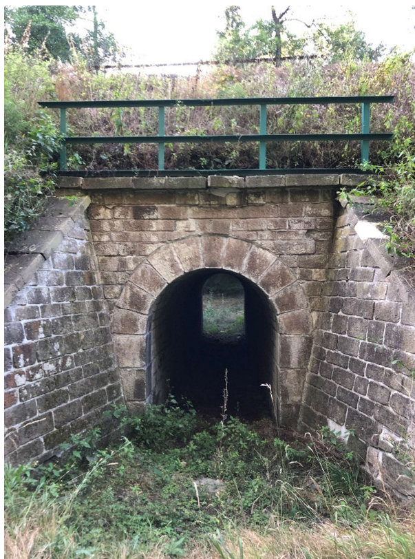
Obrázek 30: Klenutý propustek v km 55,482
