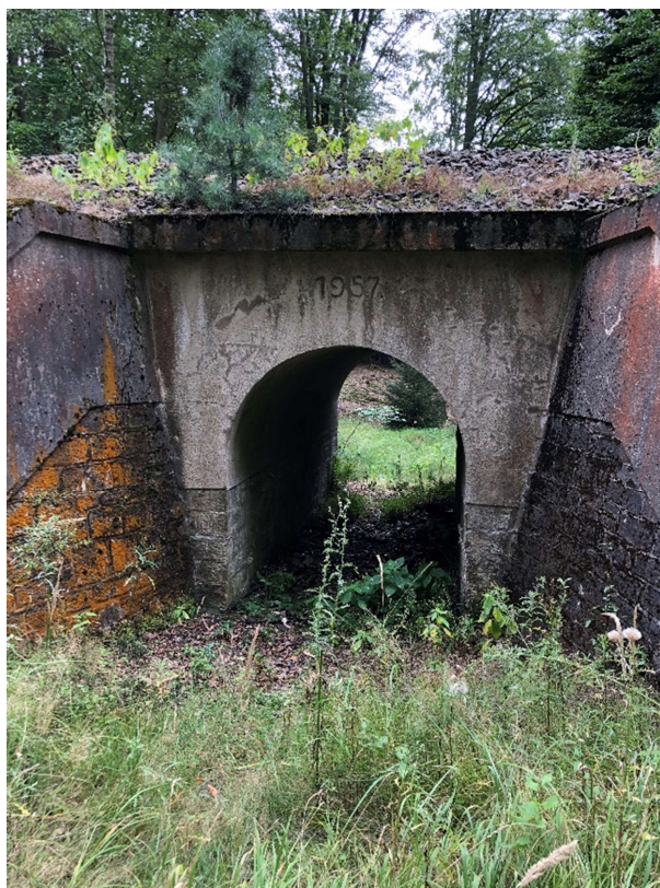
Obrázek 40: Klenutý propustek v km 58,017
