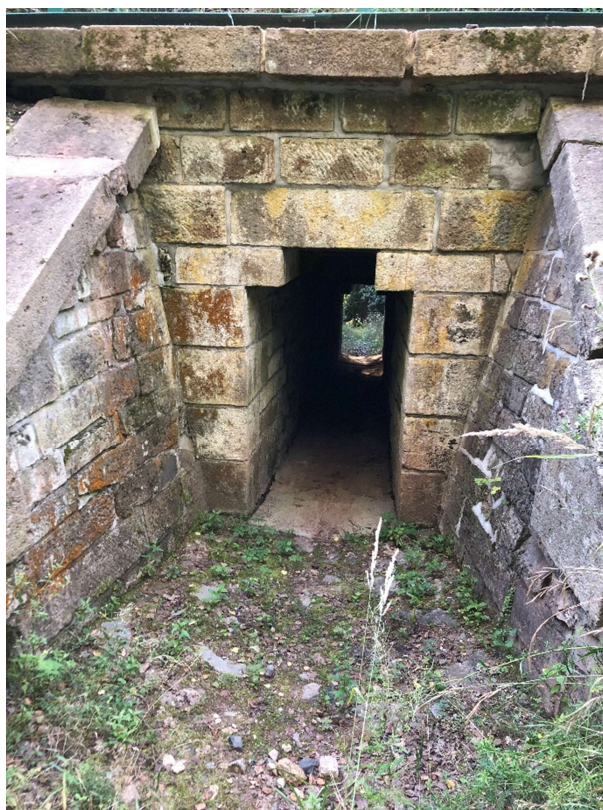
Obrázek 32: Deskový propustek v km 55,690
