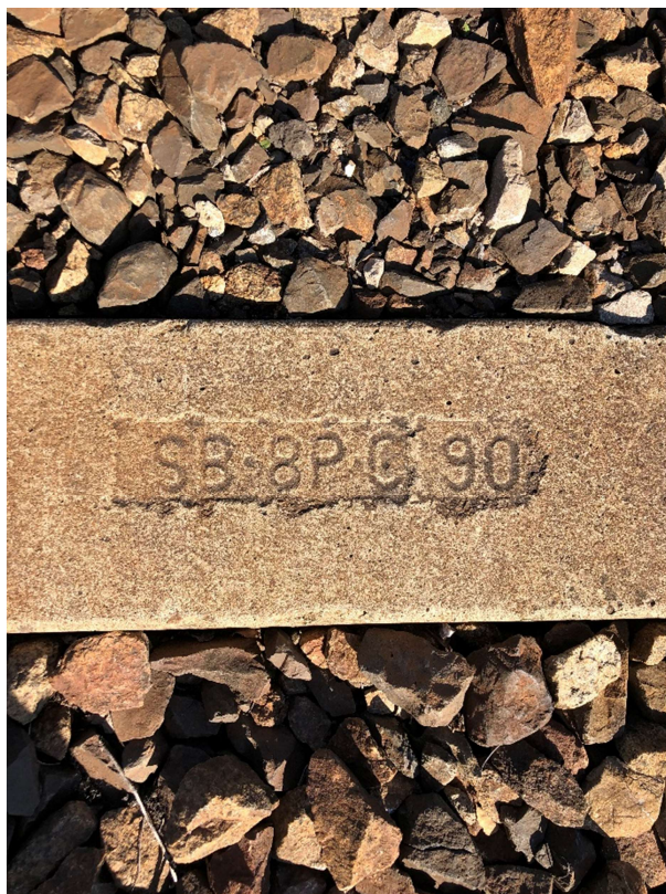
Obrázek 3: Betonový pražec SB 8 P z roku 1990
