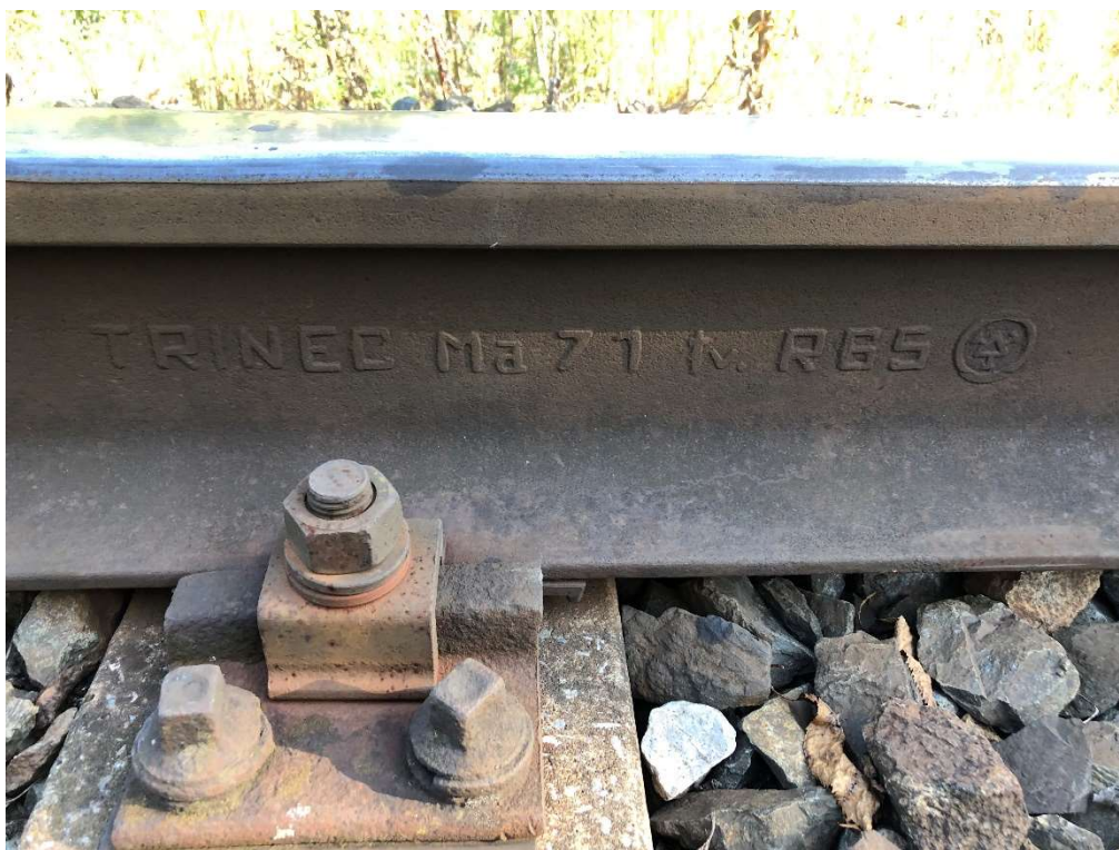
Obrázek 5: Kolejnice tvaru R 65 z roku 1971 vyrobena v Třineckých železárnách spolu s nepřímým upevněním
