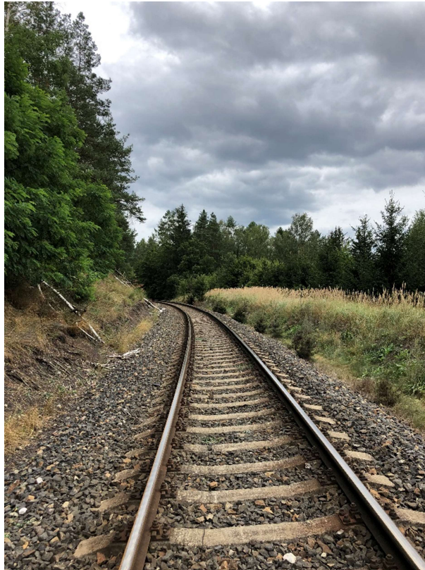
Obrázek 45: Směrový oblouk č. 9 (pohled proti směru staničení)
