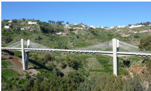
(c) Viaducto de Teror – fotografie
