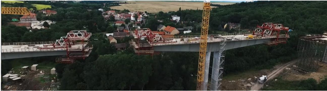
Obrázek 1 Most přes údolí Chomutovky, Velemyšleves [1]
