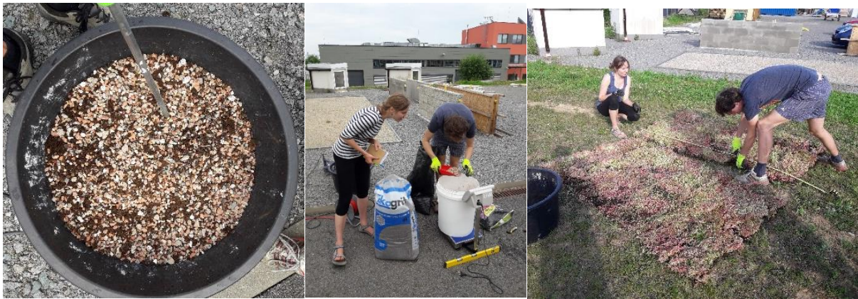
Obrázek 18: Příprava substrátu, homogenizace směsi (vlevo); Navažování materiálu pro přípravu substrátu (uprostřed); Úprava velikosti vegetační rohože (vpravo)
