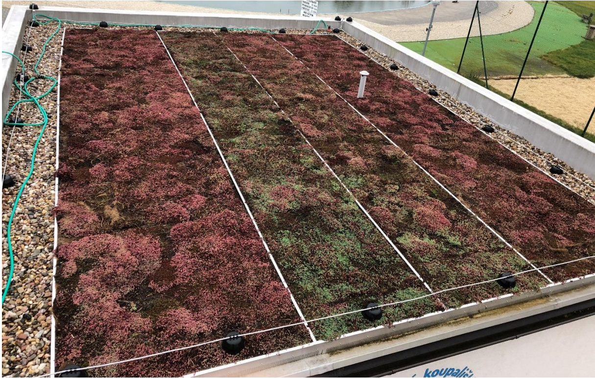
Obrázek 46: Pohled na hotovou ZS po 2 měsících od realizace, foto Jan Mikeš (technické služby Třešť), 23.11.2020
