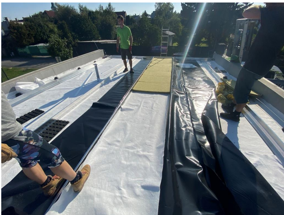
Obrázek 43: Realizace ZS Třešť – spodní vrstvy ZS (ochranná geotextílie hydroizolace, kačírkové lišty, hydroizolační kořenovzdorná fólie pro oddělení experimentálních ploch ZS, geotextílie, hydrofilní minerální vata)
