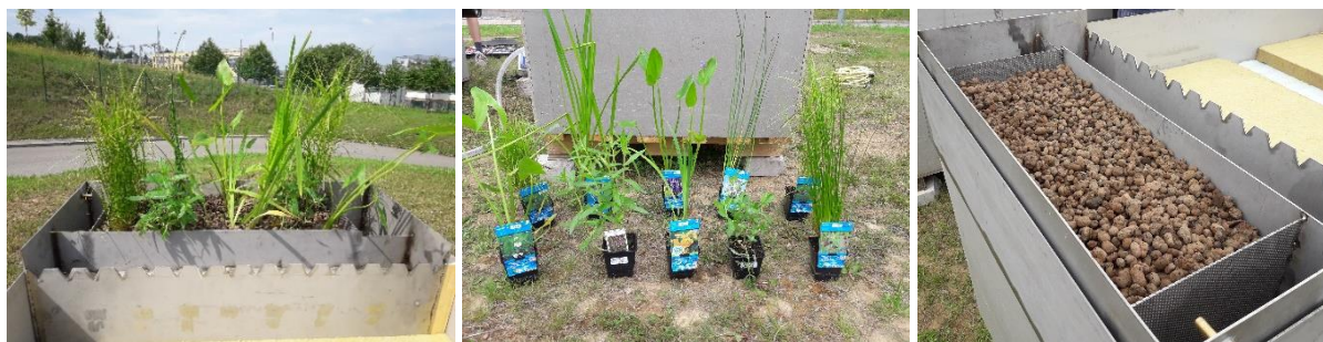
Obrázek 21: Umělý mokřad v průběhu instalace
