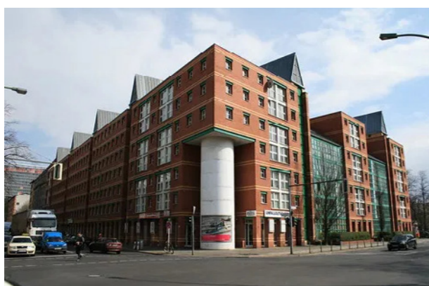
Block 10 (Aldo Rossi, Kochstrasse, Wilhelmstrasse)
