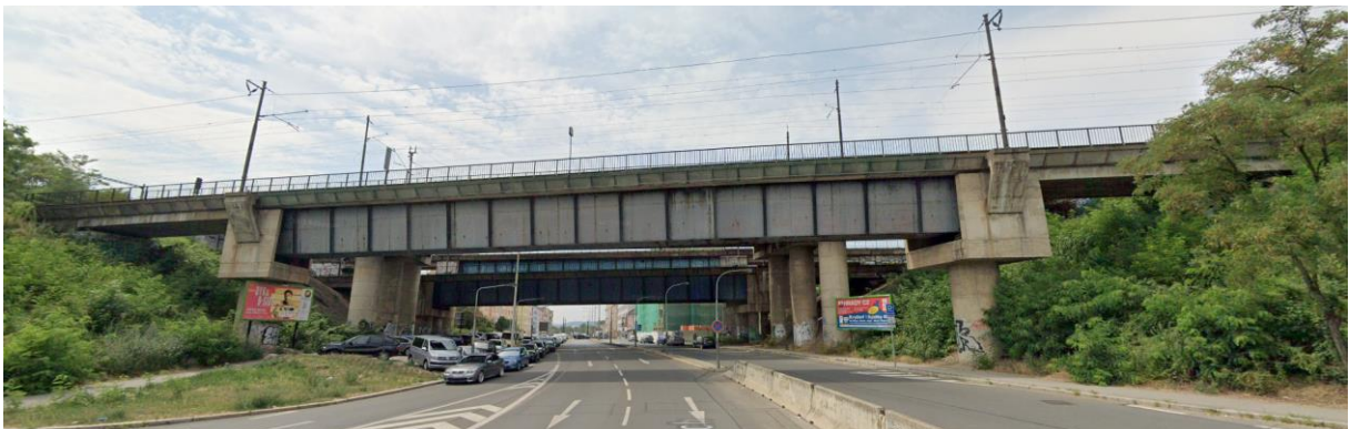
Obr. 19: Pohled na aktuální stav místa přemostění [27]
