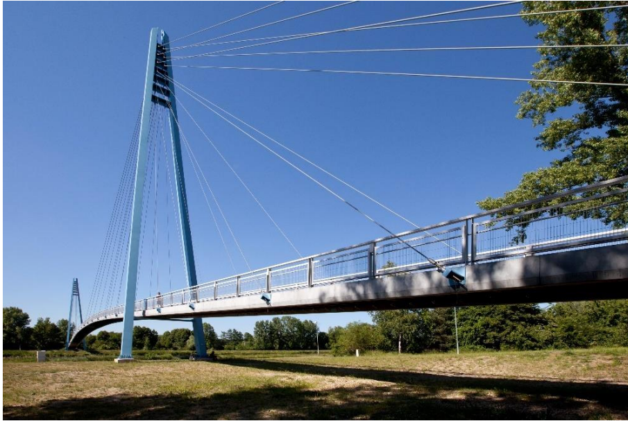
Obr. 13: Lávka v Čelákovících [20]
