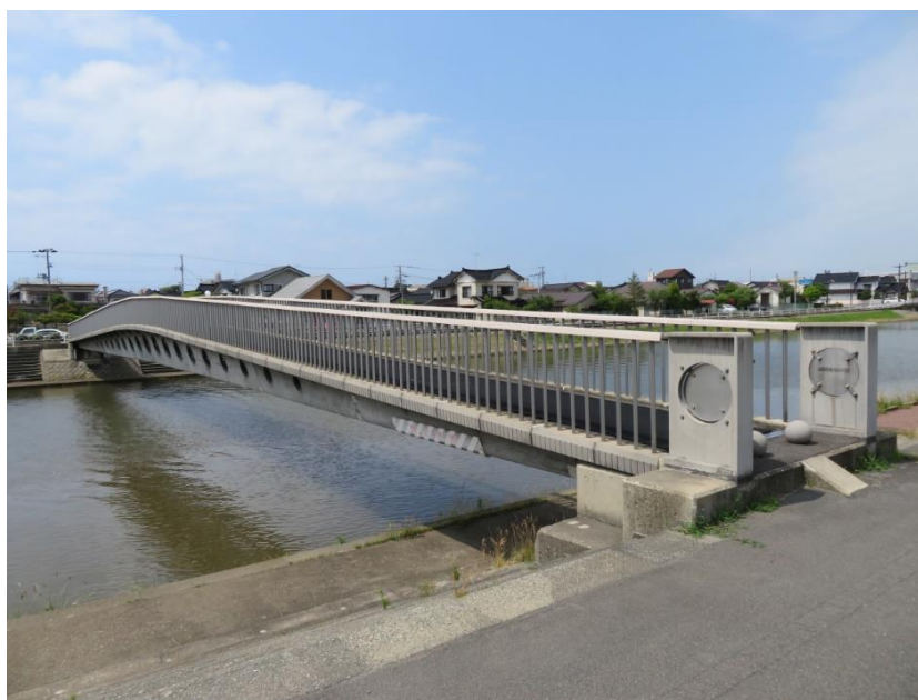
Obr. 11: Pohled na lávku Sakata-Mirai [4]
