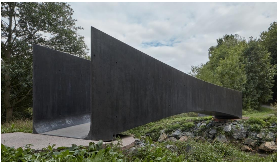
Obr. 14: Lávka přes Dřetovický potok [22]
