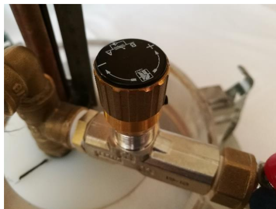
Obrázek 16: Jemný ventil pro regulaci tlaku v systému
