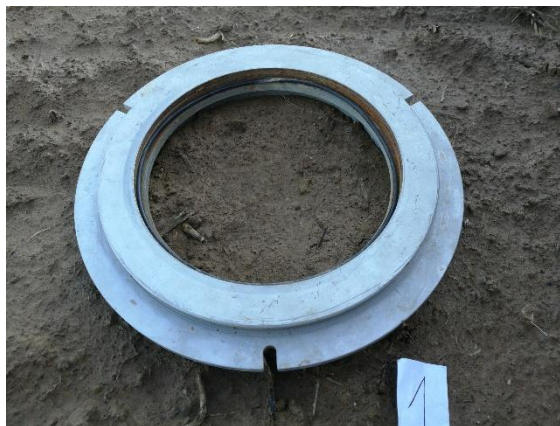
Obrázek 34: Osazení základového prstence
