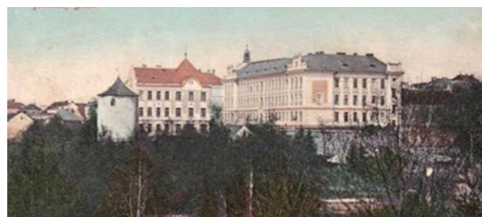
029 Štáflova bašta, základní škola Štáflova dobová pohlednice
