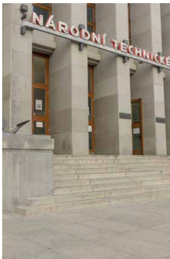
autor: architekt Milan Babuška zdroj: https://heviditelnypes.lidovky.cz/architekt/architektura-dvojcata-na-letne.A170214_223435_p_architekt_wag autor: Aneta Hlaváčková
