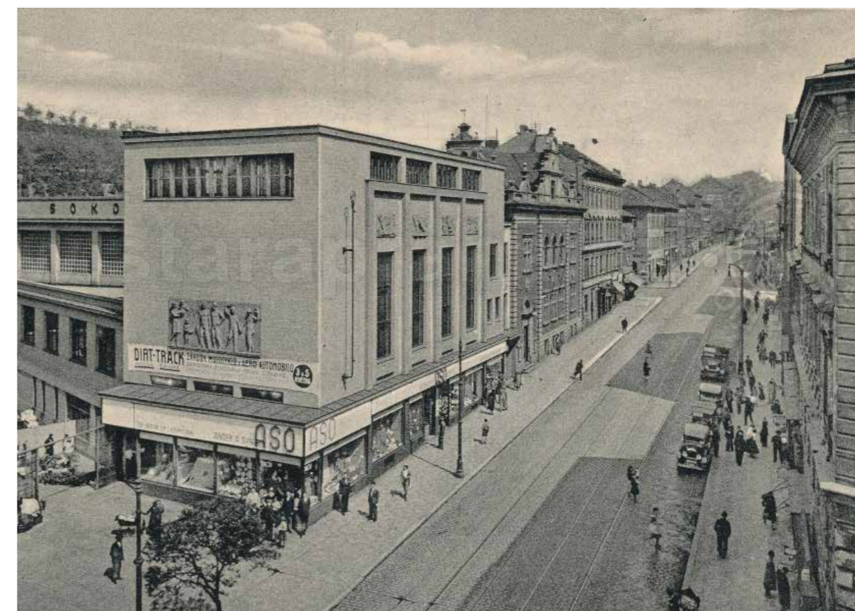
Poděbradova třída | © EPOQUE 1900, spol. s r.o. 2012, all rights reserved
