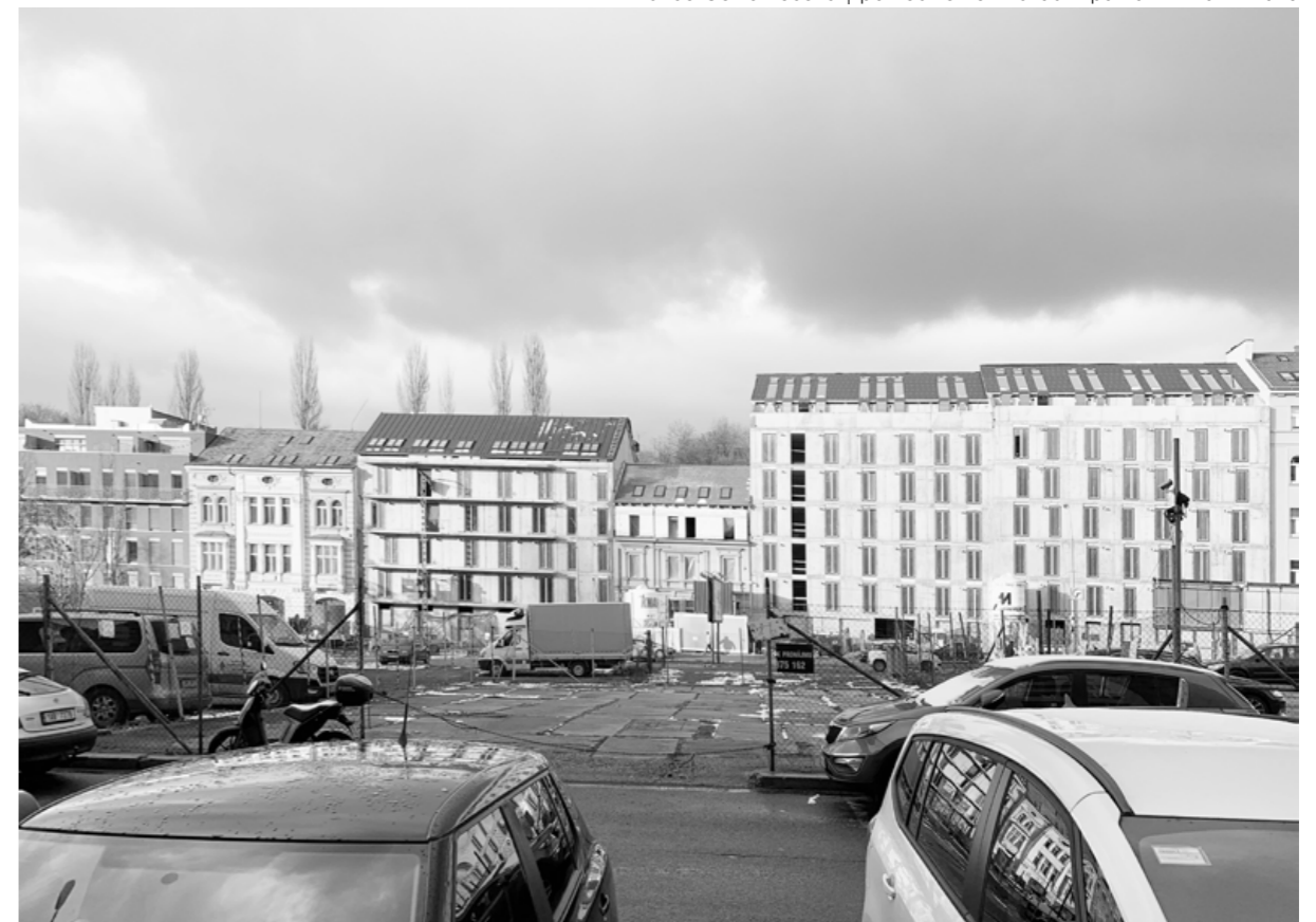
ulice Roháčova | pohled na nově vznikající projekt Žižkovské pavlače
