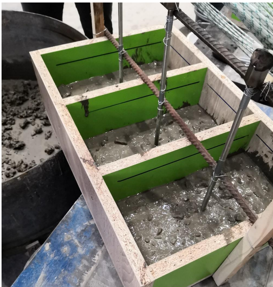
obr. 32 - Vyplnění a vibrování betonové směsi do bednicího dílce na požadovanou výšku
