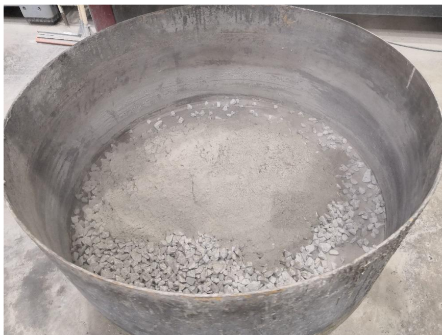
obr. 30 - Postupné nasypání suché směsi do míchačky od nejhrubšího kameniva po nejjemnější s následným zasypáním cementu
