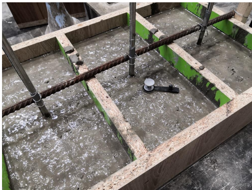
obr. 33 - Po dosažení požadované výšky betonového vzorku bylo ponořeno plastové pouzdro hygropinu
