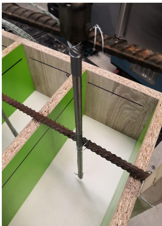
obr. 25 - Detail upevnění korozivzdorné trubičky pomocí žebříku z betonářské výztuže k bednicím dílcům
