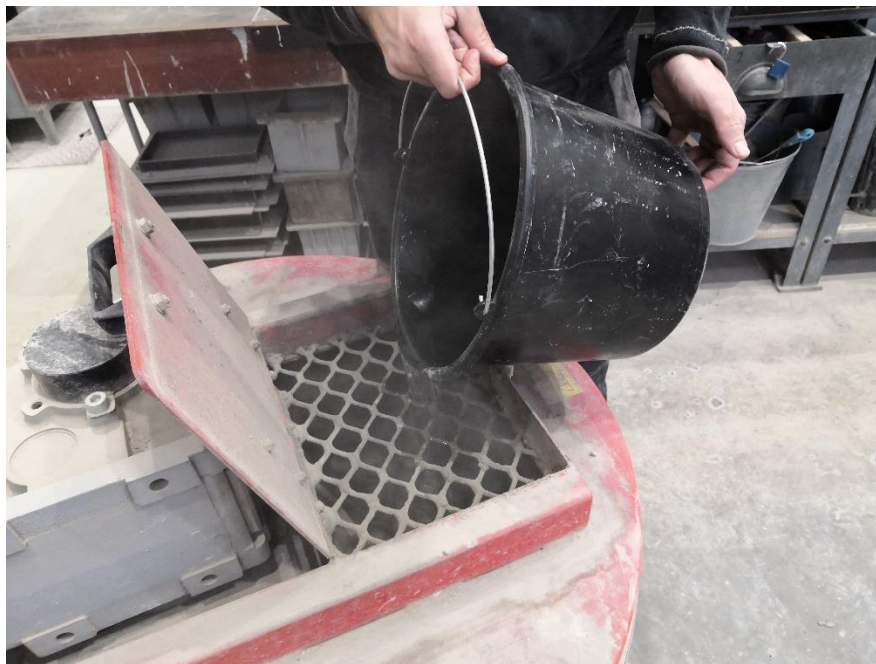
obr. 31 - Vlévání vody do míchačky s přidáním plastifikátorem a provzdušňovačem betonu
