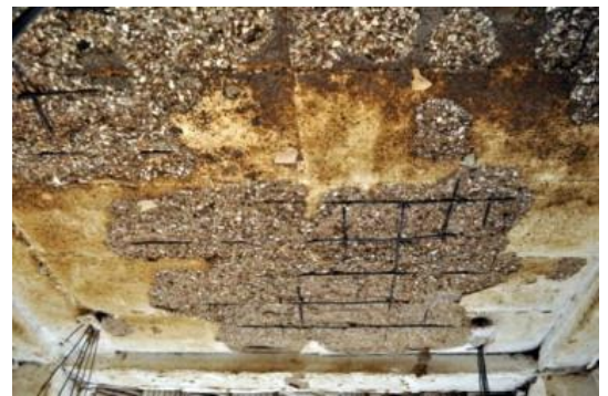
Obr. 21: (A) Schéma prostoru zatíženého požárem; (B) Stropní deska po požáru. Převzato z [22]
