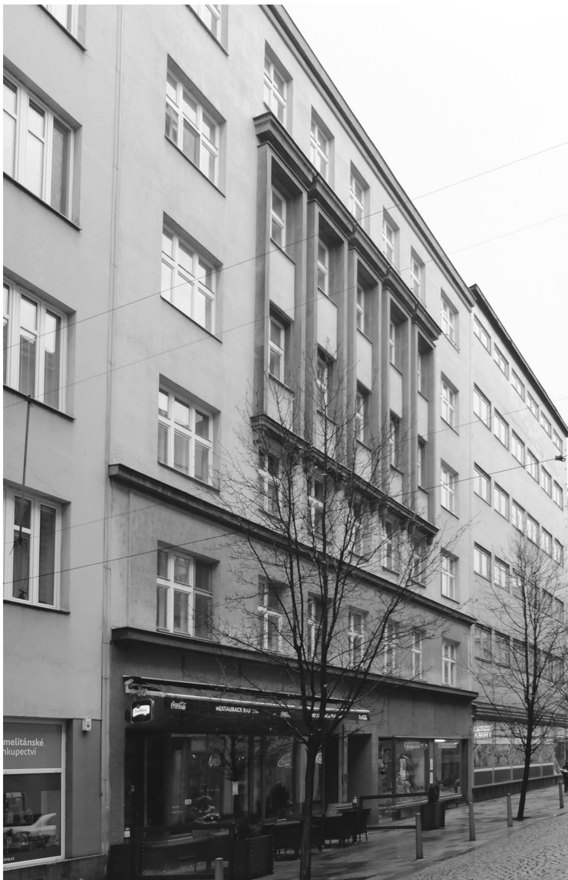
obr. 26 - Bytový dům Puchmajerova 1919/8 v Moravské Ostravě
