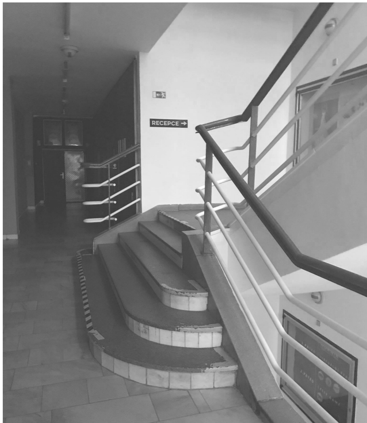
obr. 30 - Současný stav schodiště v řešeném obchodním domě.
