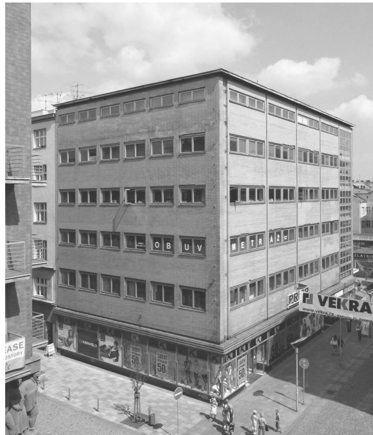
obr. 31 - Řešený obchodní dům na fotce z roku 2009, fasáda ještě bez výrazného poškození.
