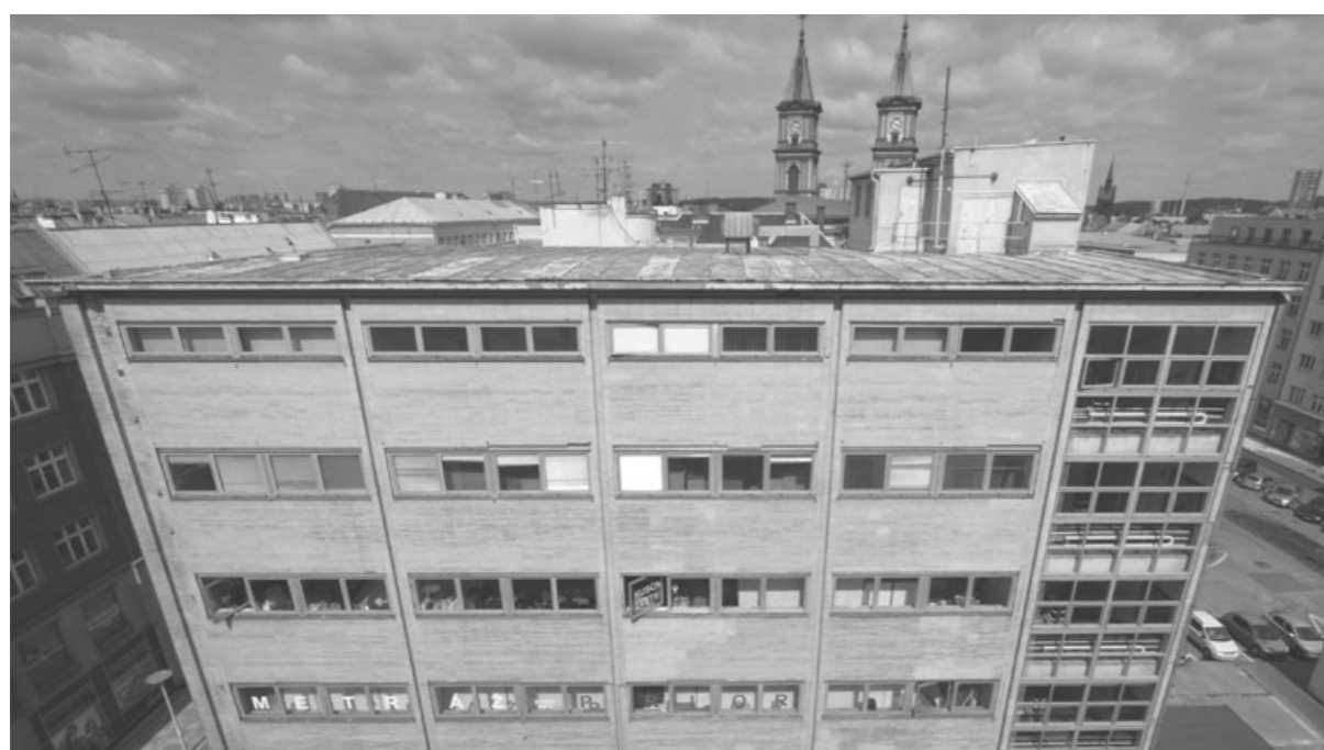
obr. 33 - Nadhledová fotografie řešeného obchodního domu
