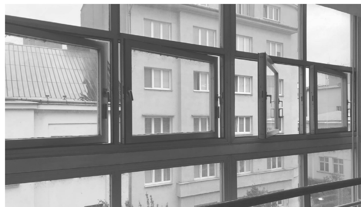
obr. 35 - Detail aktuálních okenních rámců na schodišti.
