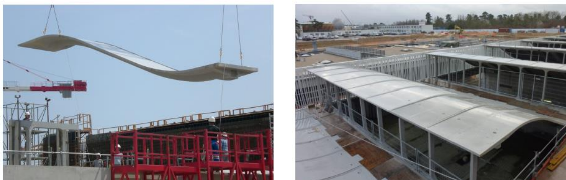
Obr. 32 Zastřešení nádrže biologického čištění odpadní vody, zdroj: [36]
