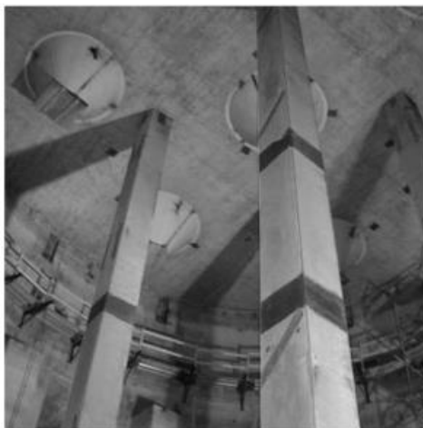
Obr. 36 Sloupy ve skladišti cementu Detroit, [7]
