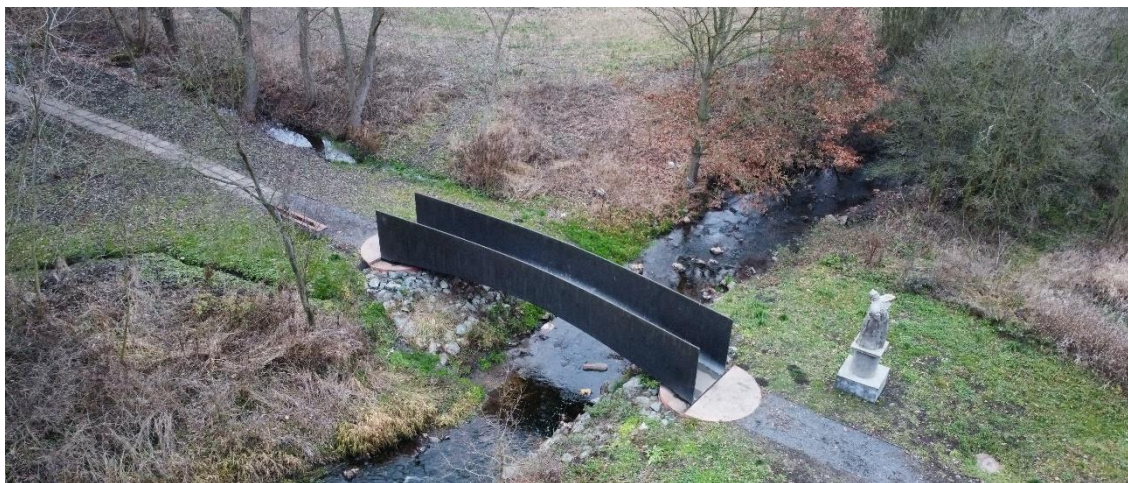
Obr. 24 Lávka přes Dřetovický potok ve Vrapicích u Kladna, zdroj: fotoarchiv autora
