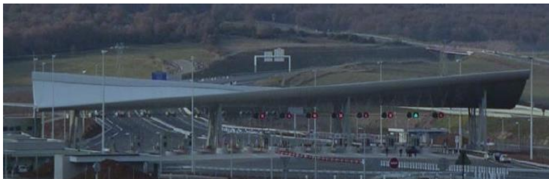
Obr. 35 Zastřešení mýtné brány viaduktu Millau, Francie [7]
