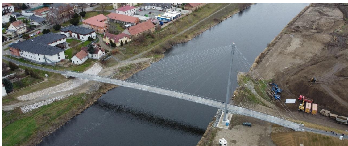
Obr. 25 Lávka přes Vltavu v obci Lužec nad Vltavou, zdroj: fotoarchiv autora
