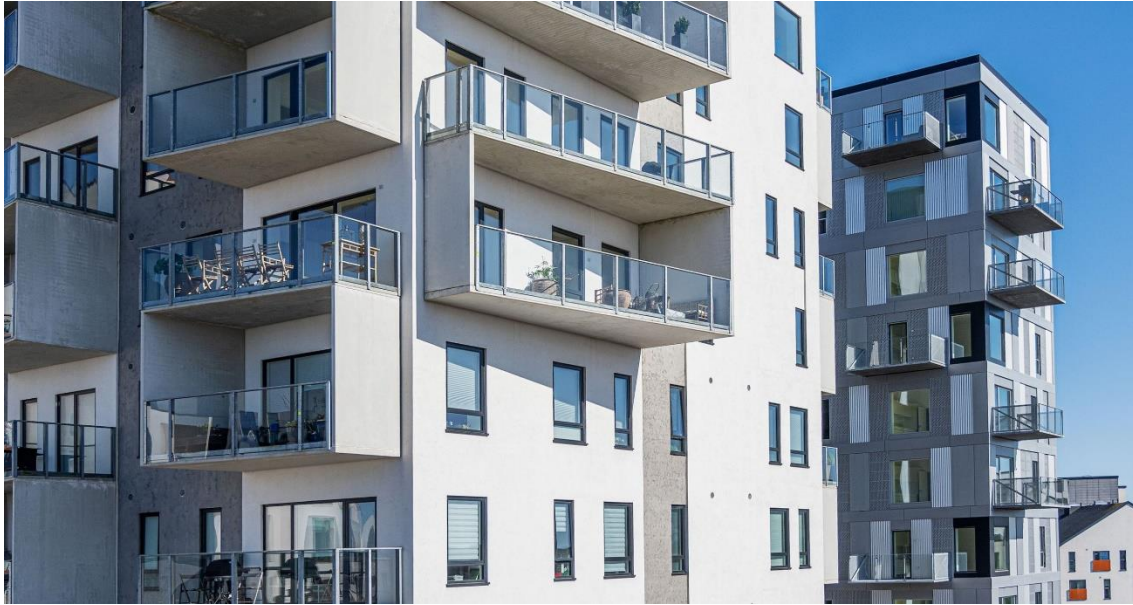
Obr. 38 Předsazené konstrukce z UHPC, zdroj: [64]
